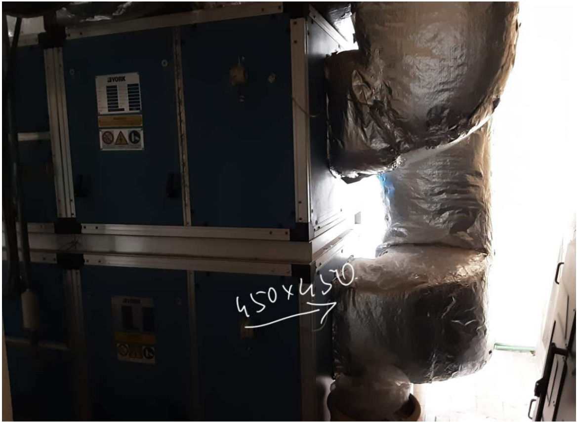
Фото 7. Сечения существующих воздуховодов воздухораспределительной сети составляет 450×450 мм.
