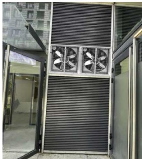
Вентилятор осевой YWF 6E-630 с настенной панелью
