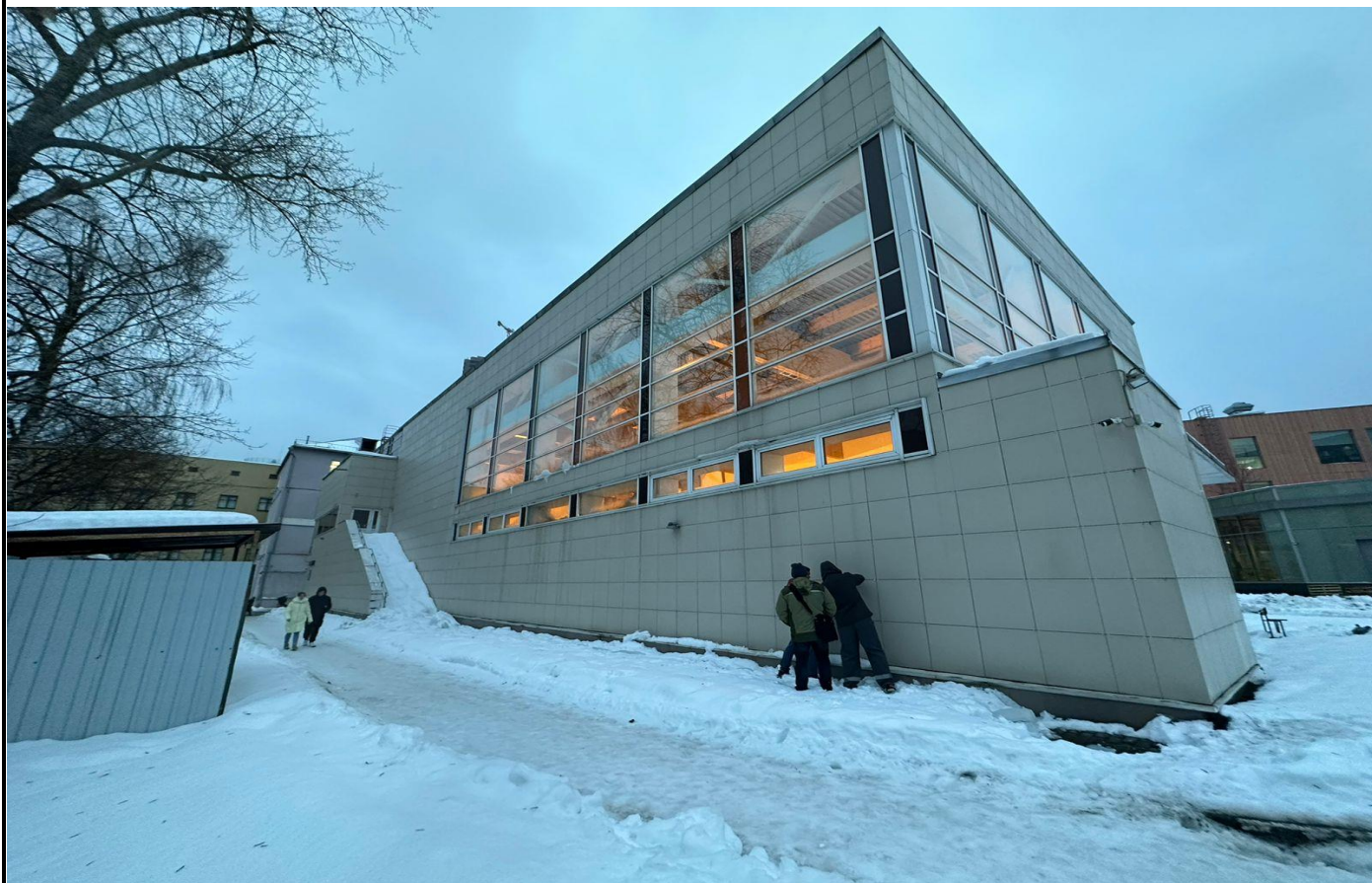
Фото 65. Фасад. Контрольное вскрытие вент.фасада
