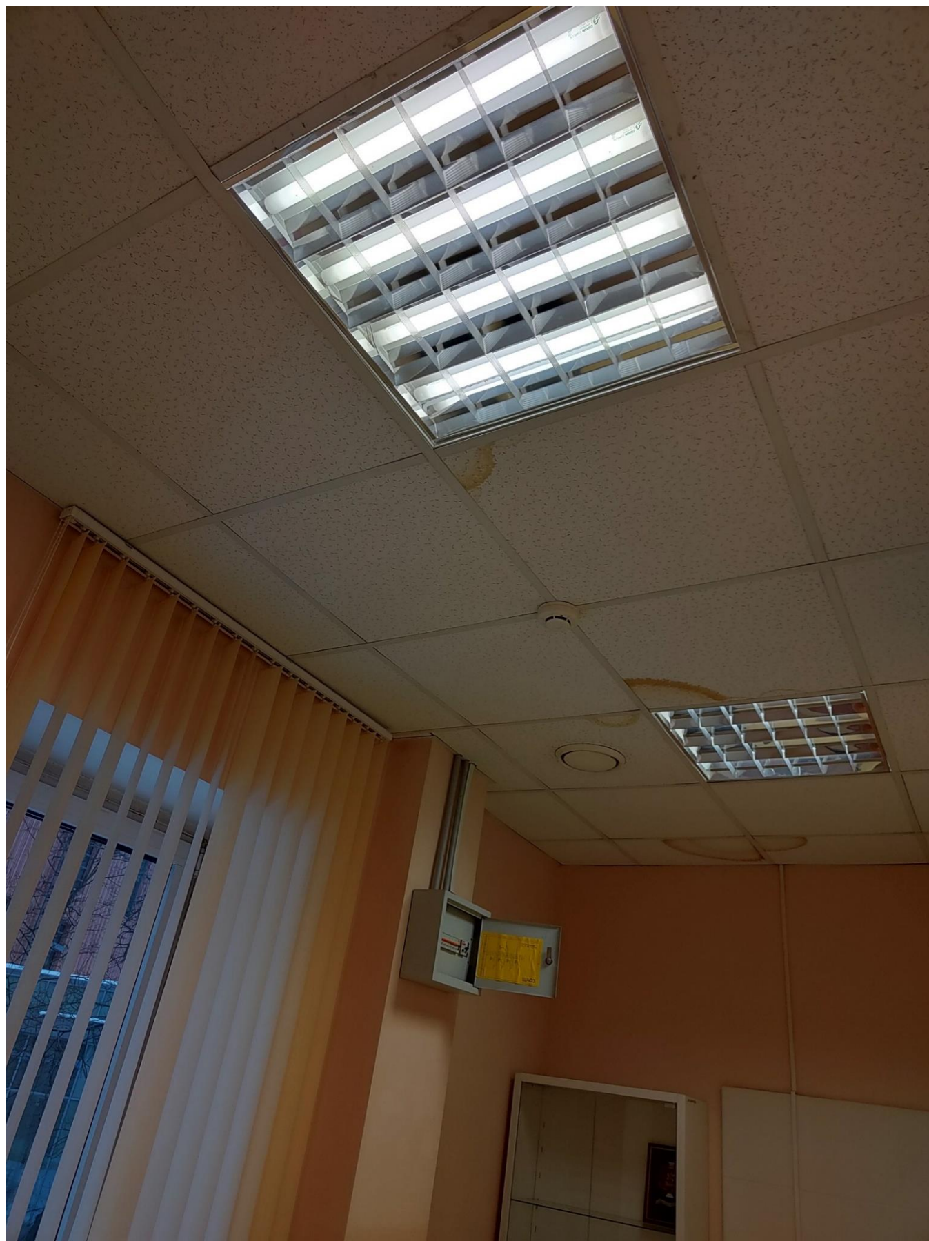
Фото 55. Следы залива осветительных электроприборов.
