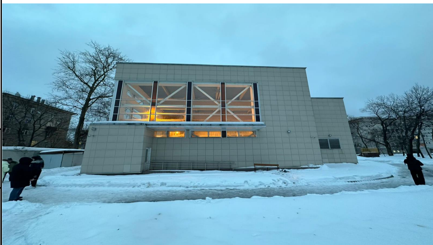
Фото 64. Фасад. Задняя часть фасада
