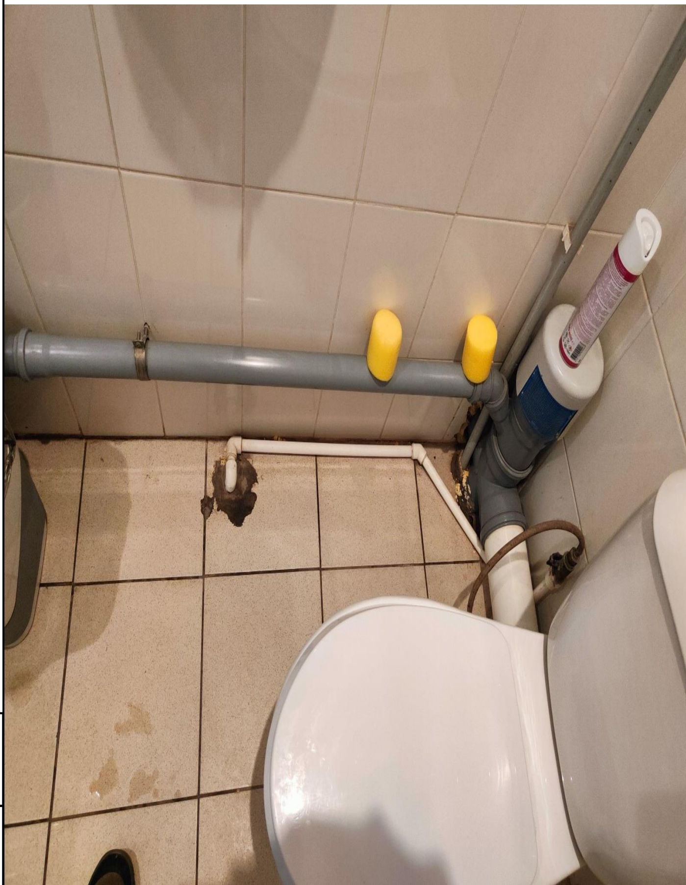
Фото 49. Открытая прокладка по полу трубопроводов ХВС в сан. узлах.
