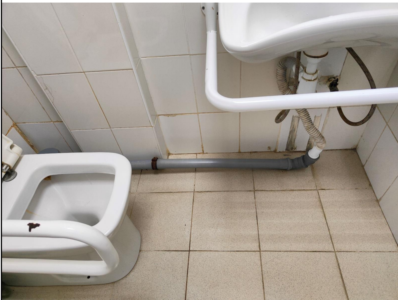
Фото 46. Прокладка трубопроводов канализации открыто по полу сан.узла.
