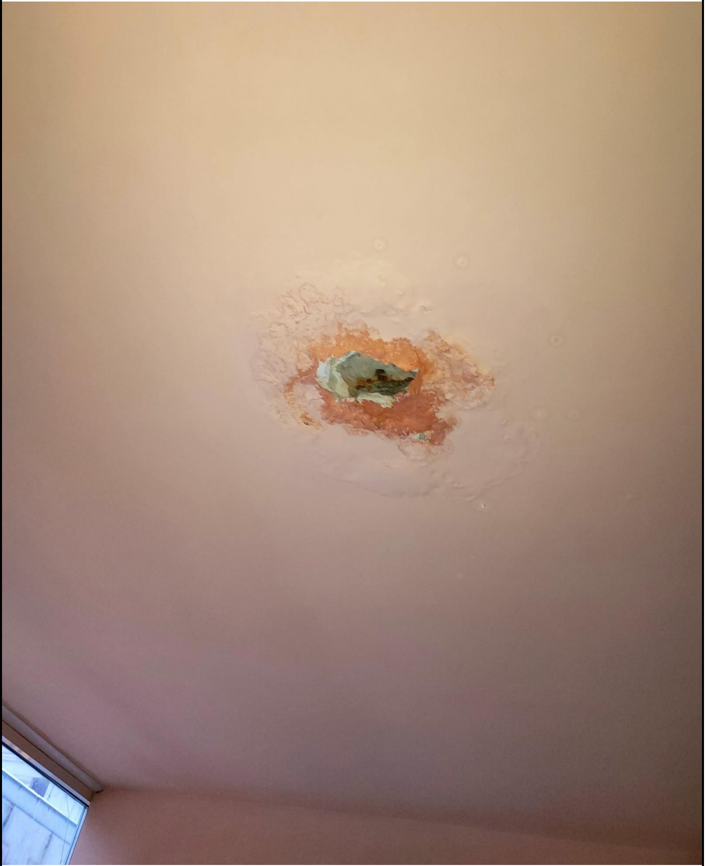
Фото 56. Сквозное крепление через плиту покрытия натяжной штанги ввода СКС на кровле здания.
