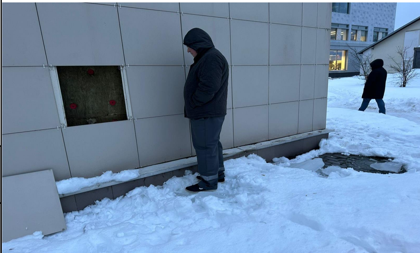
Фото 66. Фасад. Контрольное вскрытие вент.фасада
