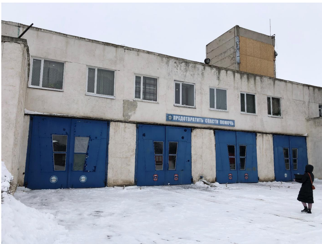
Рисунок 1.2 Общий вид здания со стороны главного фасада.
