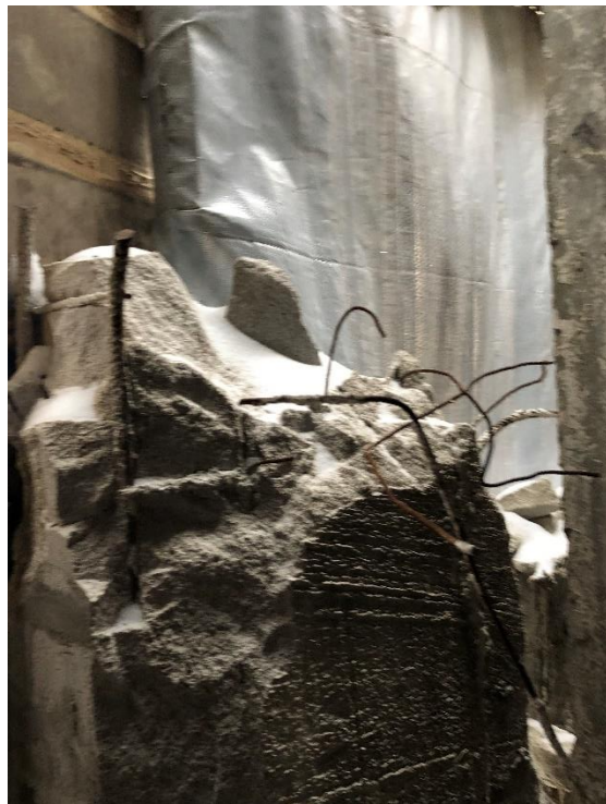
Разрушение колонн
