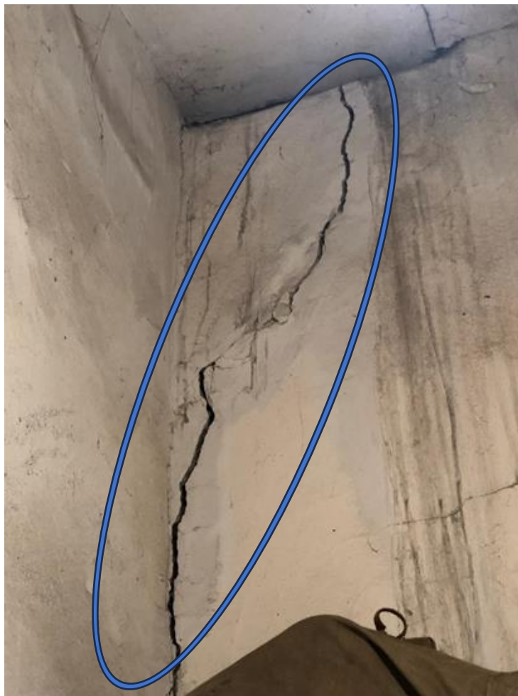
Трещины на внутренней стене здания между осями 1-2 по оси Б в пом.1.12
