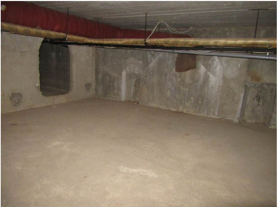
Фото №22. Фрагмент подвального помещения
