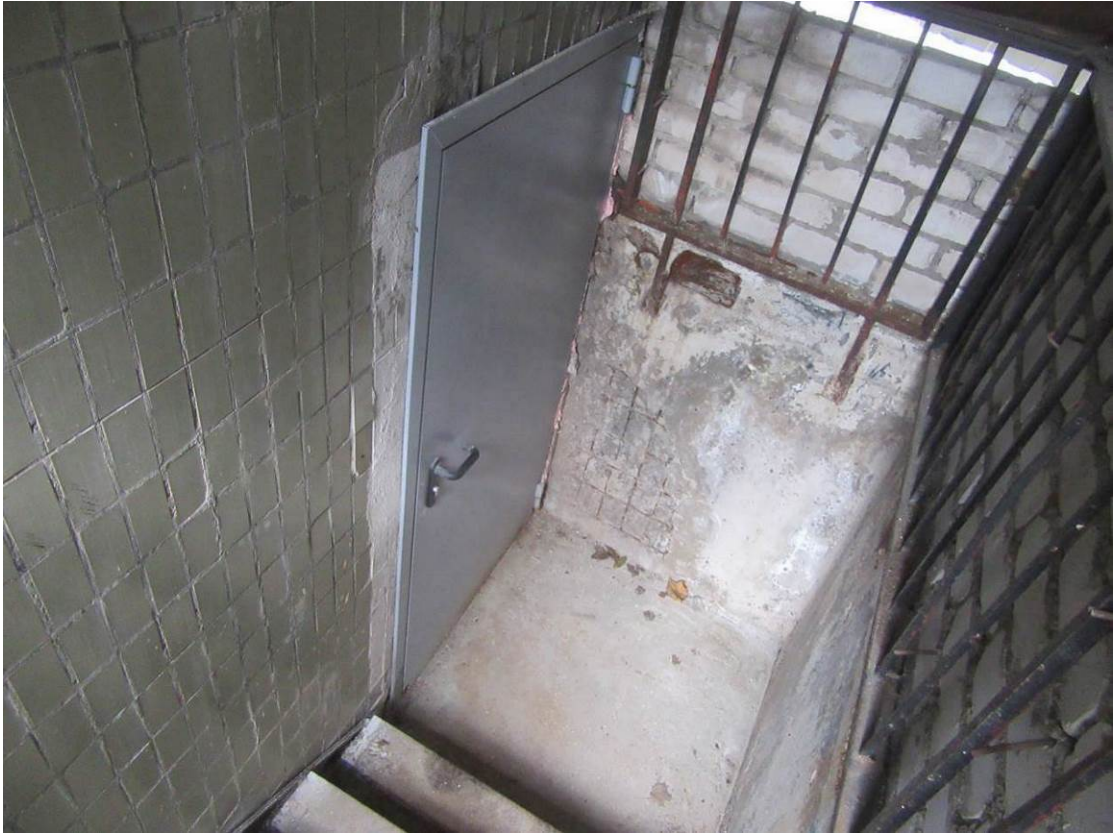
Фото №7. Фрагмент прямка спуска в подвал
