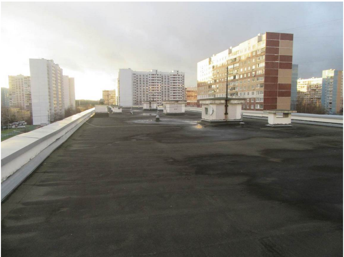
Фото №26. Фрагмент кровли 4-х этажной части
