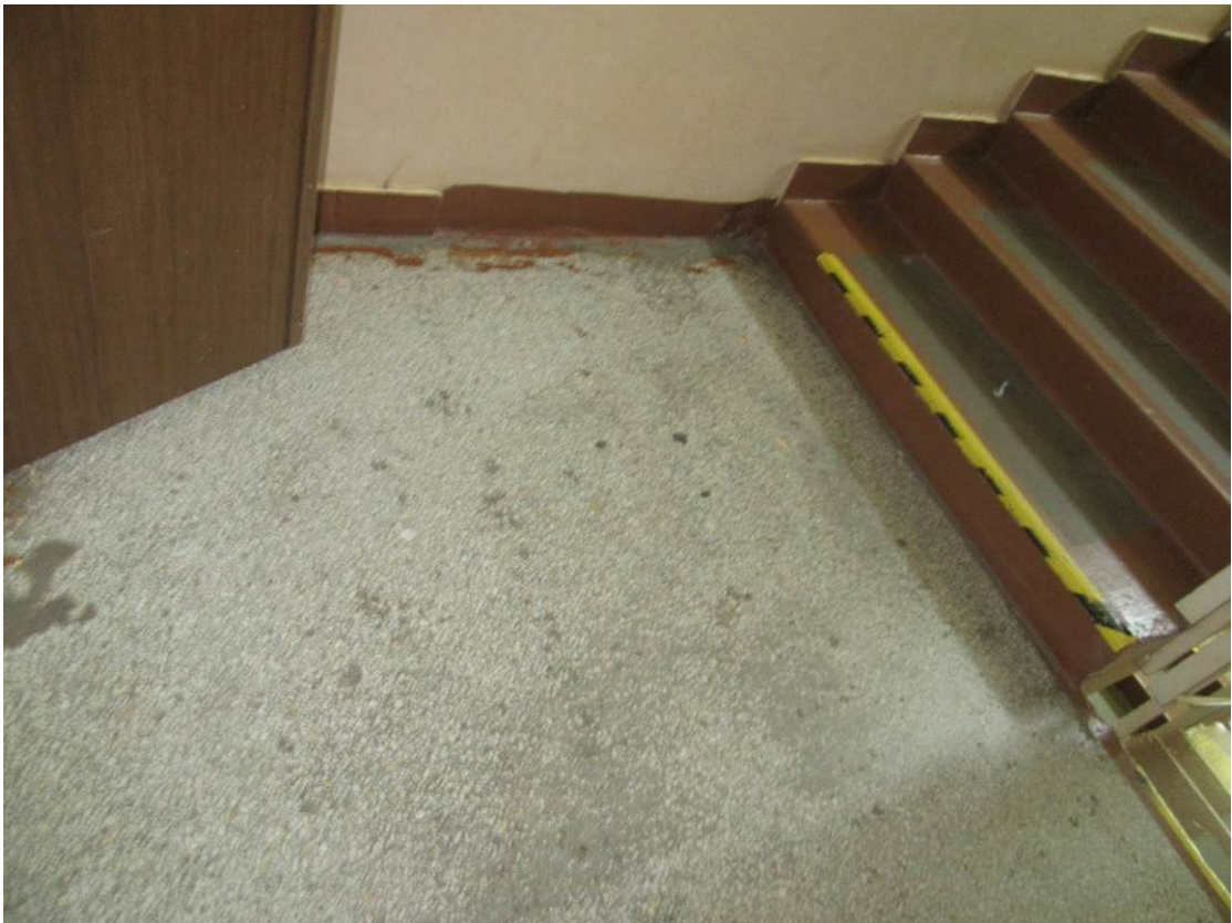
Фото №24. Фрагмент лестницы
