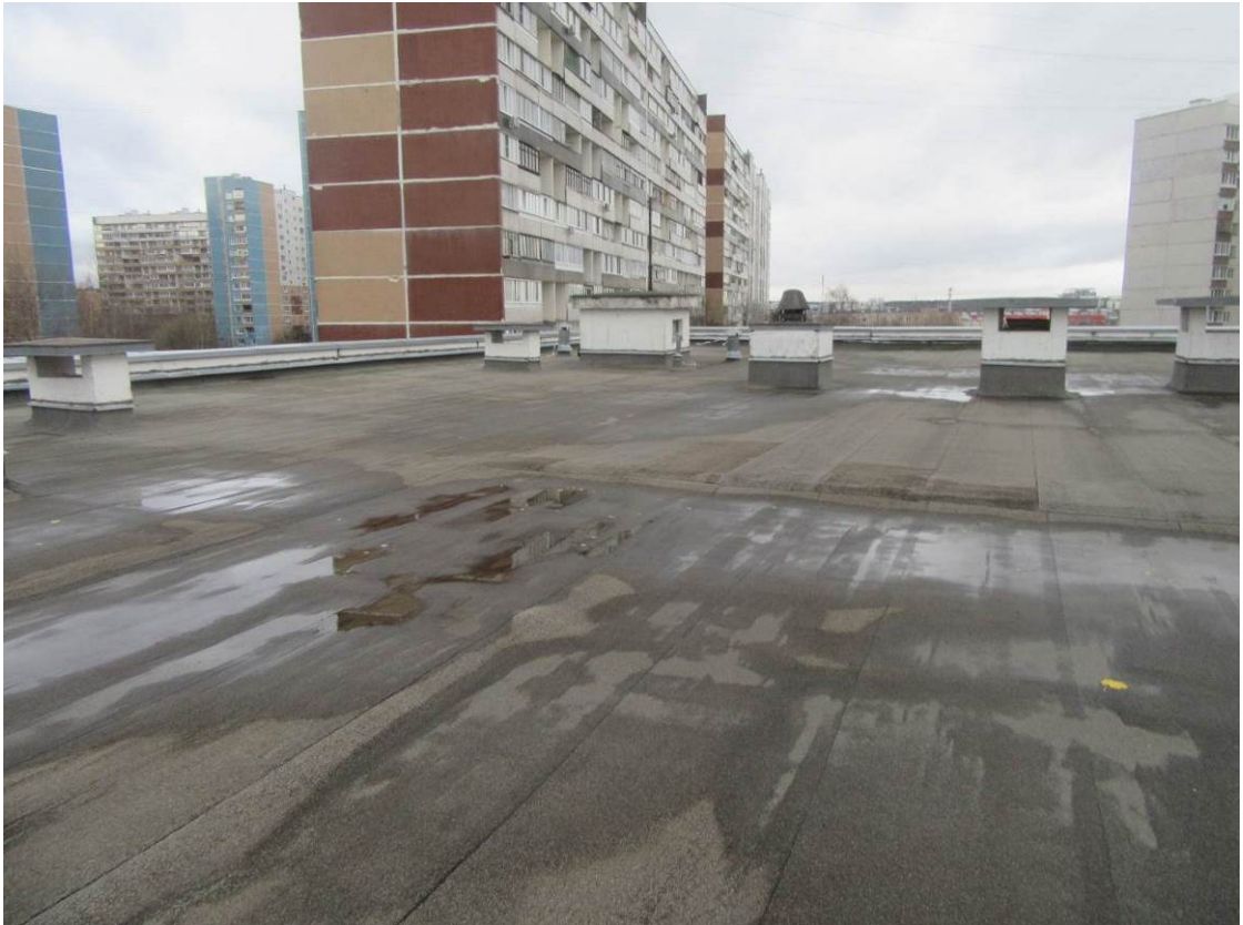
Фото №27. Фрагмент кровли 3-х этажной части
