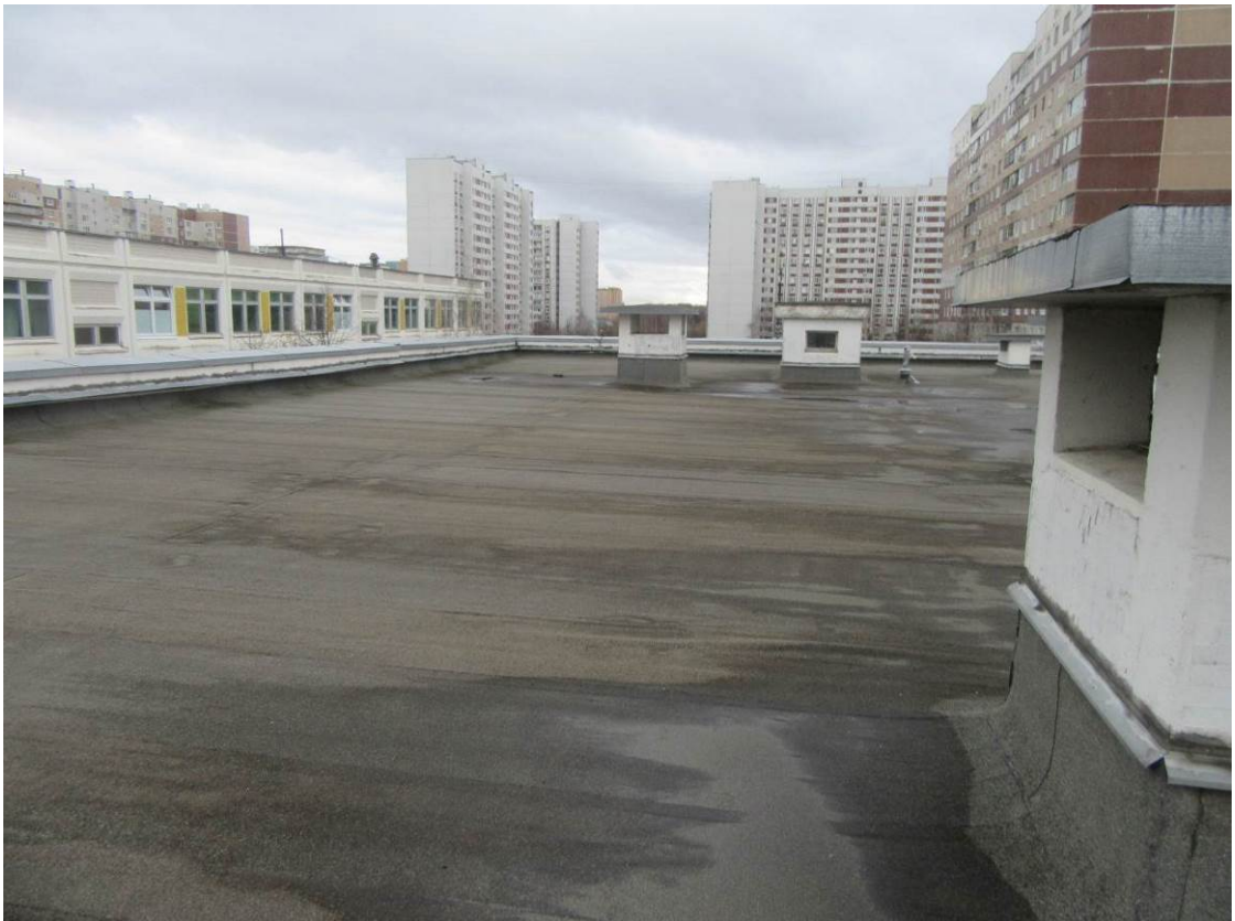
Фото №28. Фрагмент кровли 3-х этажной части
