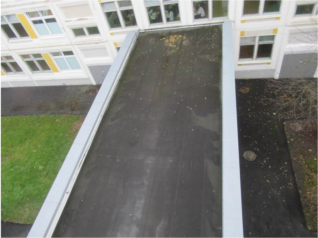
Фото №29. Вид на кровлю одноэтажной части
