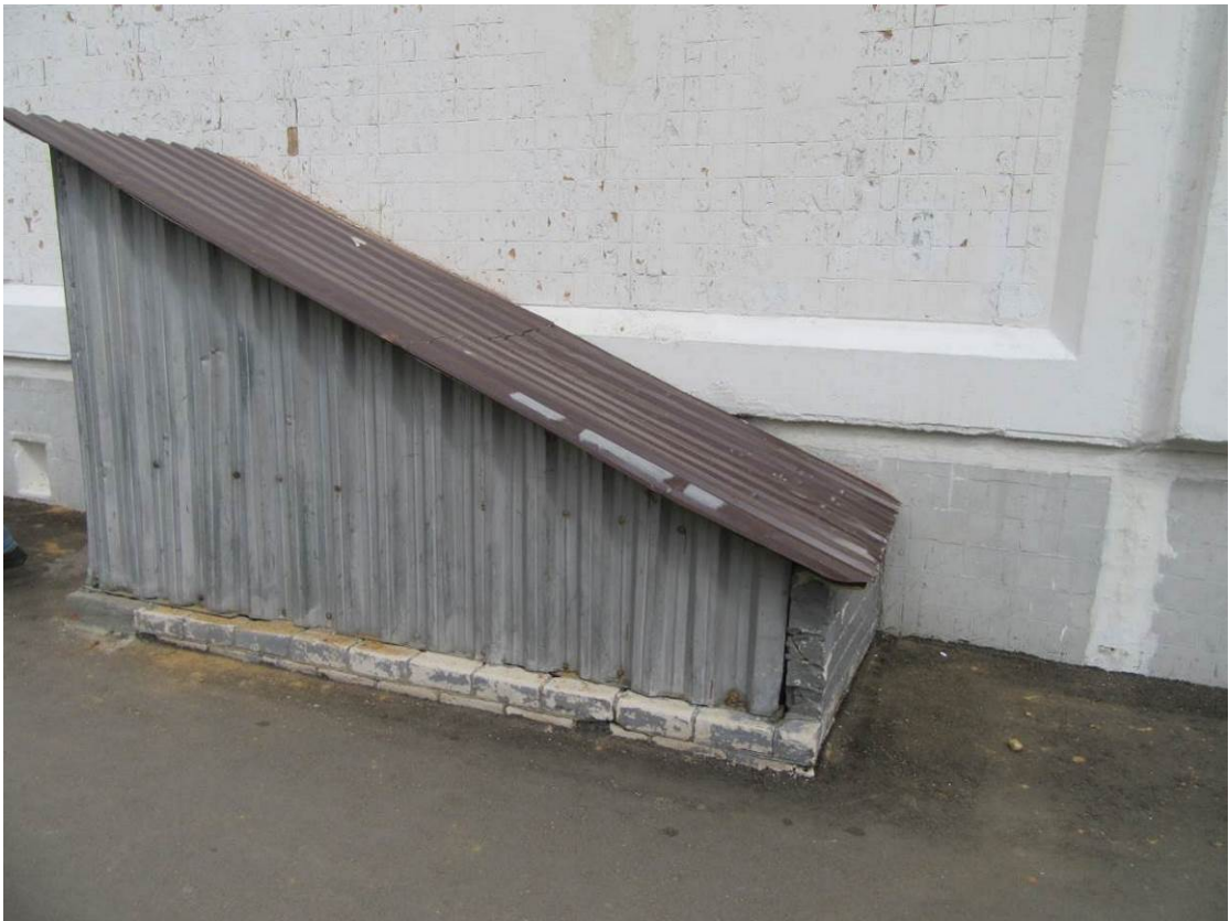
Фото №8. Вид прямка спуска в подвал
