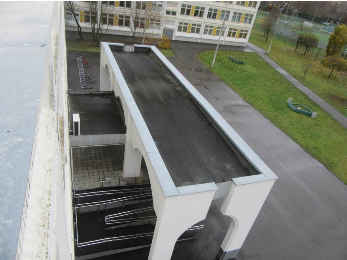
Фото №30. Вид на кровлю главной входной группы
