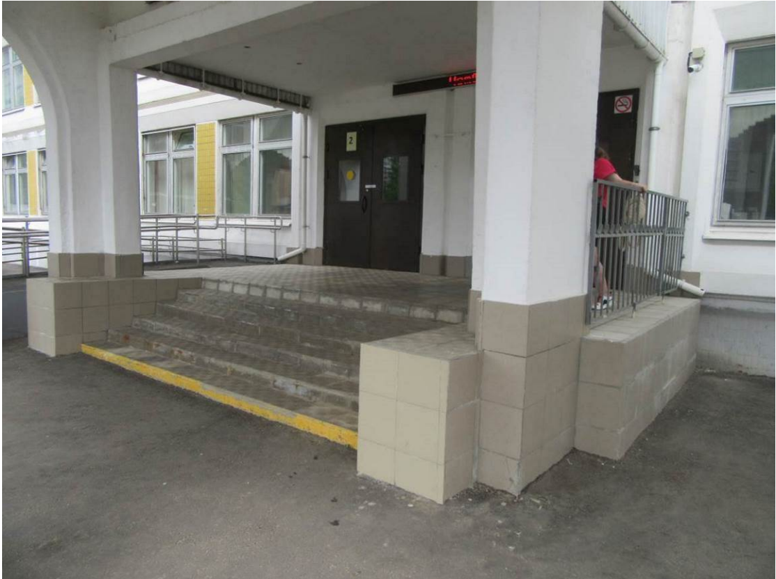
Фото №9. Вид крыльца главного входа
