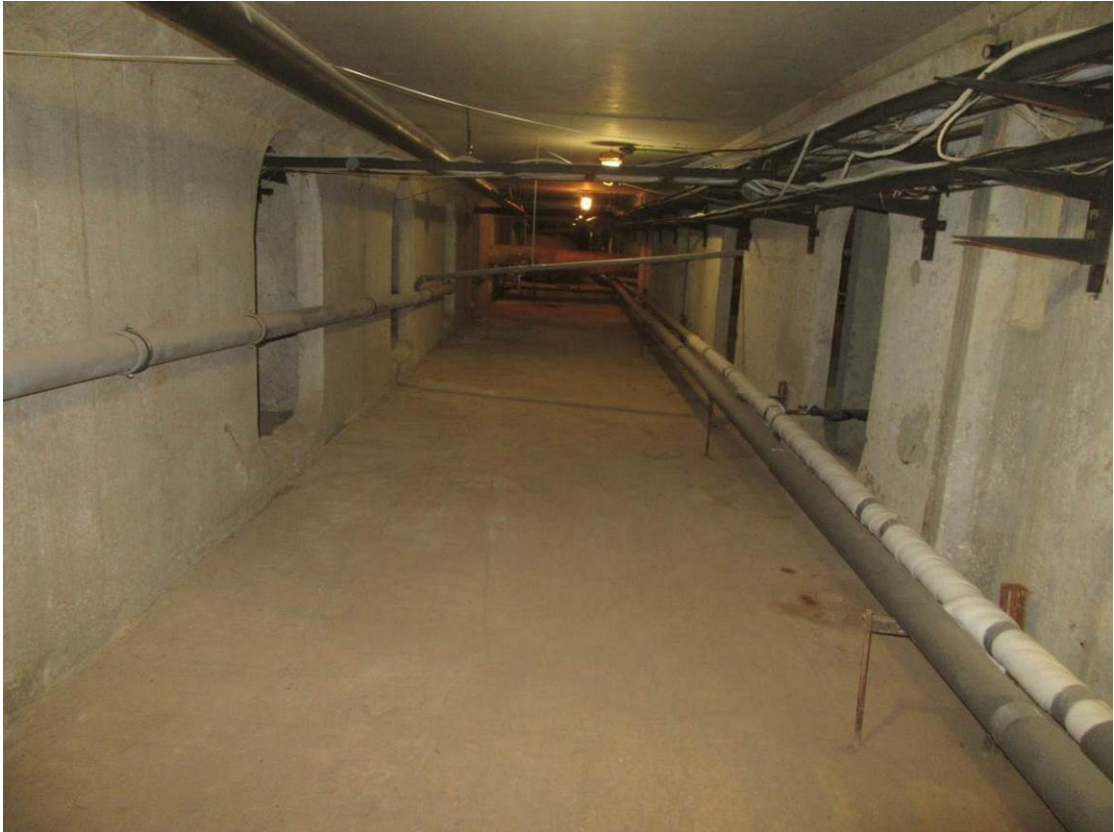
Фото №23. Фрагмент подвального помещения
