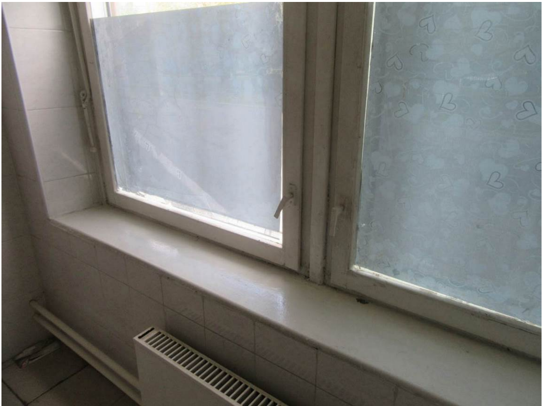
Фото №18. Фрагмент оконного заполнения
