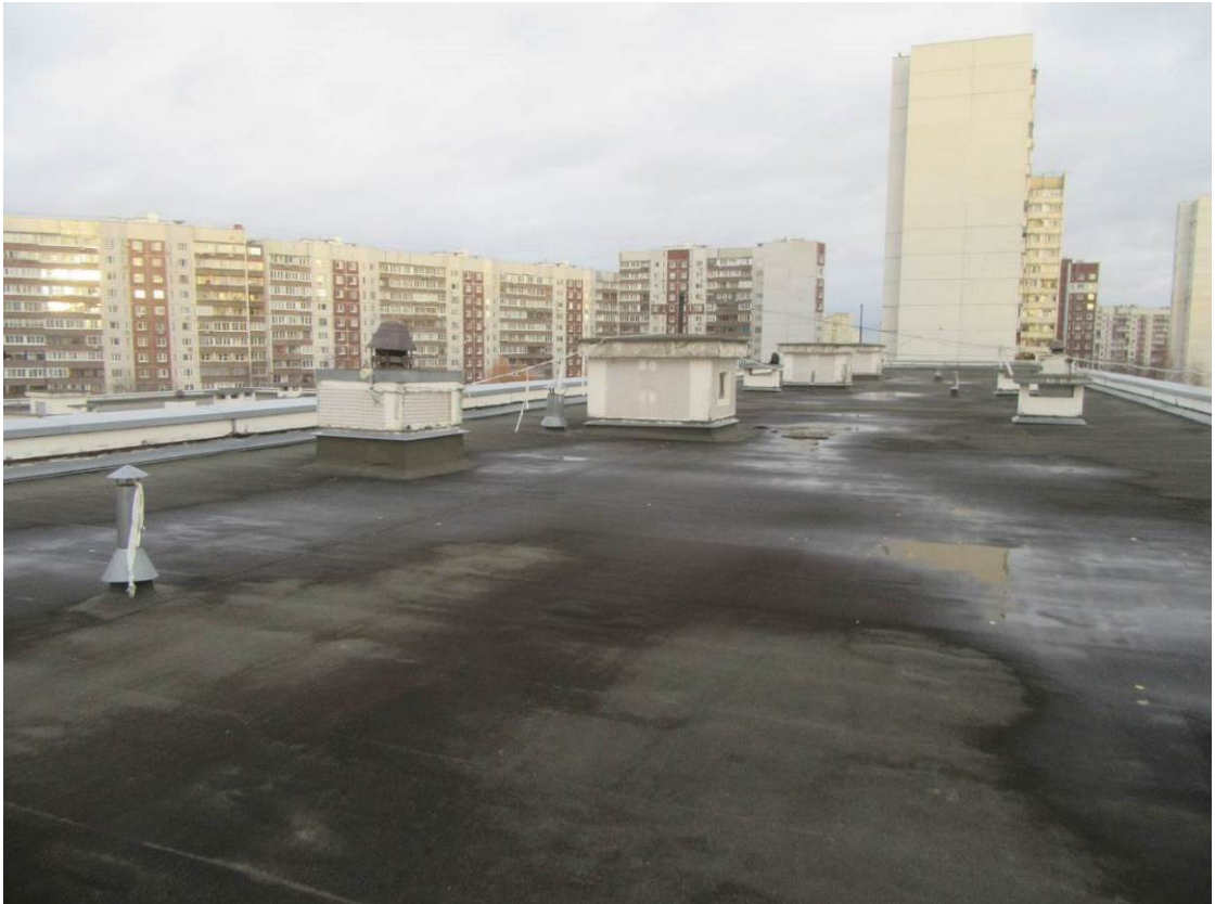
Фото №25. Фрагмент кровли 4-х этажной части
