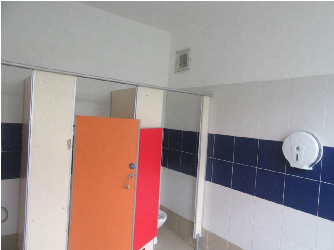
Фото №14. Фрагмент помещения санузла
