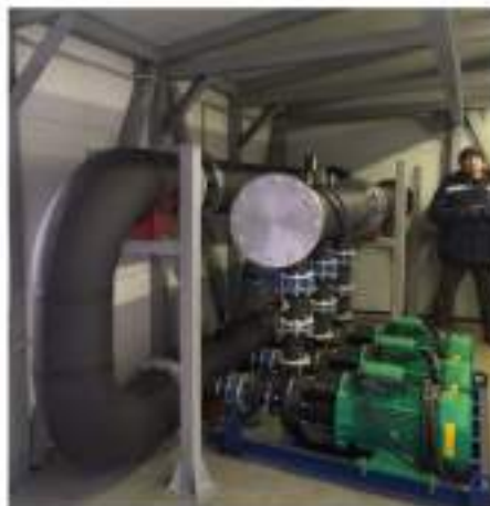
Перекачивающая насосная станция на тепловой сети Абаканской ТЭЦ г. Абакан
