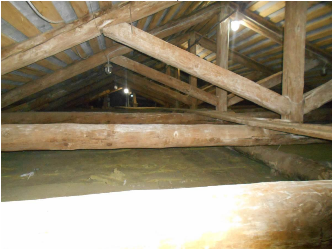
Рис П5.30. Стропильная система
