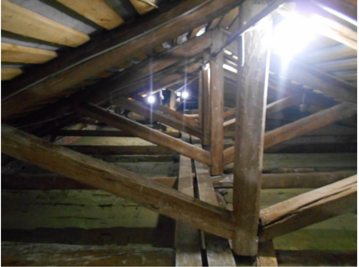
Рис П5.29. Общий вид стропильной системы
