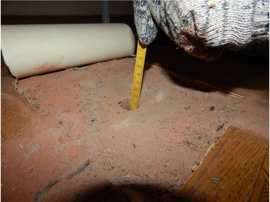
Рис П5.27. Вскрытие №4. Второй этаж. Помещение в осях 5-6/Д-Ж
