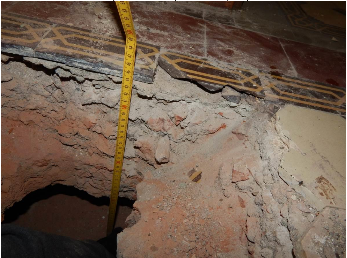
Рис П5.22. Вскрытие №1. Второй этаж. Коридор в осях 4-Е
