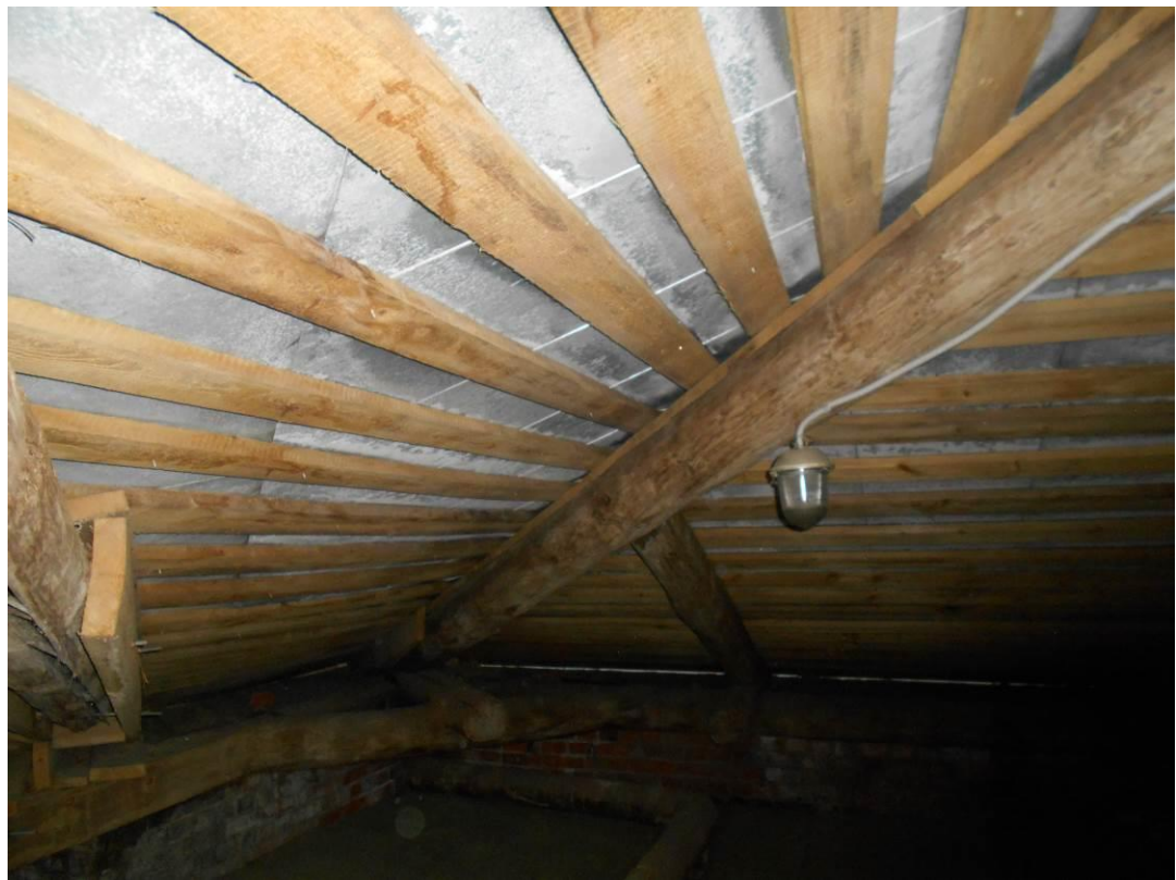
Фото П5.33 Стропильная система кровли здания.
