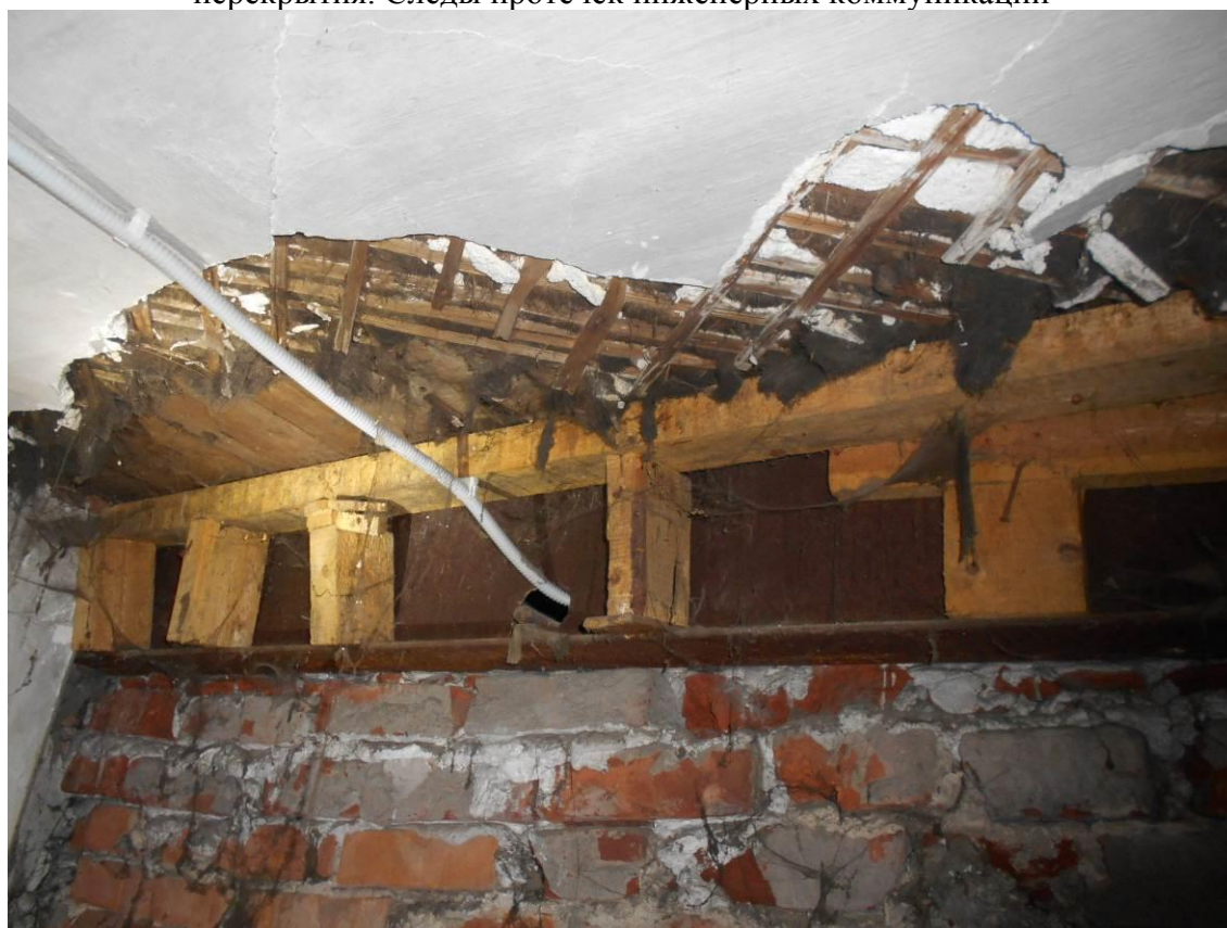
Рис П5.13. Перекрытие подвала в осях 3-4/Г-Е. Гниение и разрушение деревянного перекрытия. Следы протечек инженерных коммуникаций
