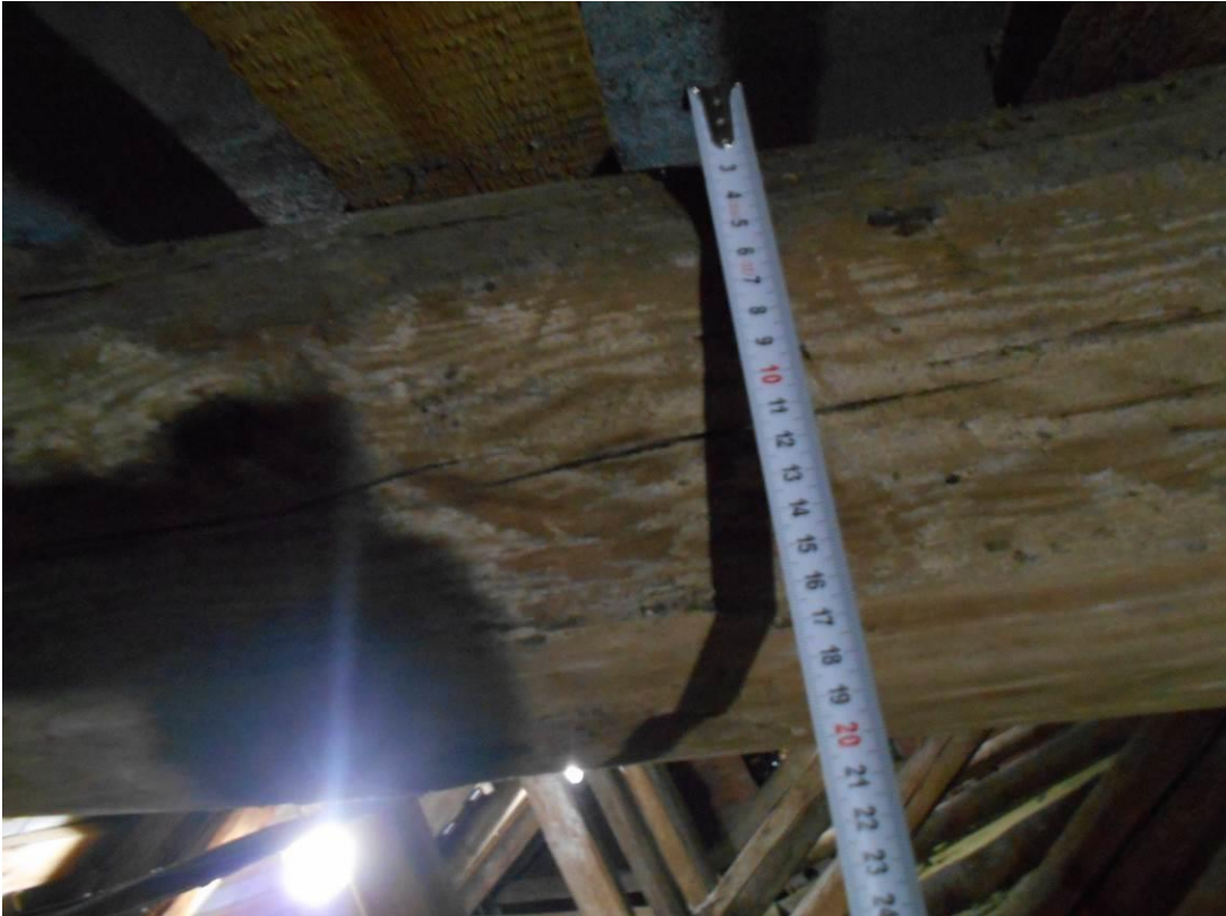
Фото П5.35 Стропильная система кровли здания.
