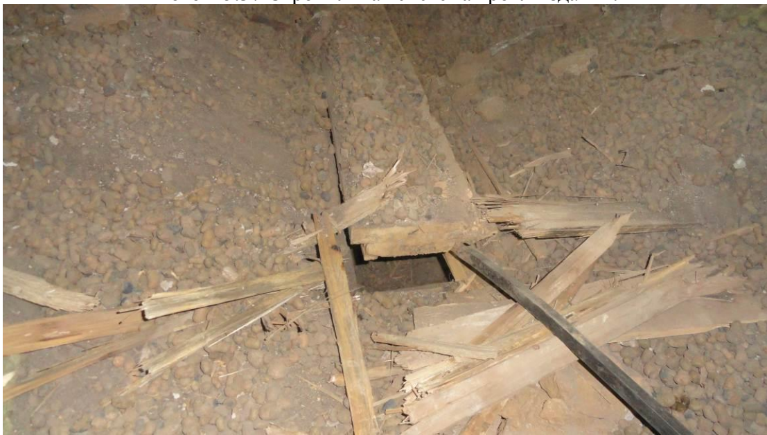
Фото П5.38 Перекрытие над 3-м этажом.
