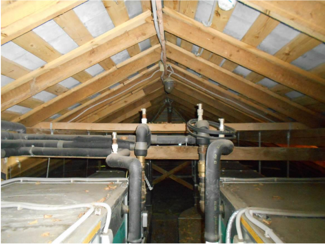
Фото П5.31. Стропильная система кровли здания.
