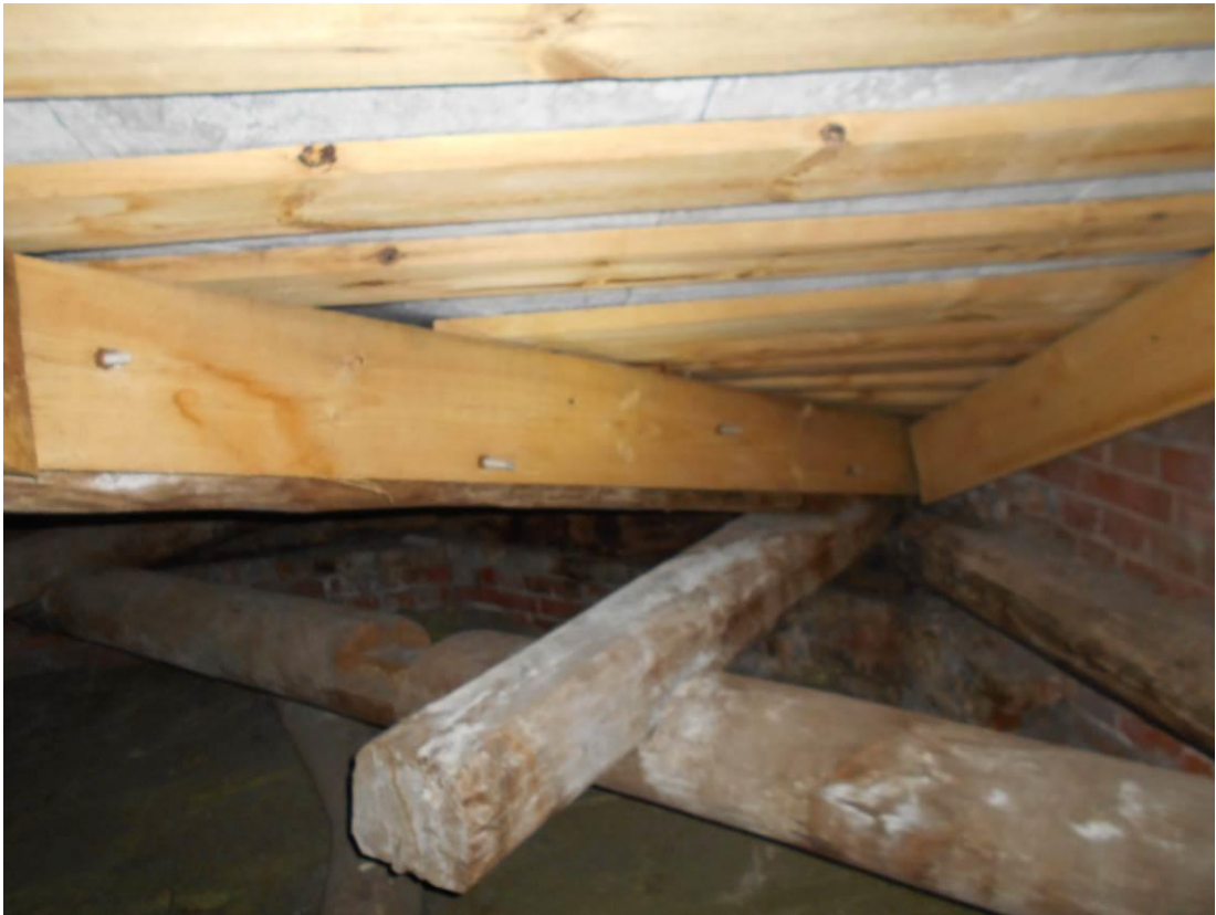
Фото П5.32 Стропильная система кровли здания.
