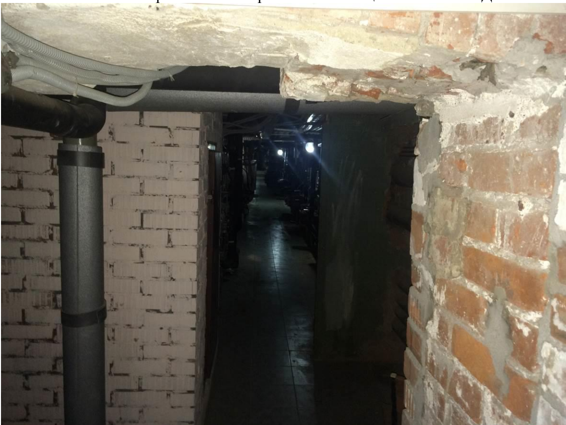
Рис П5.28. Подвал. Фото из помещения в осях 4-5/Г-Д в направлении коридора в осях 5-12/В-Д
