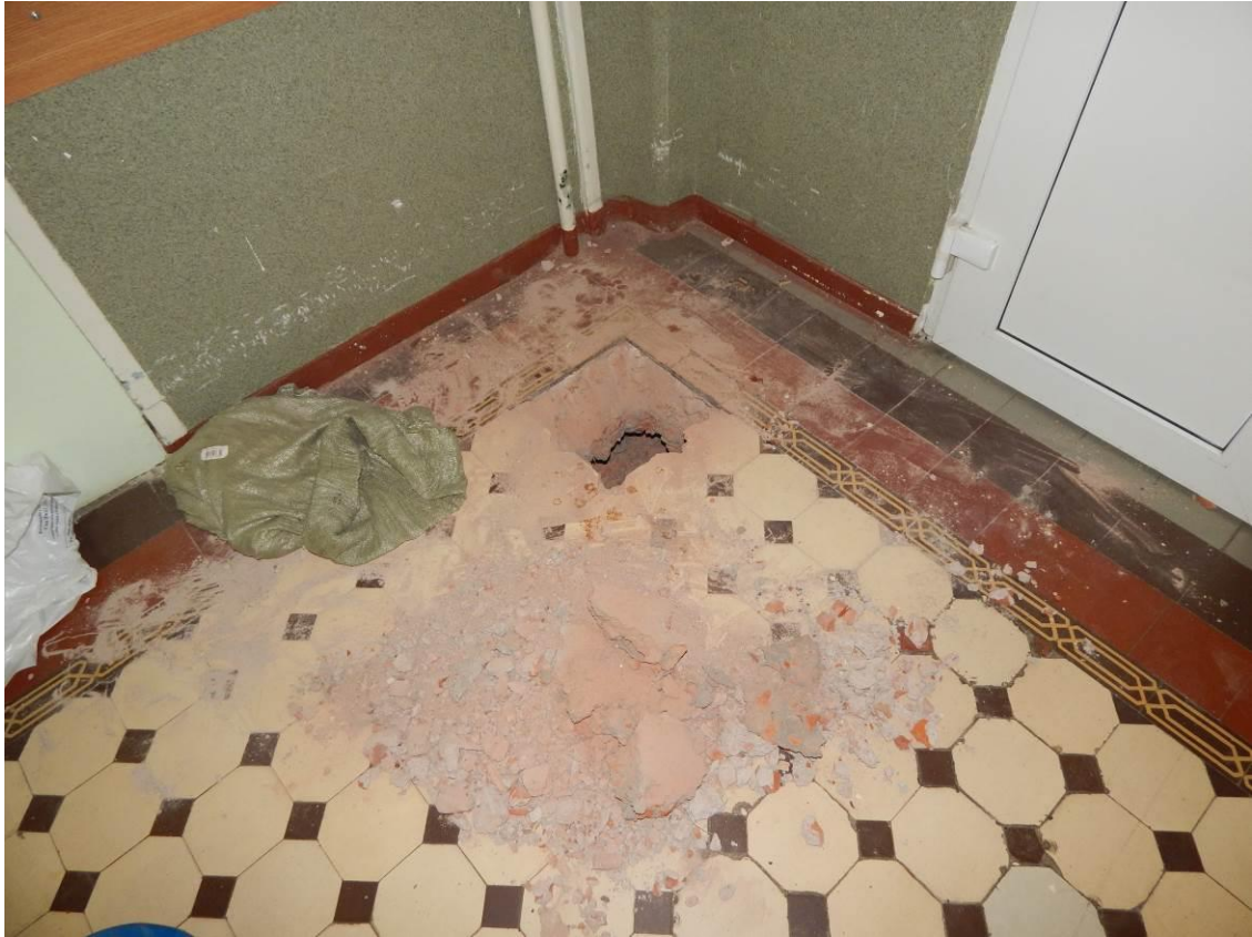
Рис П5.23. Вскрытие №2. Второй этаж. Коридор в осях 10-11/Д
