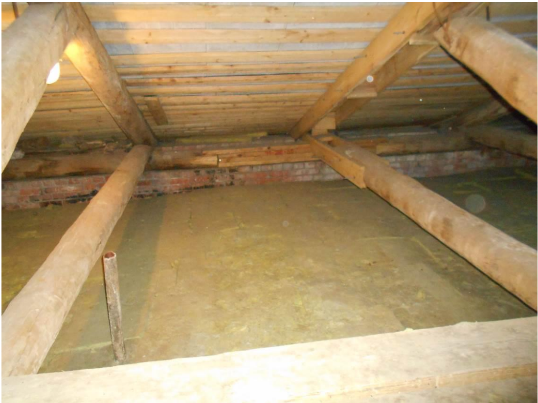
Фото П5.37 Стропильная система кровли здания.
