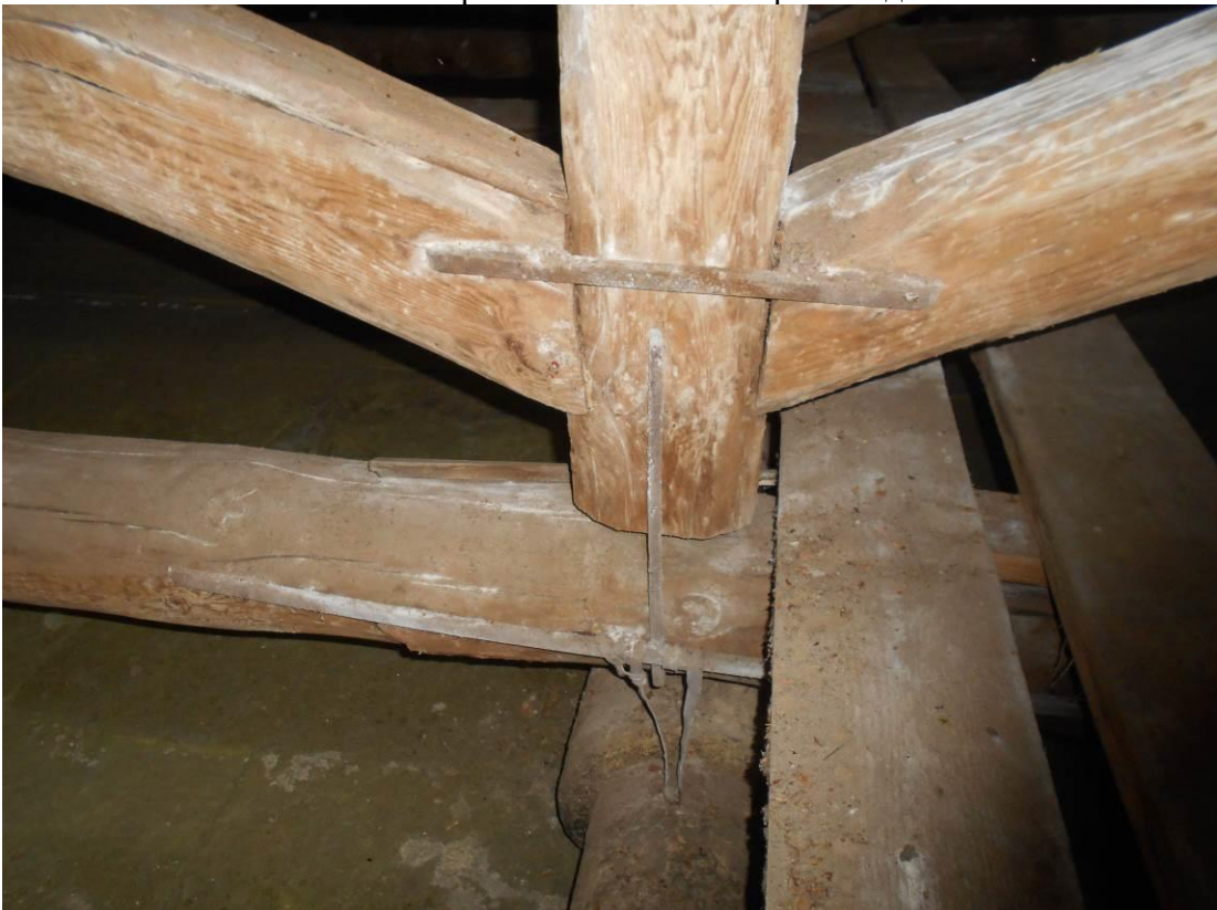
Фото П5.36 Стропильная система кровли здания.
