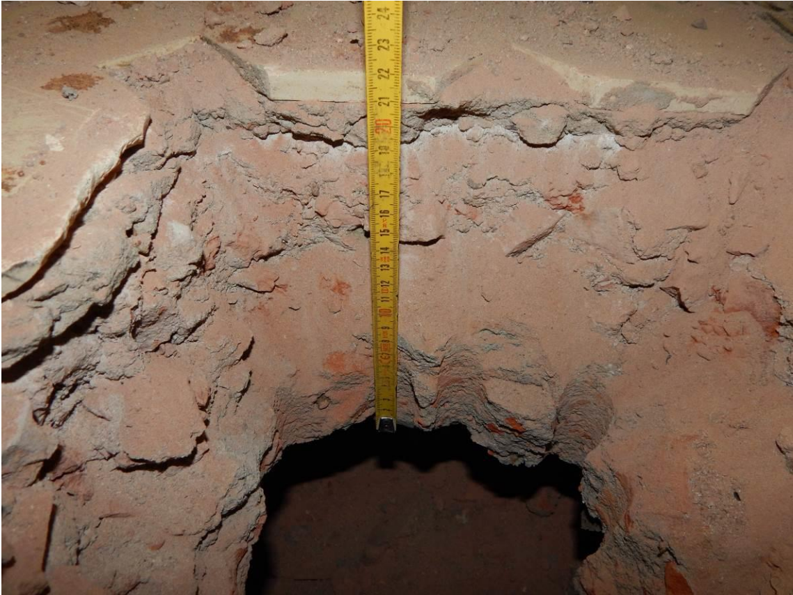
Рис П5.25. Вскрытие №2. Второй этаж. Коридор в осях 10-11/Д
