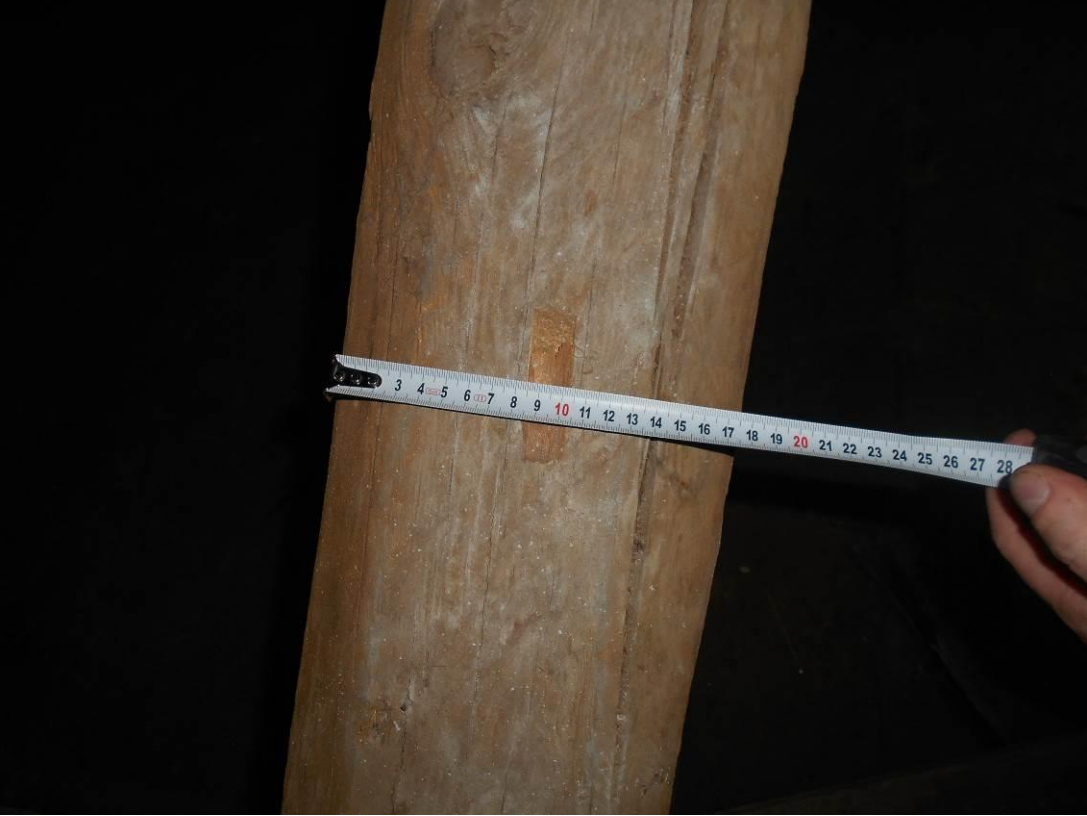
Фото П5.34 Стропильная система кровли здания.Подкосы.
