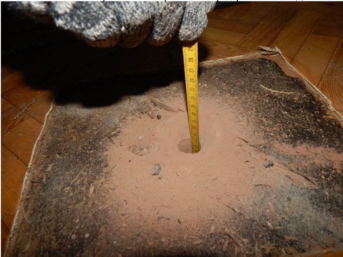
Рис П5.26. Вскрытие №3. Второй этаж. Коридор в осях 12/Е-Ж
