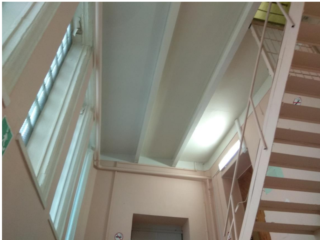
Фото П5.43 Перекрытие над лестничной клеткой в осях 1-2/Б-Г #1
