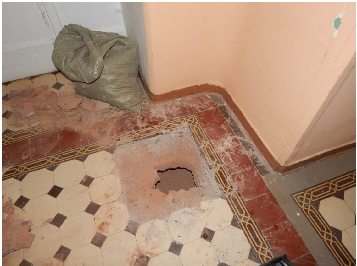
Рис П5.20. Вскрытие №1. Второй этаж. Коридор в осях 4-Е
