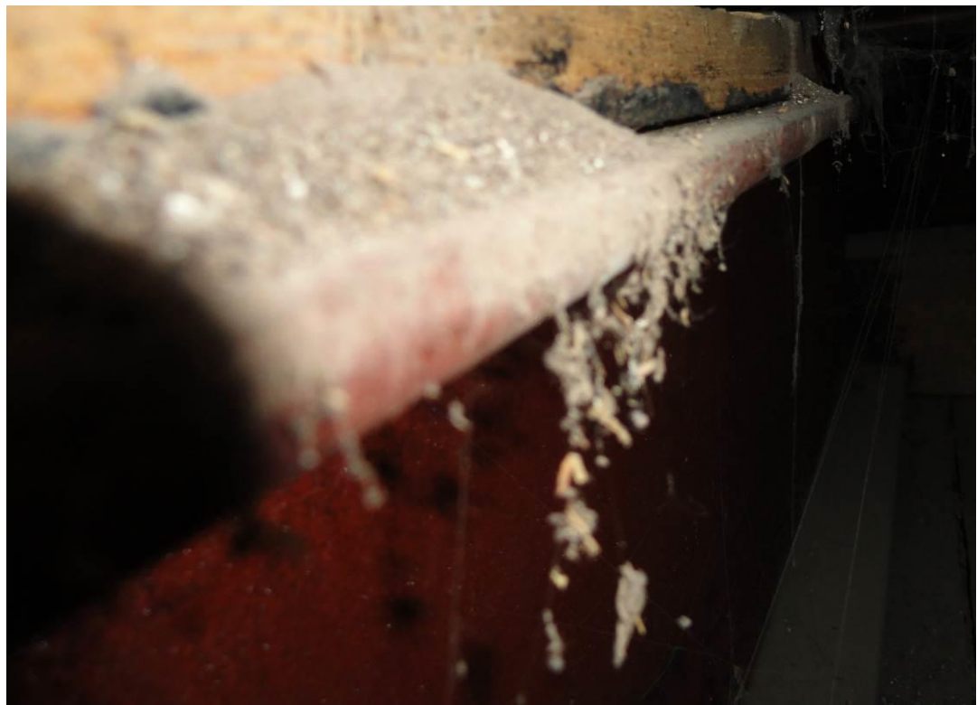
Фото П15.39 Перекрытие над 3-м этажом. Балка металлическая.
