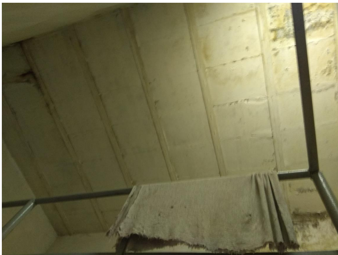
Фото П5.44 Перекрытие над лестничной клеткой в осях 1-2/Б-Г #2
