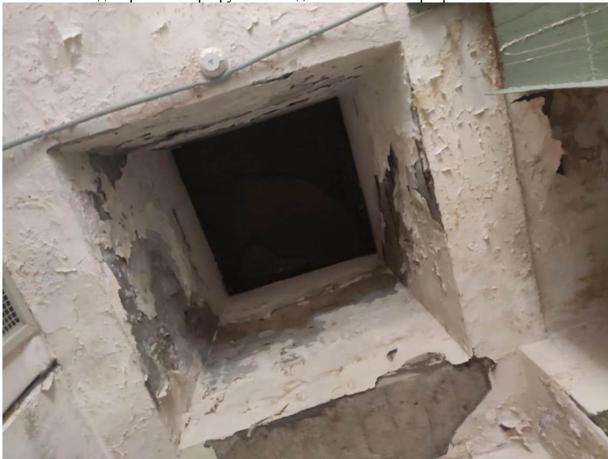
Фото №6. Следы протечек и разрушения отделочного слоя перекрытия.
