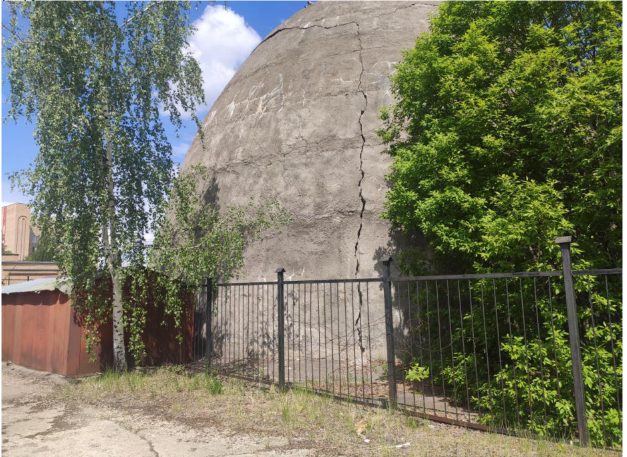
Фото №34. Отслоение и аварийное состояние наружной отделки купола.
