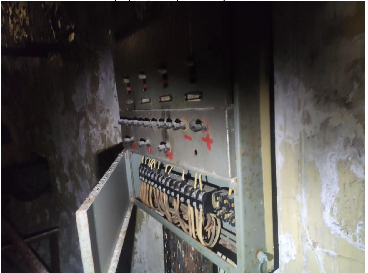
Фото №18. Состояние электроприборов и проводки в купольной части.
