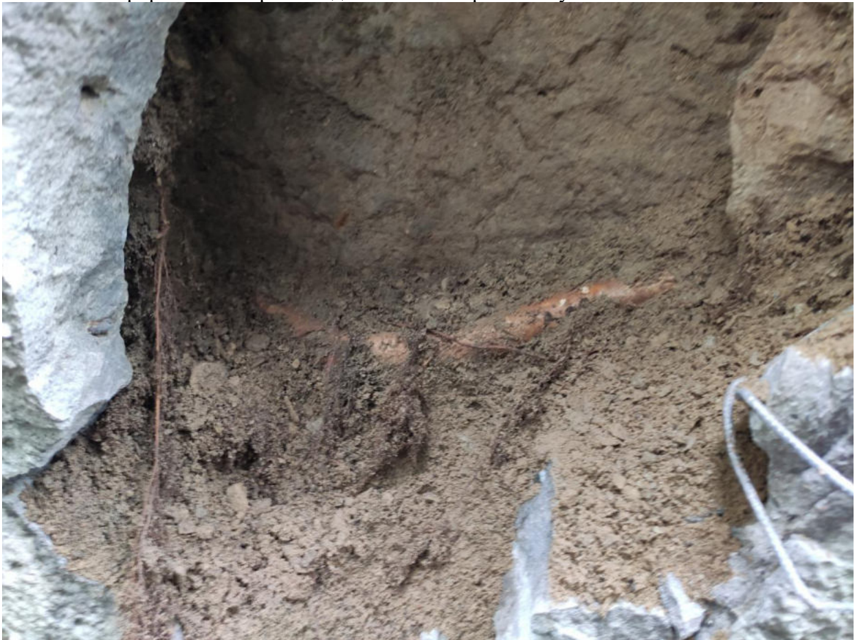
Фото №52. Прорастание корней под внешнем покрытием купола.
