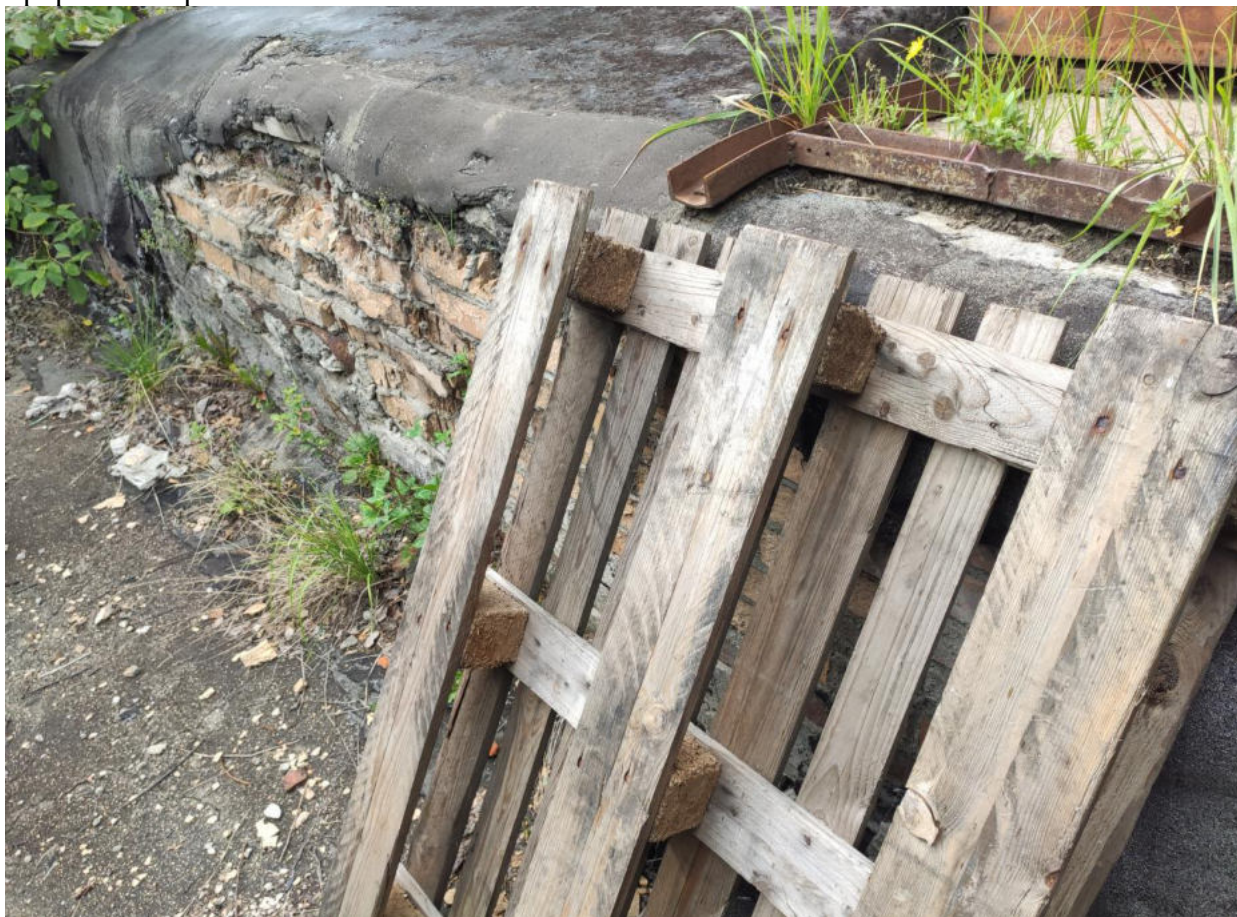
Фото №48. Разрушение поверхности кладки вместе с гидроизоляционным покрытием, прорастание растений на стыке .
