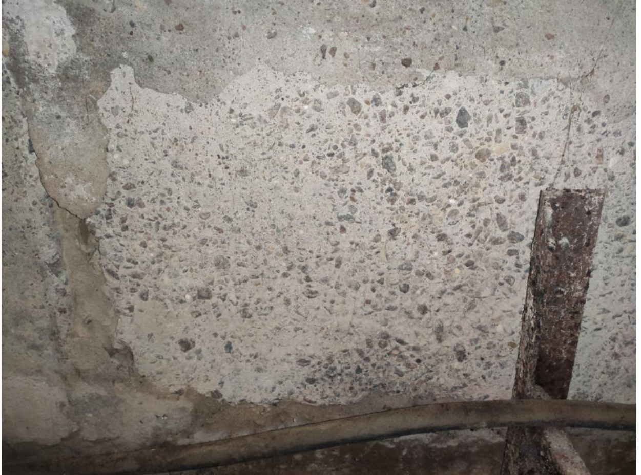
Фото №62. Монолитное перекрытие в районе светового фонаря, намокание перекрытия.
