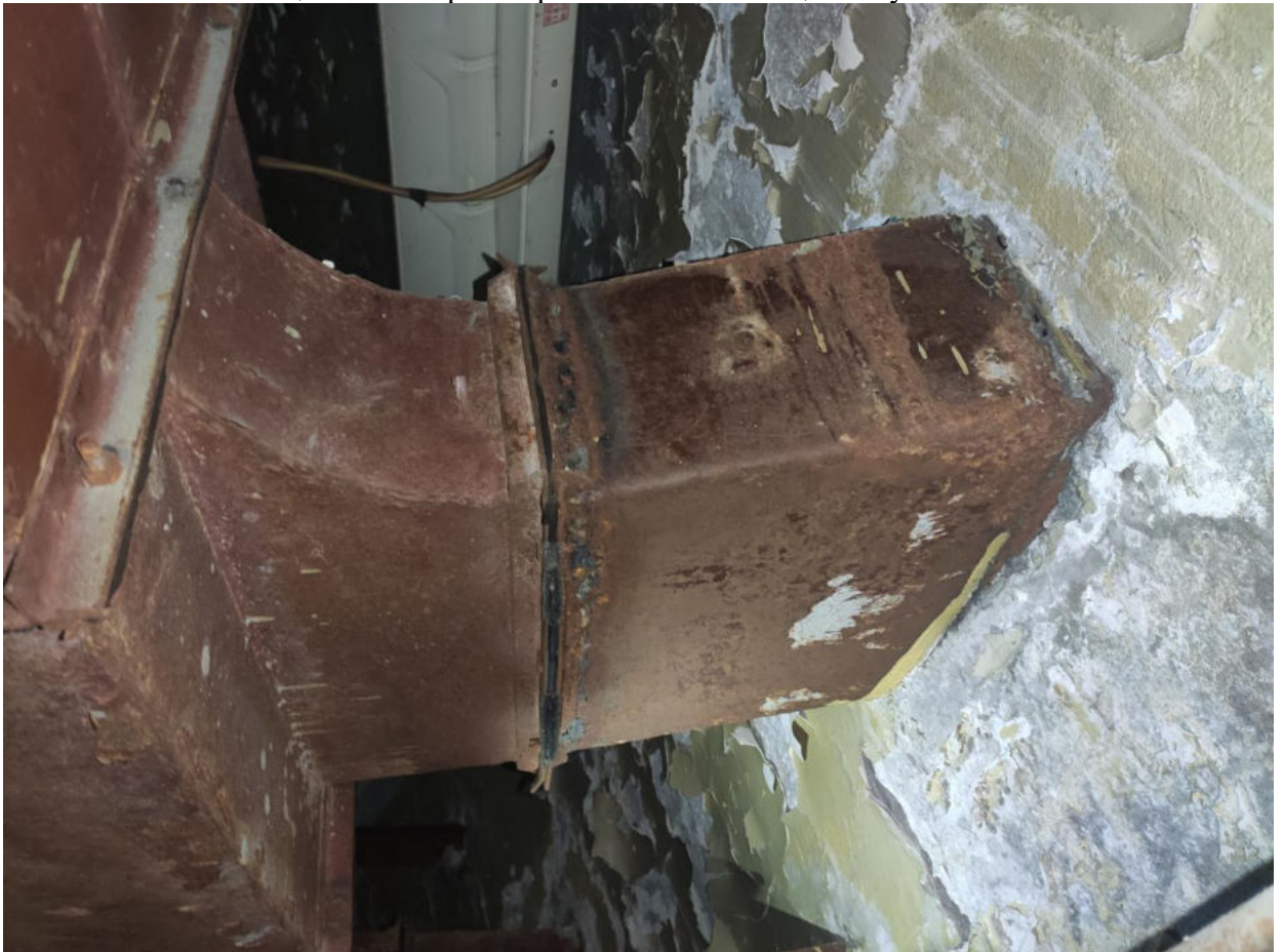
Фото №16. Вентиляционные короба приточной вентиляции в купольной части.
