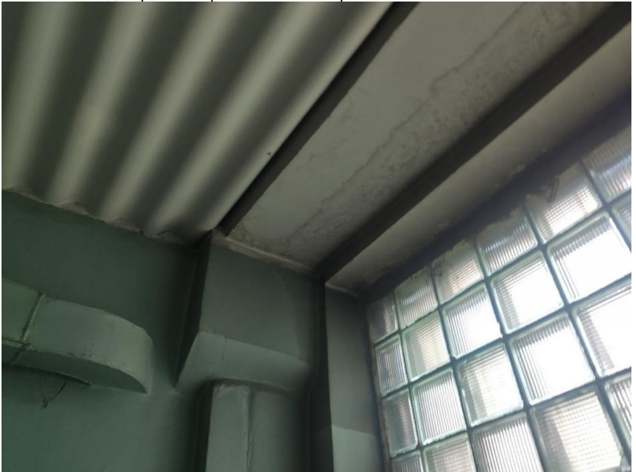
Фото №32. Следы протечек в районе оконного проема.
