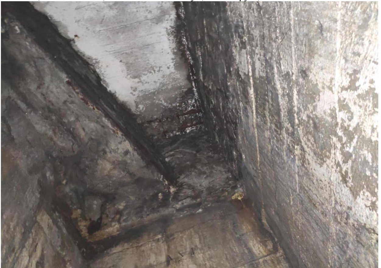
Фото №58. Отслоение защитного слоя бетона и коррозия армирования перекрытия вентиляционного помещения. Намокание несущих конструкций.
