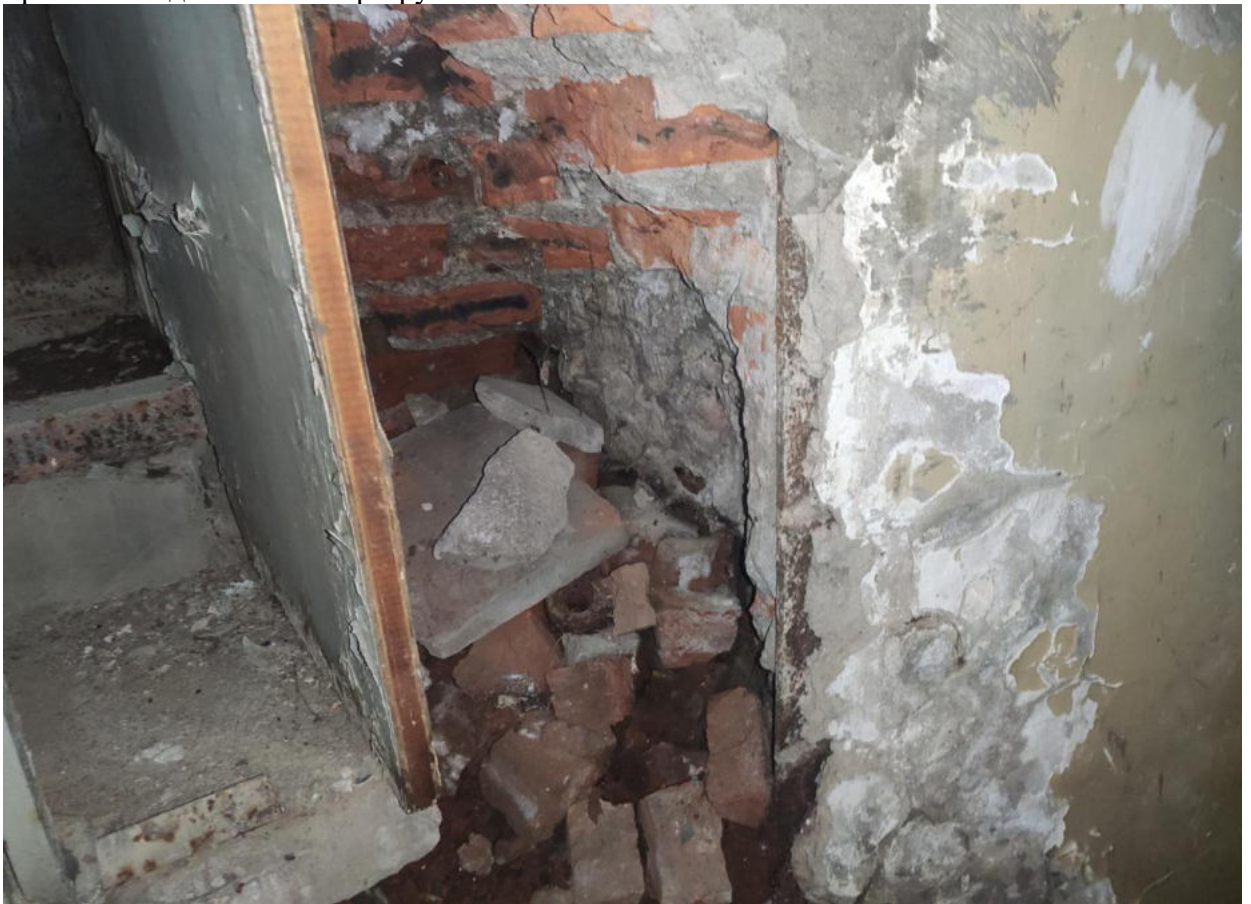
Фото №14. Стены купола выполнены из бетона, с обкладкой кирпичной кладкой в районе проёма. Кладка частично разрушена.
