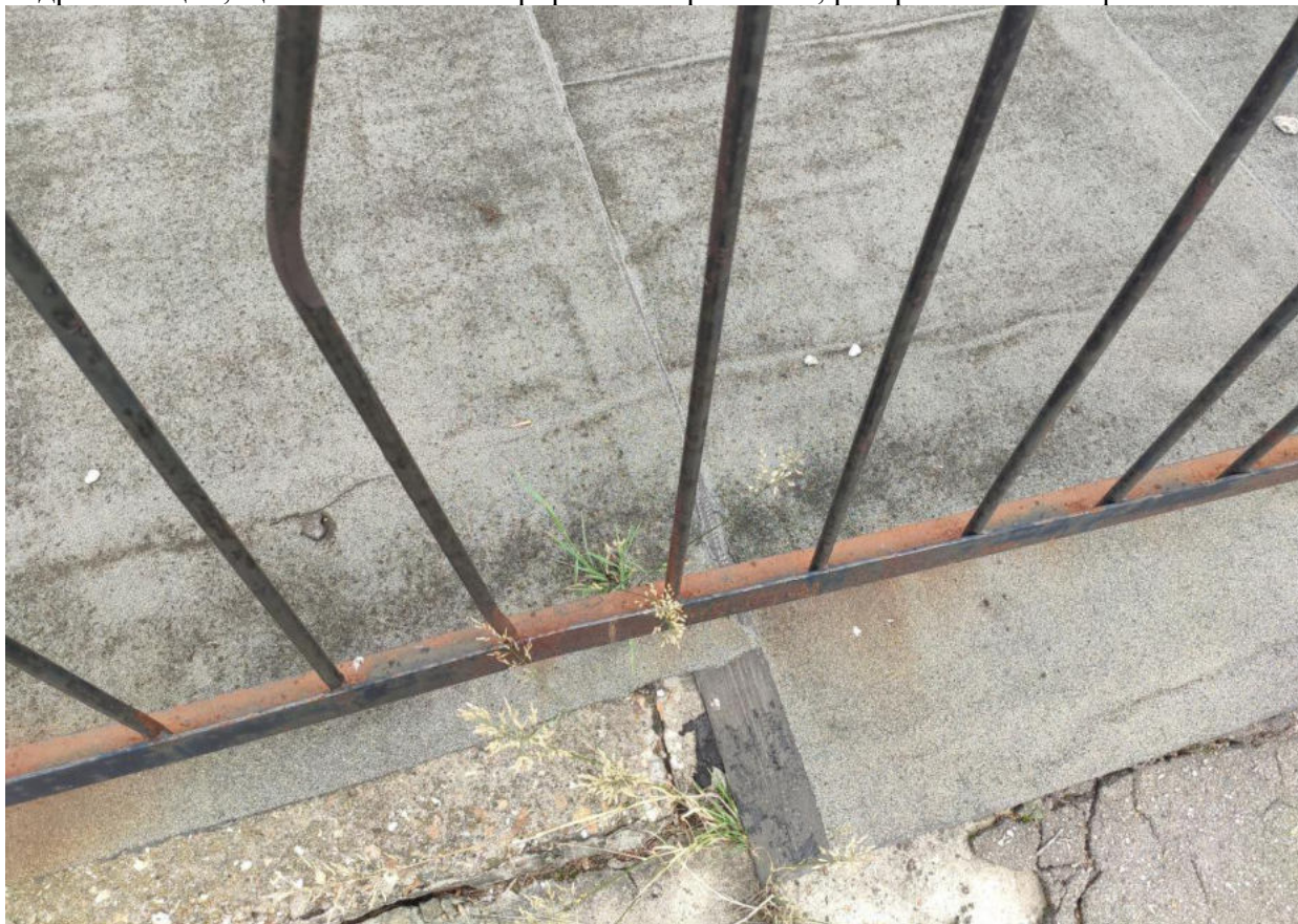
Фото №48. Разрушение поверхности кладки вместе с гидроизоляционным покрытием, прорастание растений на стыке .
