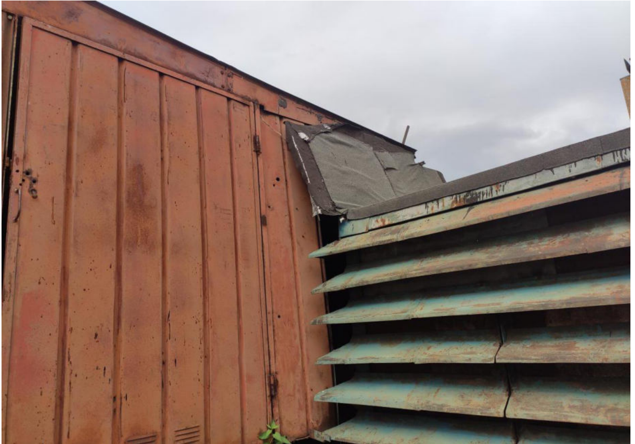
Фото №50. Частичное отсутствие асфальтового покрытия и прорастание растений.
