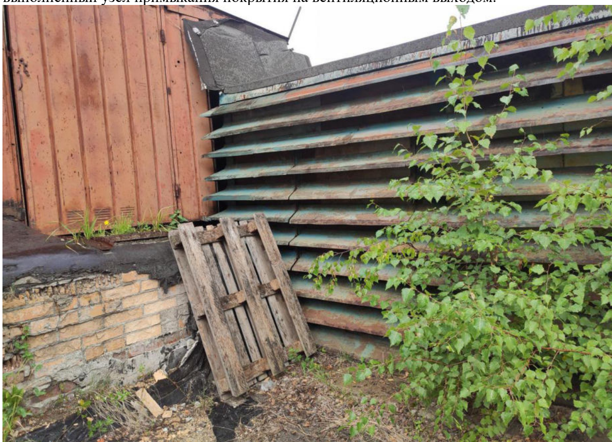
Фото №44. Разрыв гидроизоляционного слоя, прорастание растений, некачественно выполненный узел примыкания покрытия на вентиляционном выходе.
