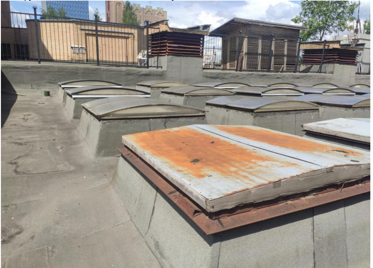
Фото №36. Световые фонари здания. Временные покрытия, в связи с разрушением конструкций от падения частей отделки купола. Следы застоя воды на покрытии.
