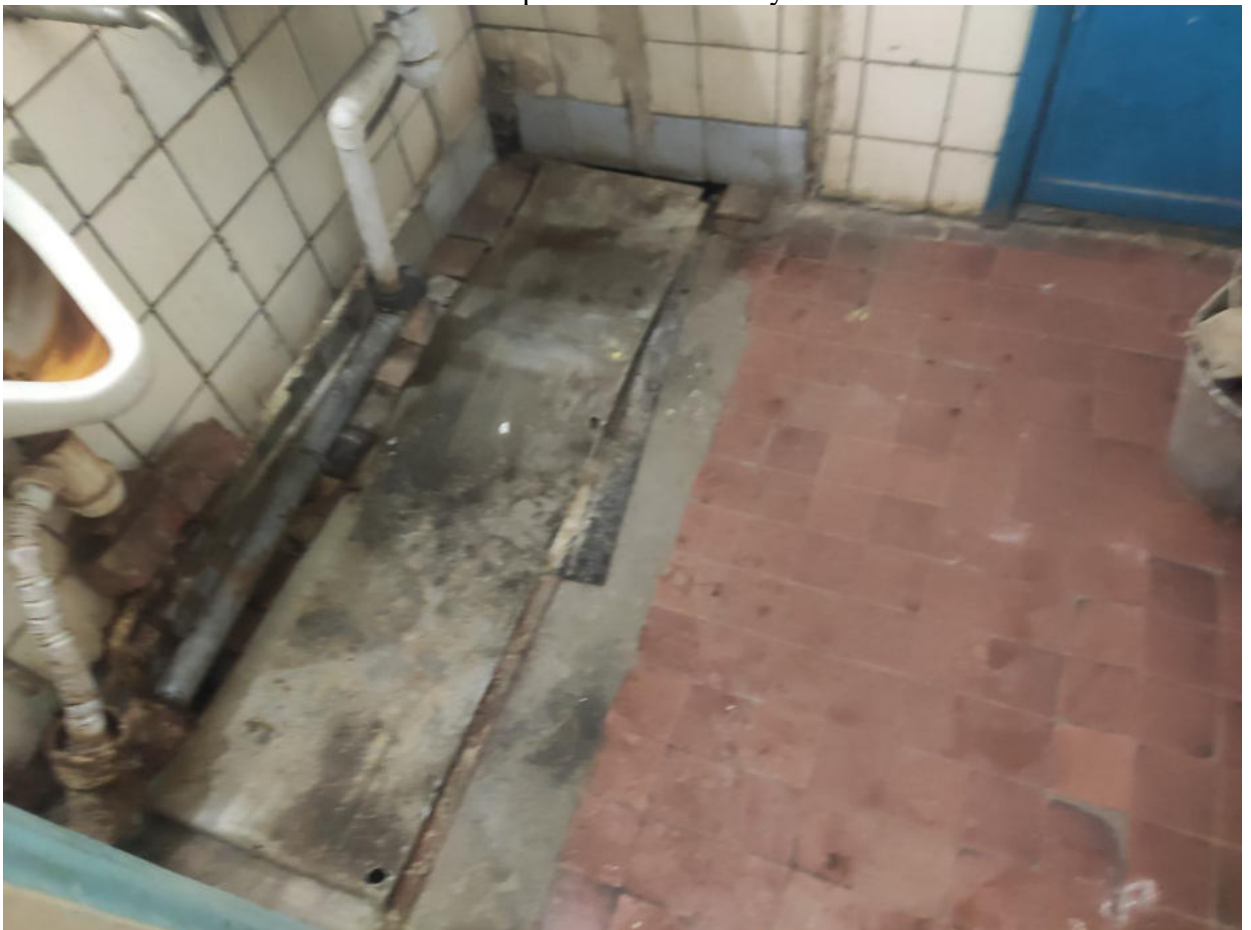
Фото №8. Техническое состояние покрытия пола в сан. узле.
