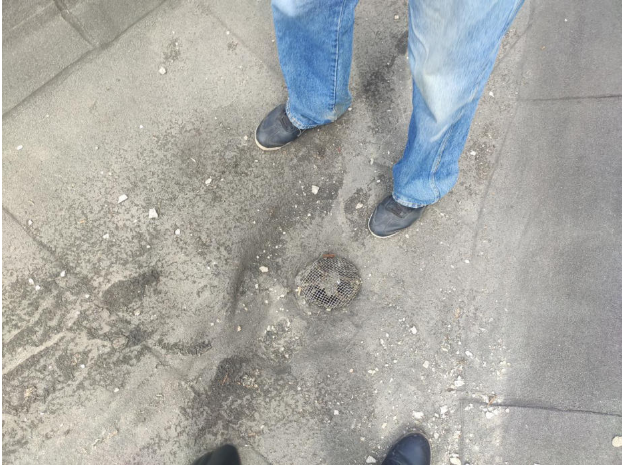
Фото №36. Световые фонари здания. Временные покрытия, в связи с разрушением конструкций от падения частей отделки купола. Следы застоя воды на покрытии.
