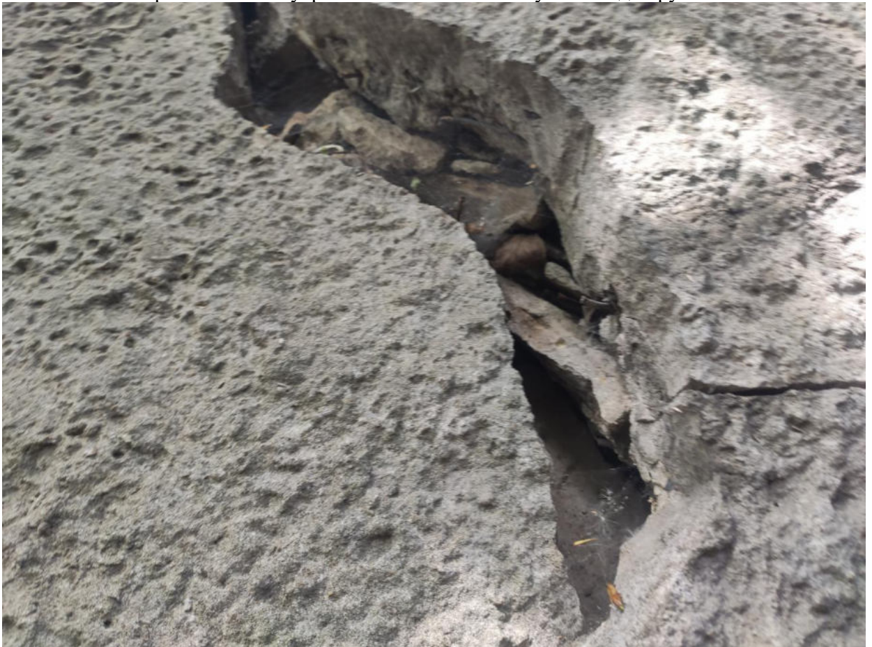
Фото №42. Растрескивание внутреннего бетона стены купола под наружным слоем.
