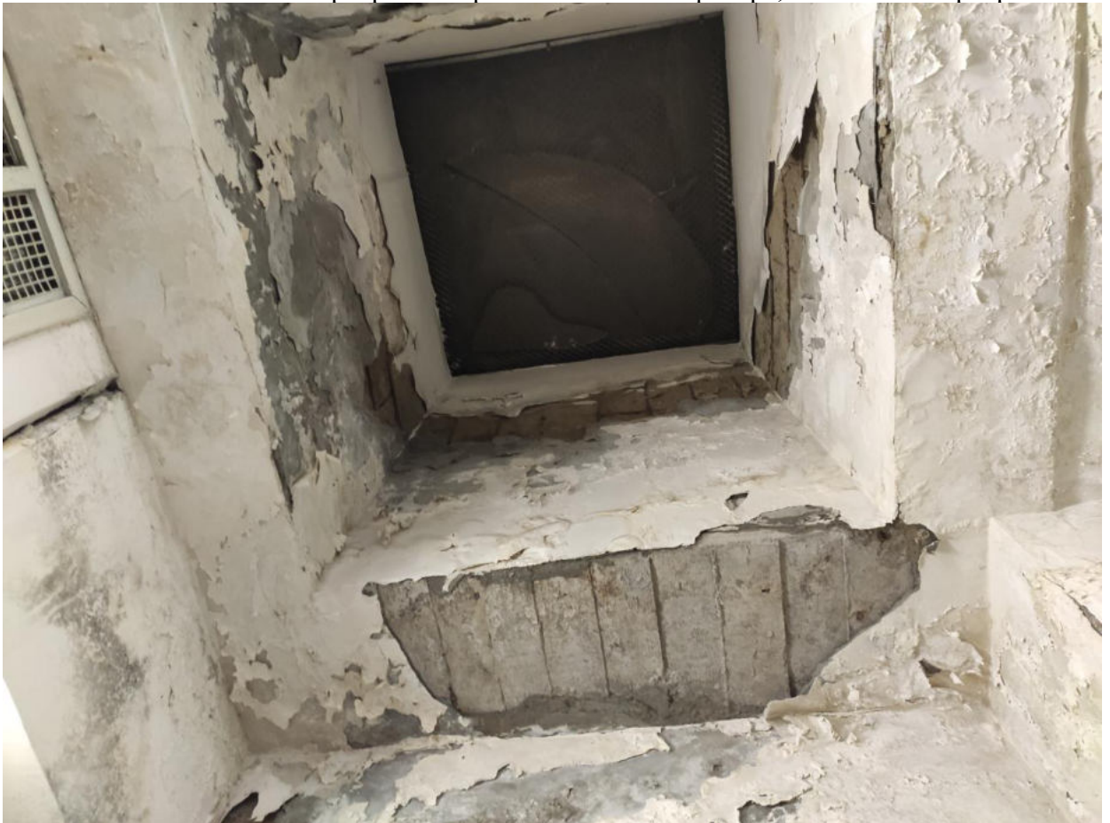
Фото №62. Монолитное перекрытие в районе светового фонаря, намокание перекрытия.
