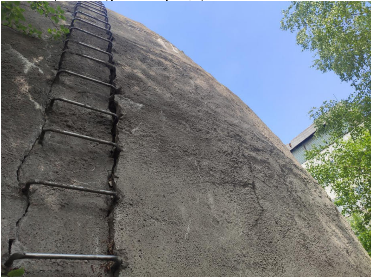
Фото №40. Трещины в наружном слое купола, в районе лестницы.
