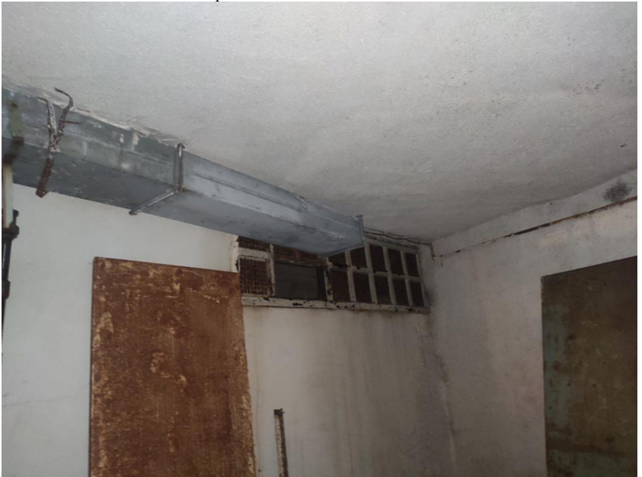
Фото №10. Разрушение отделки, высолы и темные пятна на перекрытии.
