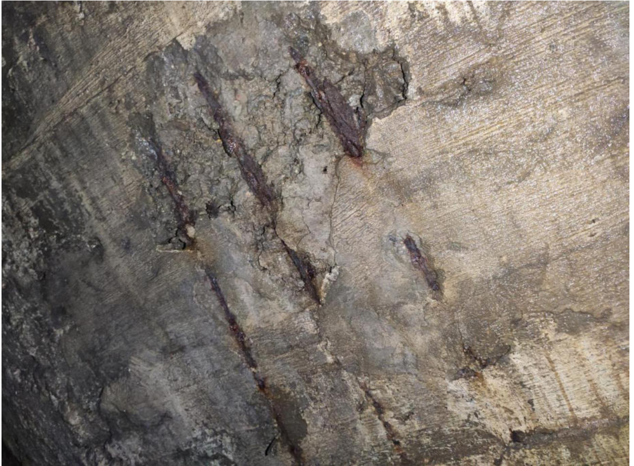
Фото №58. Отслоение защитного слоя бетона и коррозия армирования перекрытия вентиляционного помещения. Намокание несущих конструкций.
