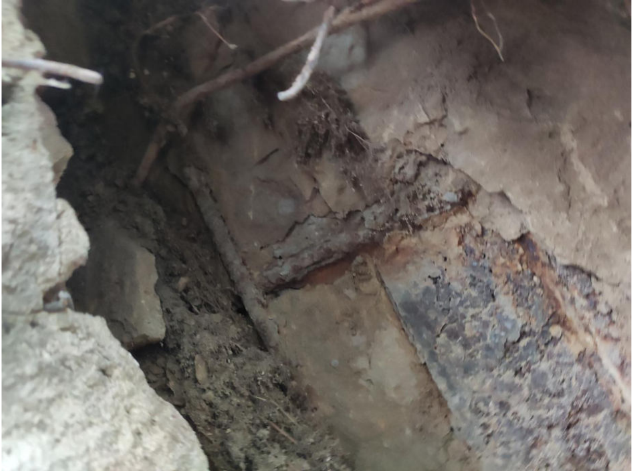
Фото №54. Засорённый дренажный колодец, не функционирующий дренаж.
