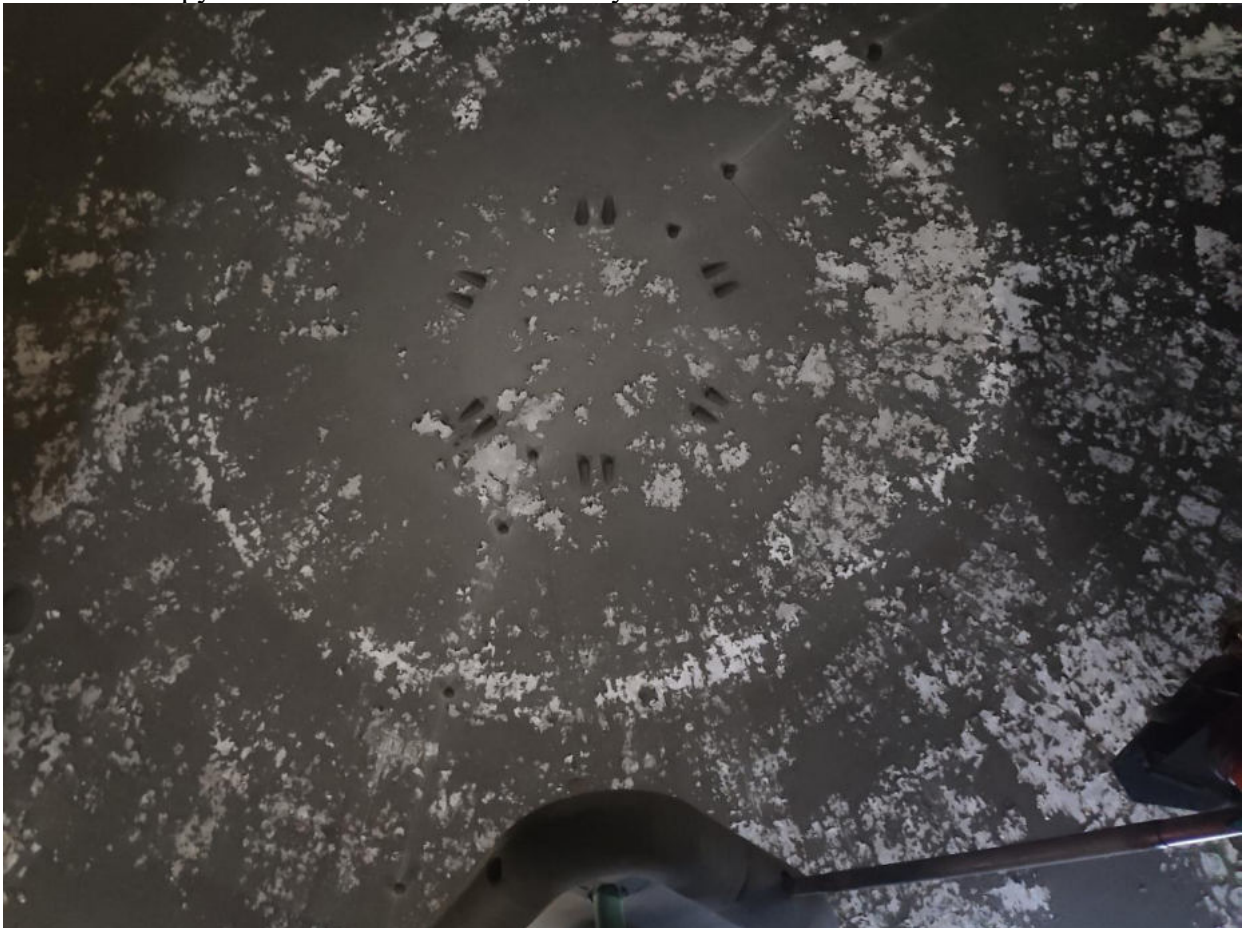
Фото №20. Трубы вытяжной вентиляции в куполе.
