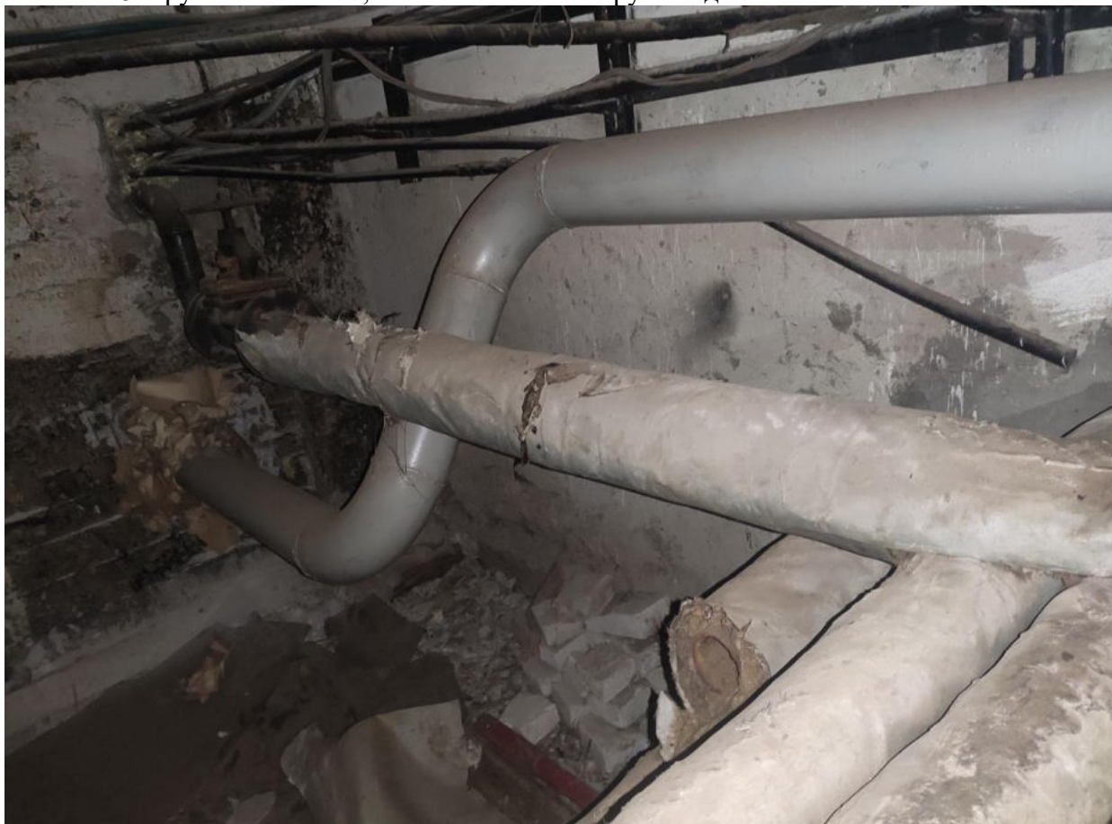
Фото №28. Трубы отопления, силовые кабели и труба водоснабжения.
