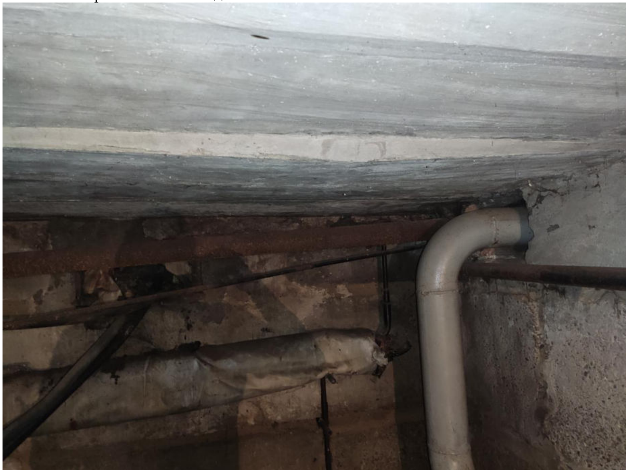
Фото №60. Отслоение защитного слоя бетона, коррозия арматуры плиты подвала.
