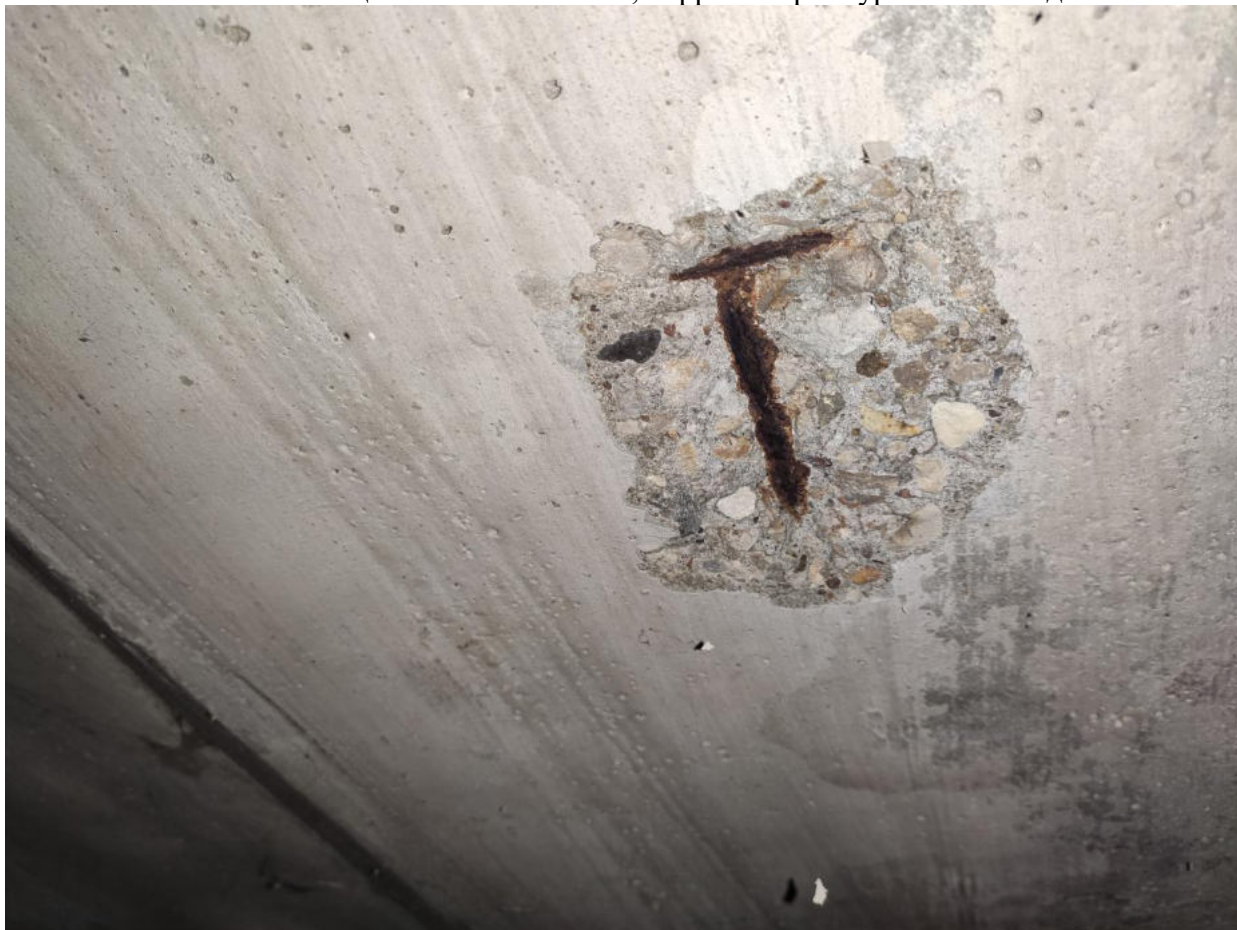
Фото №60. Отслоение защитного слоя бетона, коррозия арматуры плиты подвала.
