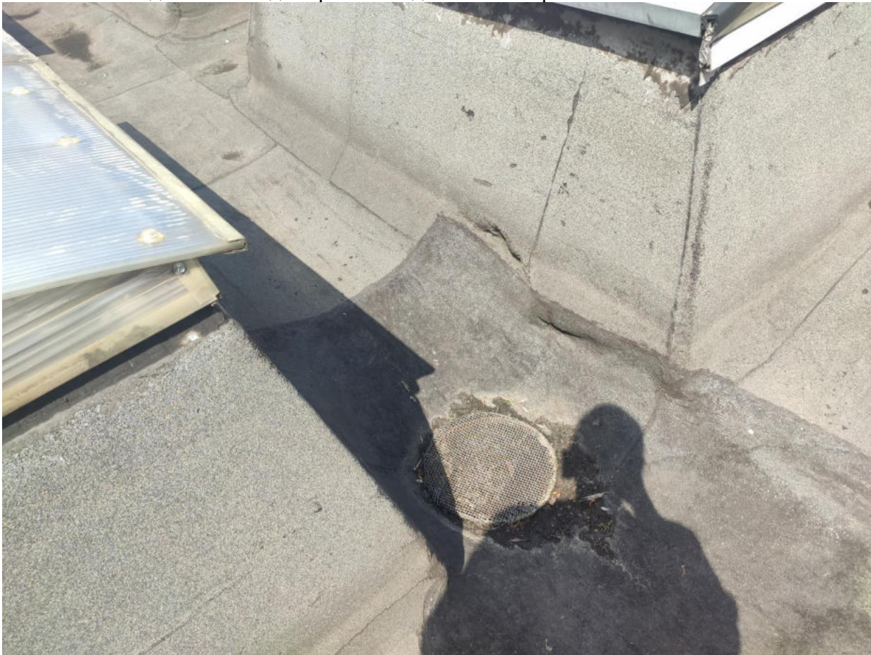
Фото №38. Следы застоя воды в районе водосливной воронки.
