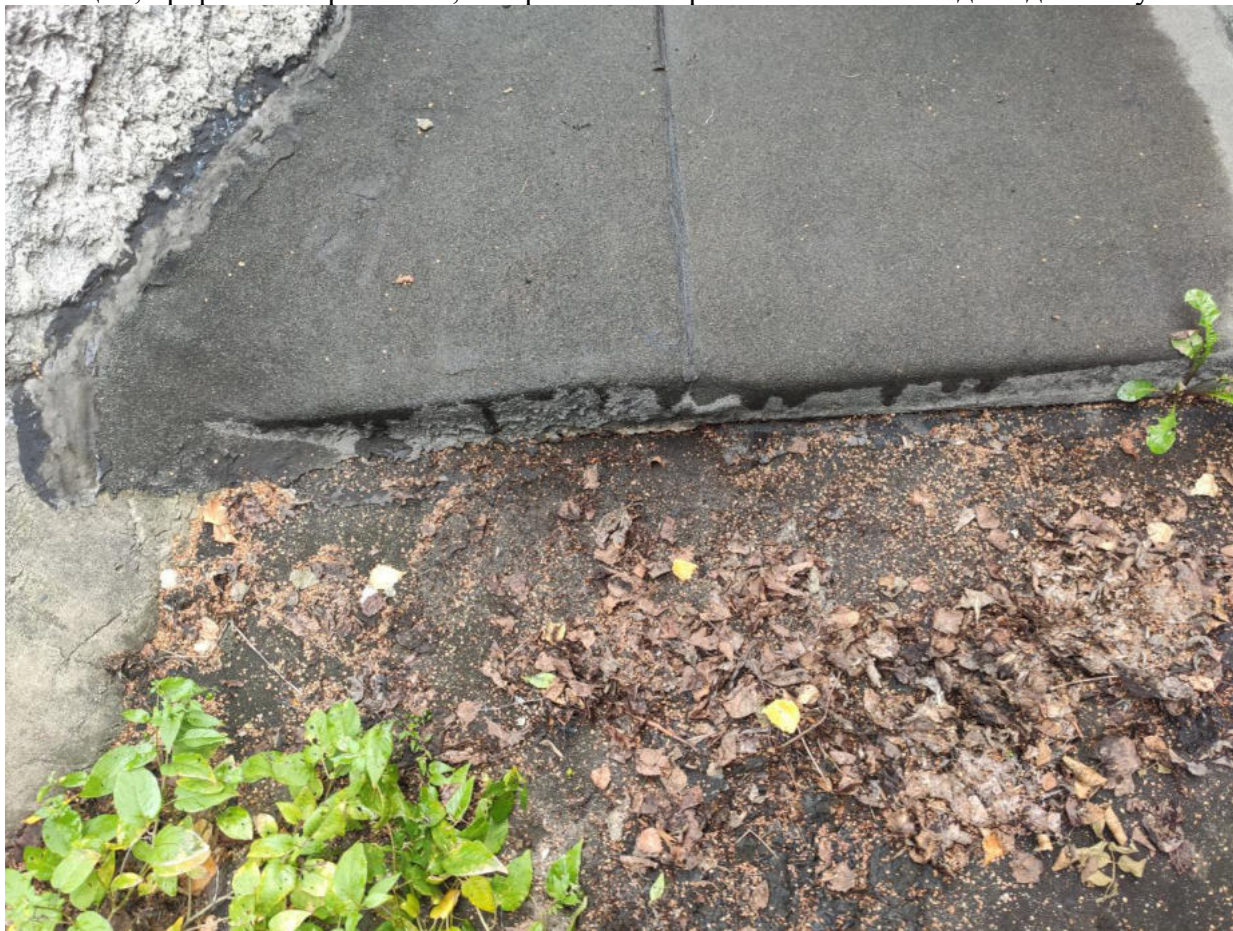
Фото №46. Вдутья гидроизоляционного покрытия.
