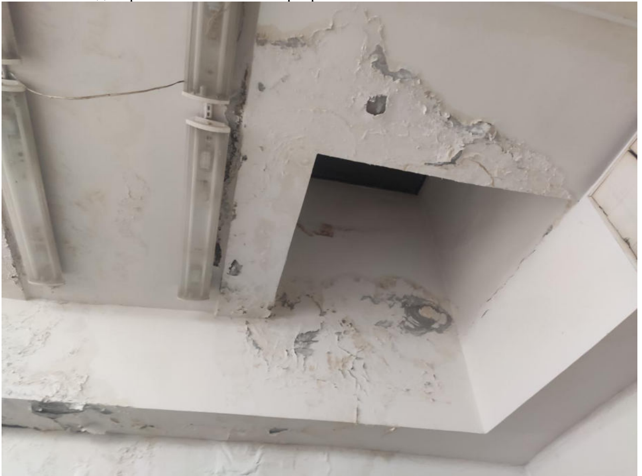
Фото №2. Следы протечек на стенах и перекрытии.
