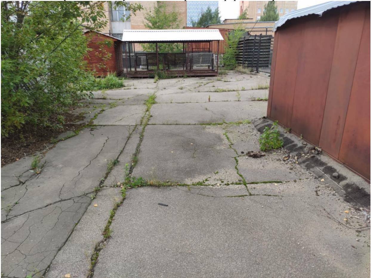
Фото №52. Прорастание корней под внешнем покрытием купола.
