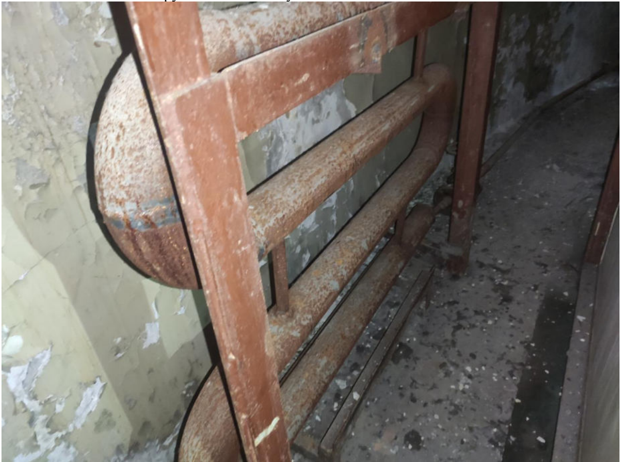
Фото №22. Состояние труб отопления в купольной части.
