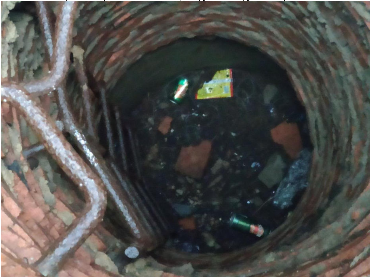
Фото №54. Засорённый дренажный колодец, не функционирующий дренаж.
