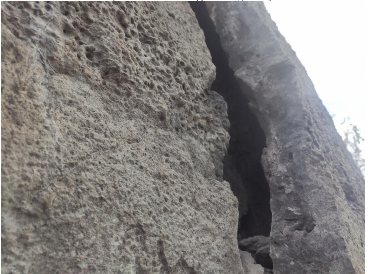
Фото №34. Отслоение и аварийное состояние наружной отделки купола.
