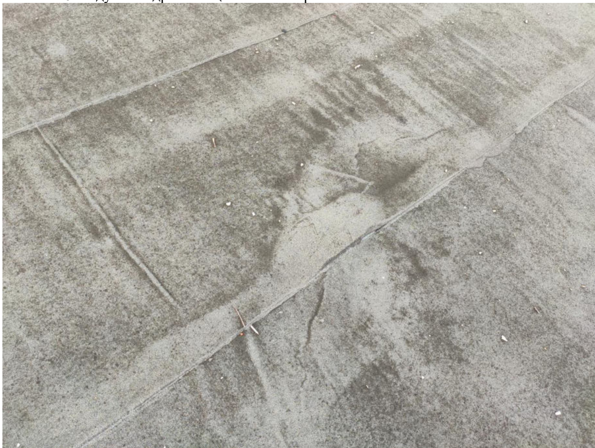
Фото №46. Вдутья гидроизоляционного покрытия.
