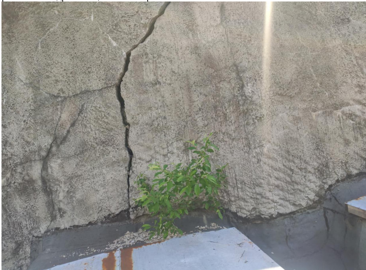
Фото №44. Разрыв гидроизоляционного слоя, прорастание растений, некачественно выполненный узел примыкания покрытия на вентиляционном выходе.
