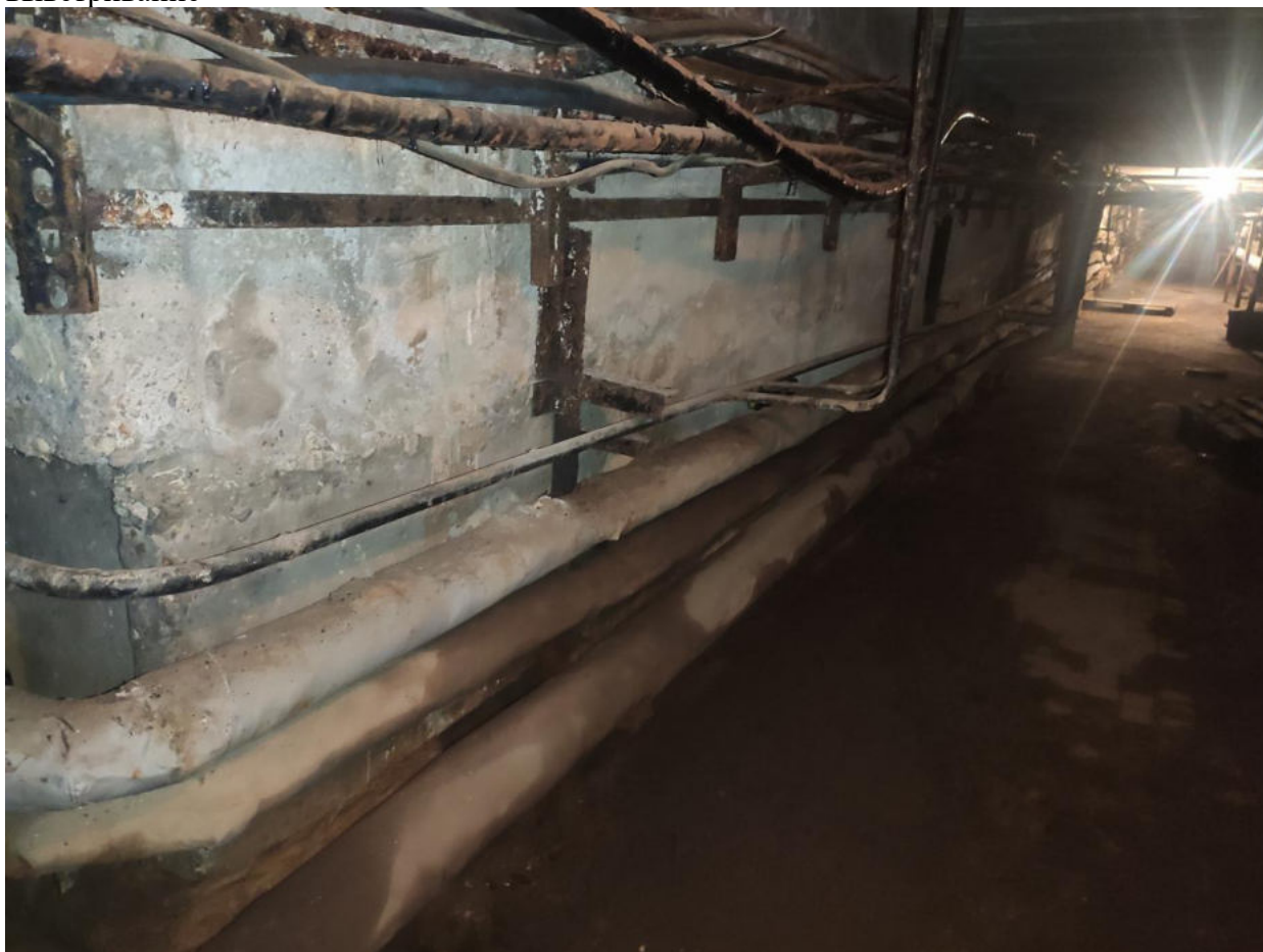
Фото №28. Трубы отопления, силовые кабели и труба водоснабжения.
