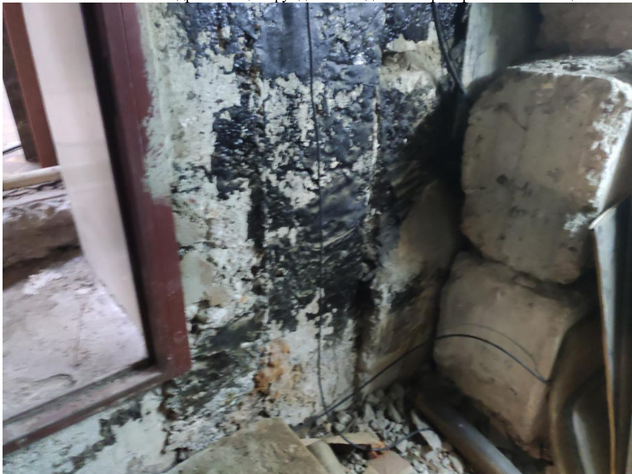
Фото №56. Испытание прочности бетона стены в вентиляционном помещении. Намокание несущих конструкций.
