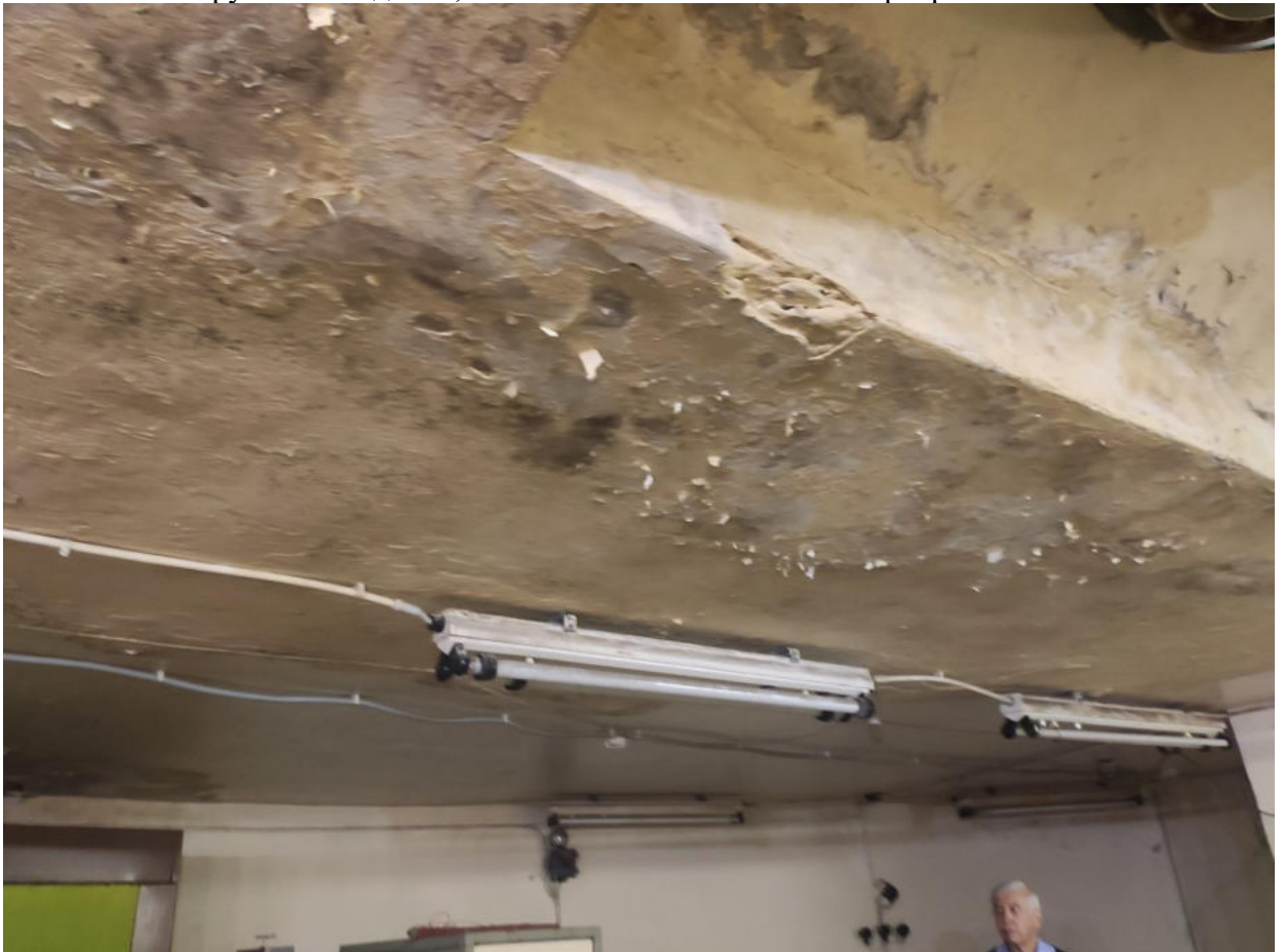
Фото №10. Разрушение отделки, высолы и темные пятна на перекрытии.
