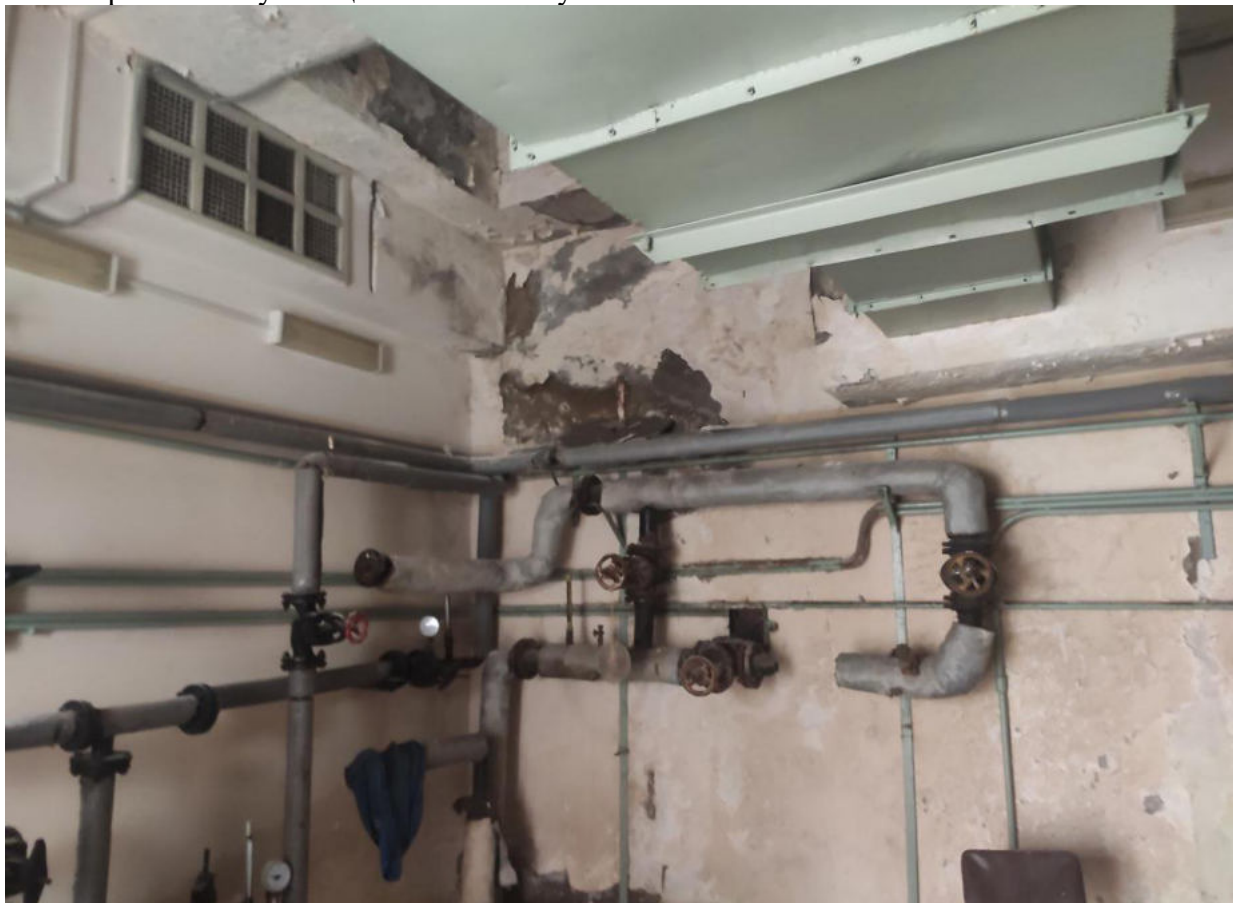
Фото №6. Следы протечек и разрушения отделочного слоя перекрытия.
