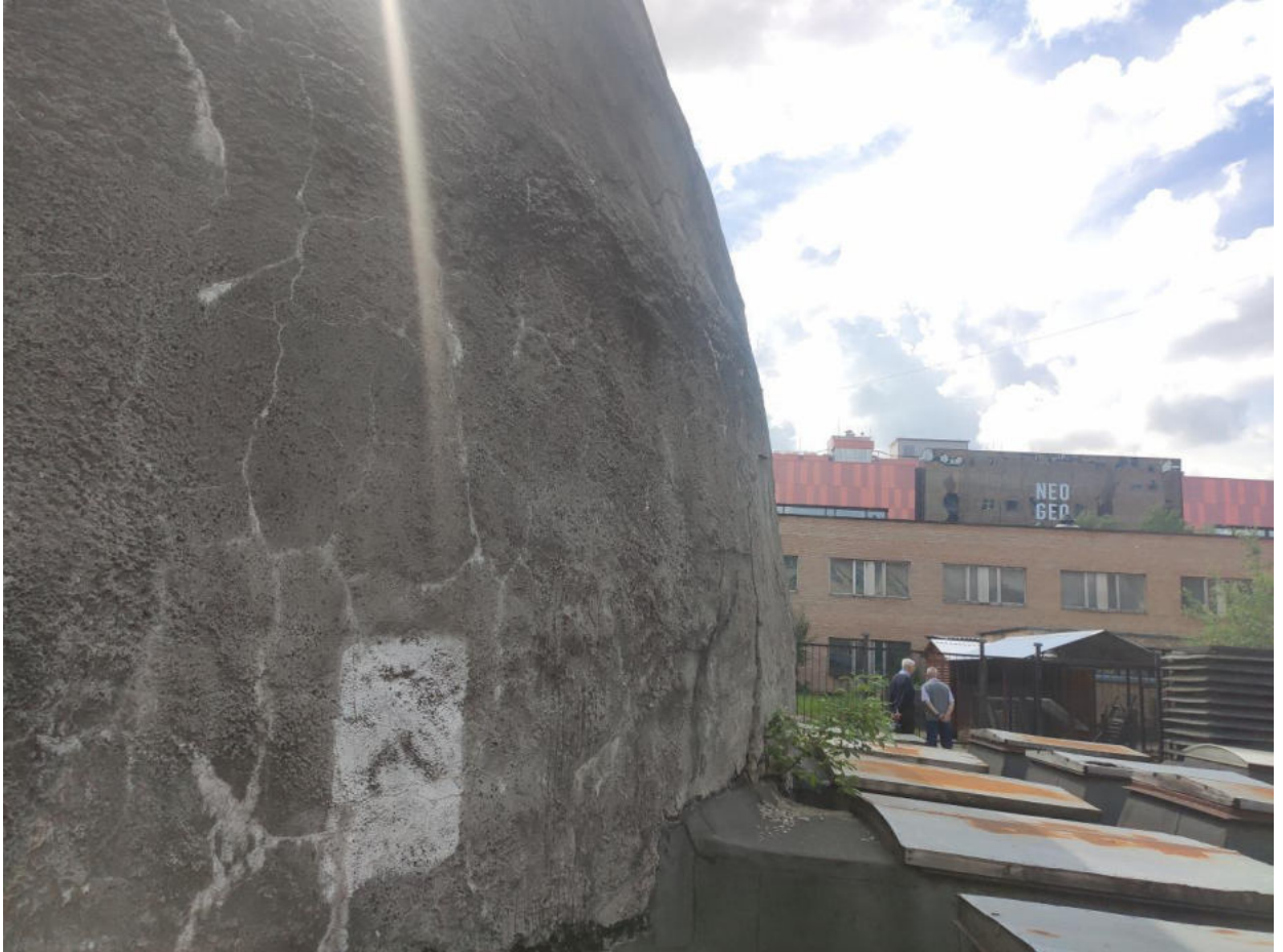
Фото №40. Трещины в наружном слое купола, в районе лестницы.
