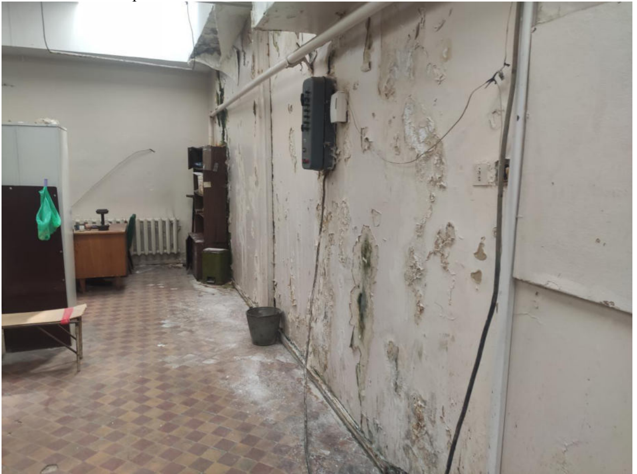
Фото №2. Следы протечек на стенах и перекрытии.
