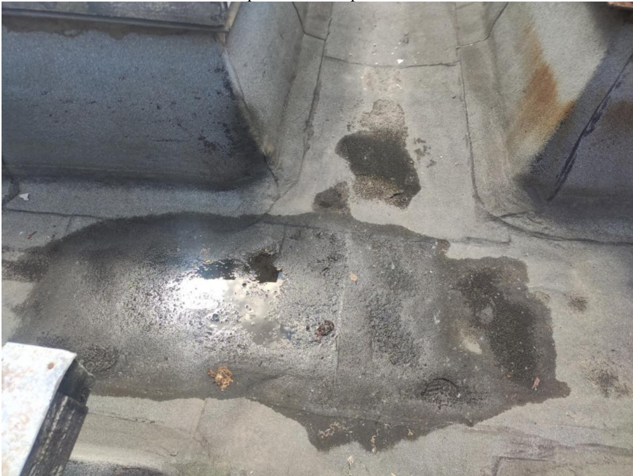
Фото №38. Следы застоя воды в районе водосливной воронки.
