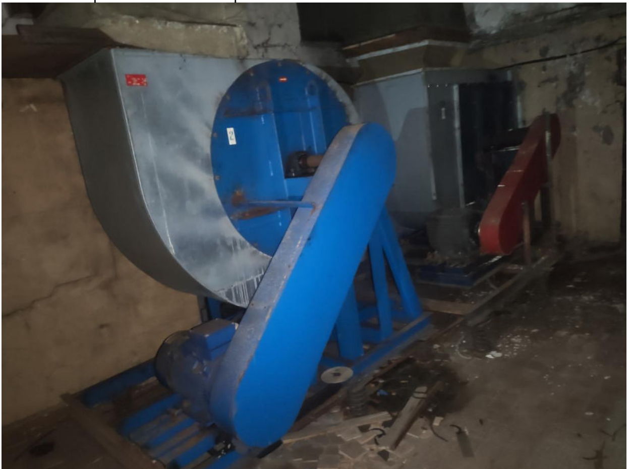
Фото №24. Приточные вентиляторы.
