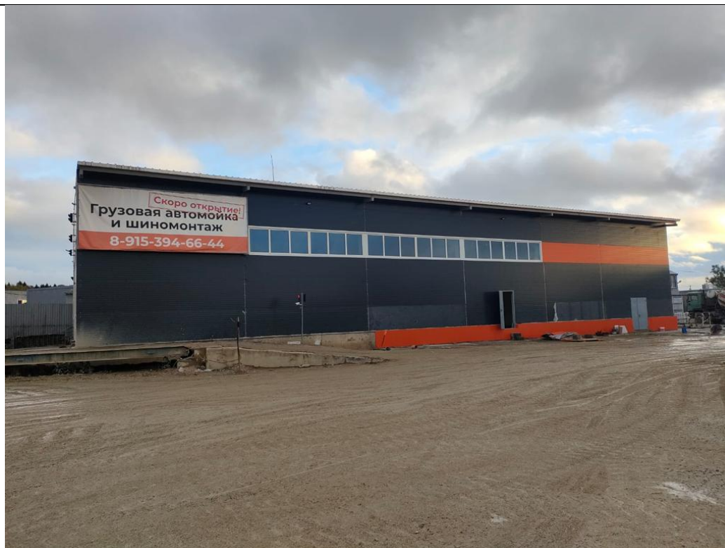
Фото №1 Общий вид здания и расположенных рядом теплиц
