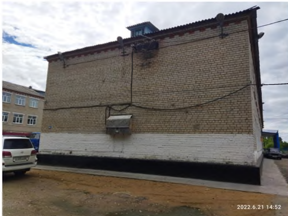
Фото № 8 – Фасад здания школы в осях 4-6. Общий вид.
