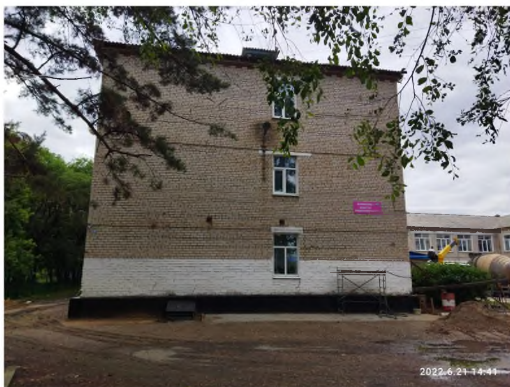
Фото № 4 – Фасад здания школы в осях 1-3. Общий вид.
