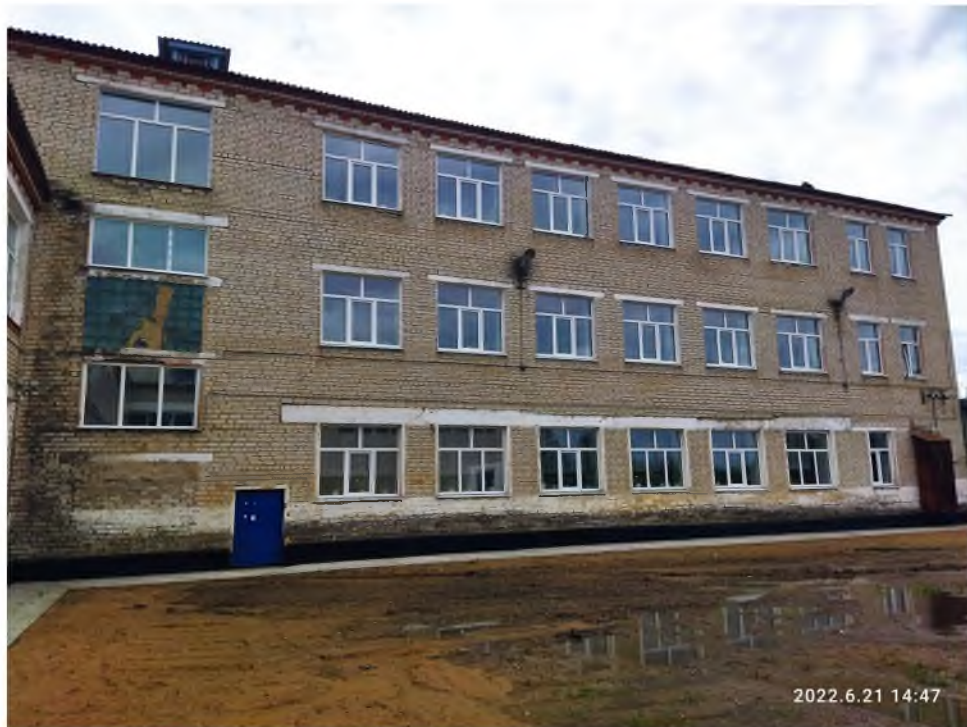
Фото № 7 – Фасад здания школы в осях 3-Л по оси 3. Общий вид.
