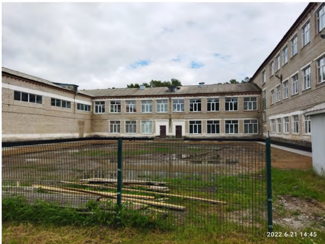
Фото № 5 – Фасад здания школы в осях 4–3. Общий вид.
