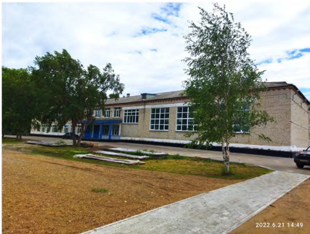
Фото № 1 – Фасад здания школы в осях А-Л. Общий вид.
