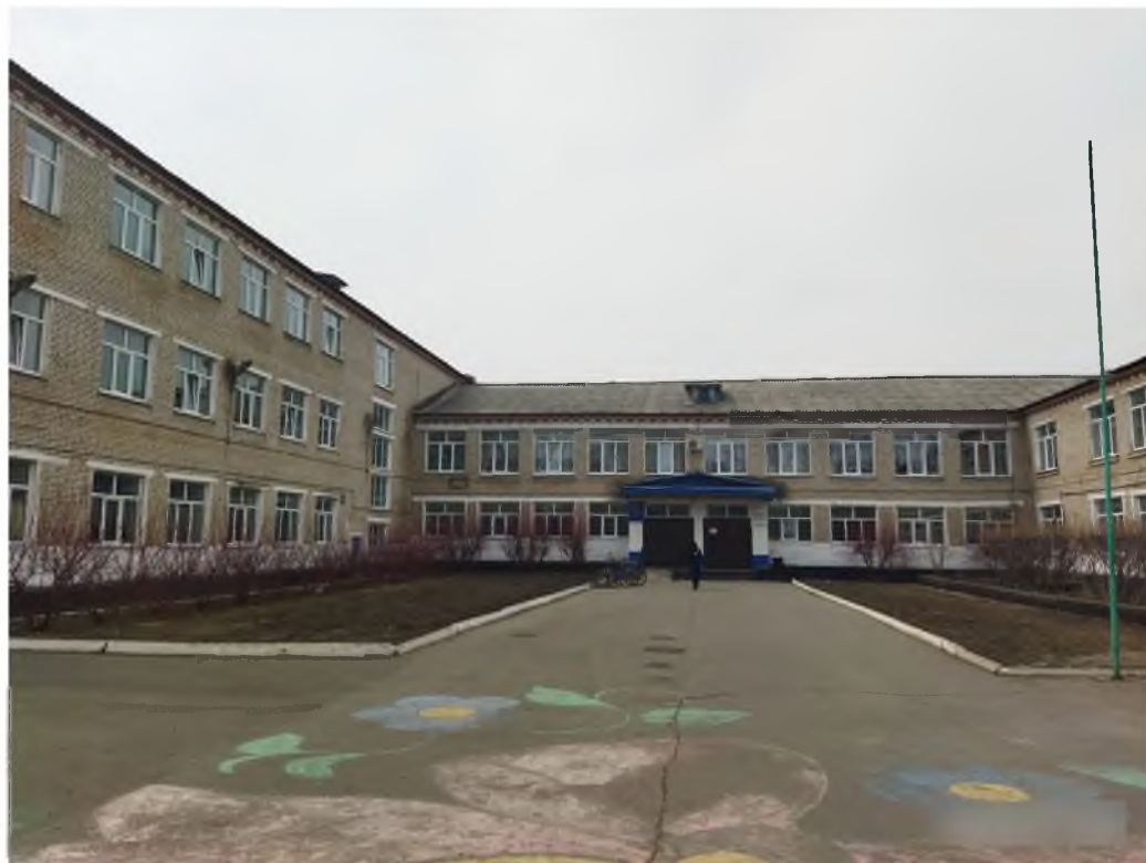
Фото № 3 — Фасад здания в осях 3-4. Общий вид.
