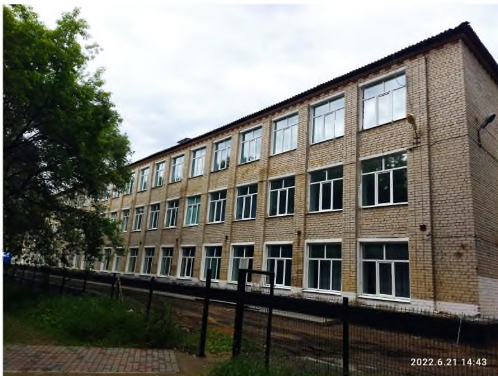
Фото № 2 – Фасад здания в осях Л-А. Общий вид.
