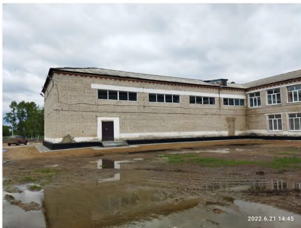
Фото № 6 – Фасад здания школы в осях 1–3 по оси 4. Общий вид.
