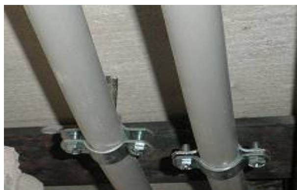
Б) Прокладка ОКЛ в трубах
