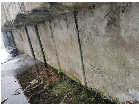
Для защиты бетона головных частей шпунта, предупреждения дальнейшей деформации шпунтин, для исключения вымывания засыпки из под понура, предусматривается сплошное восстановление низовой плоскости шпунтовой стенки ремонтными составами ЭМАКО
