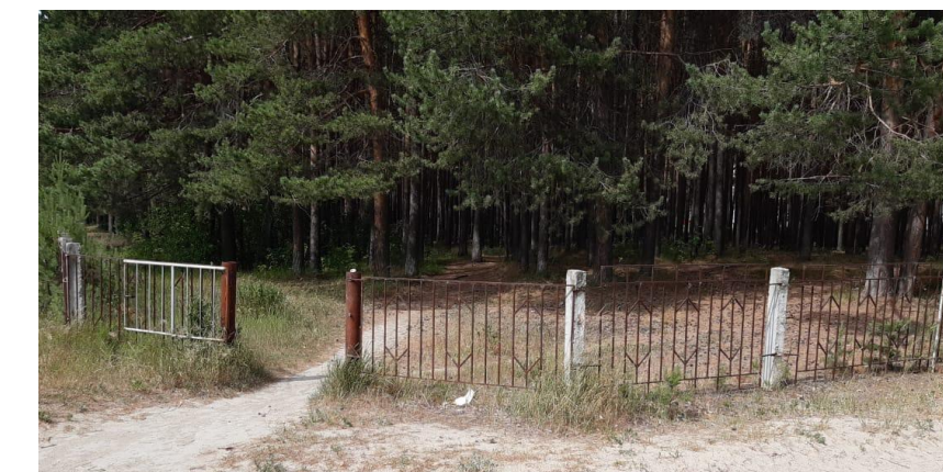
Демонтаж существующего ограждения
