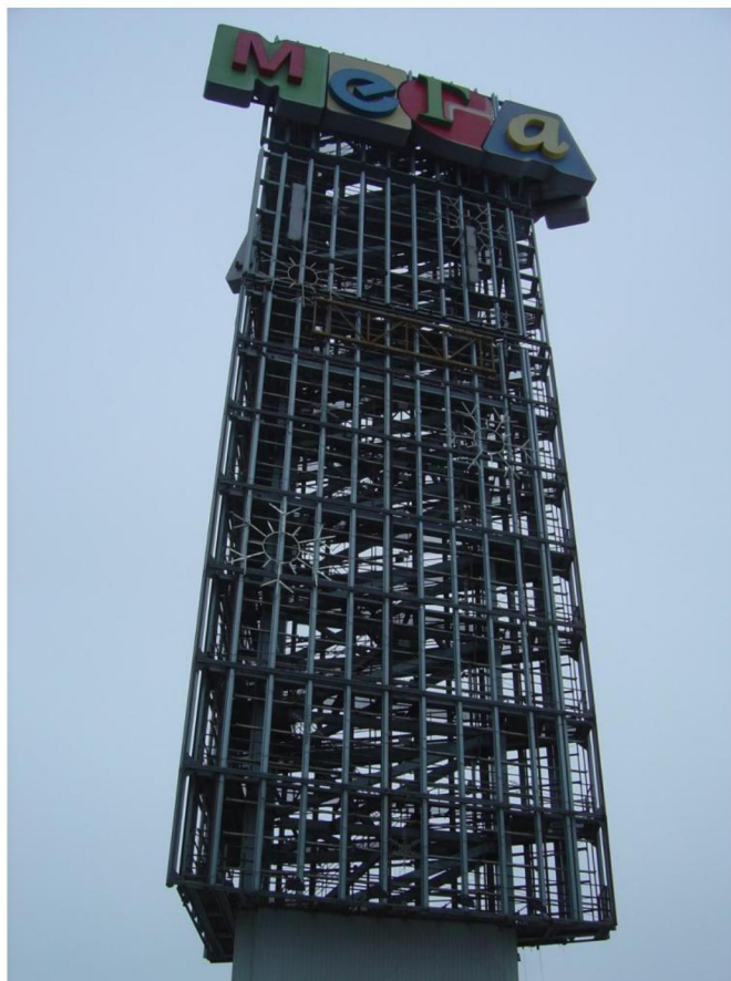
Фото 1. Общий вид рекламной башни в осях 1-2/В
