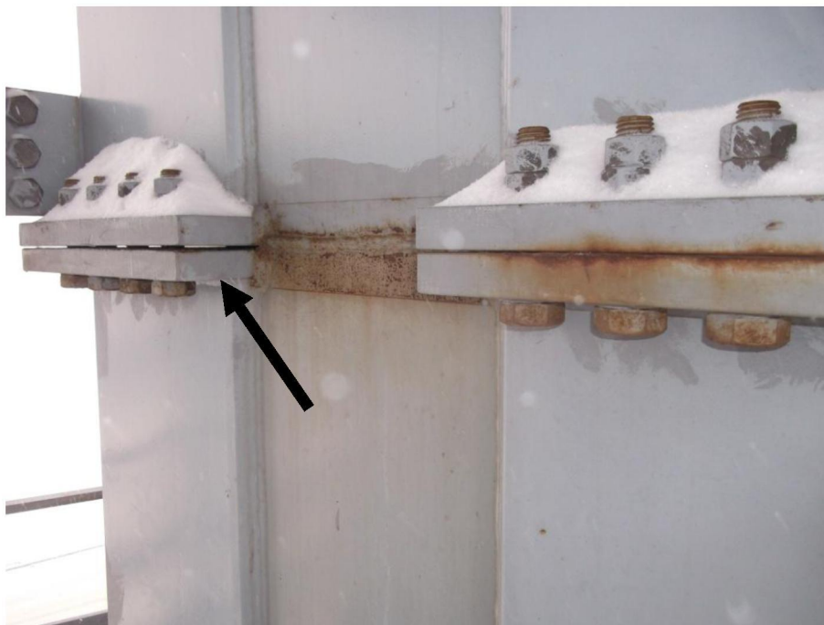
Фото 13. Узел укрупнительного стыка опоры в осях A_{+1,50}/2 на отметке +36,000. Зазор 6мм.
