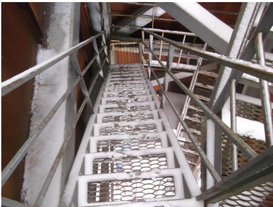
Фото 1. Общий вид лестницы в осях А-В/1
