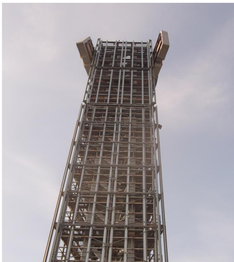
Фото 2. Общий вид рекламной башни в осях А-В/1
