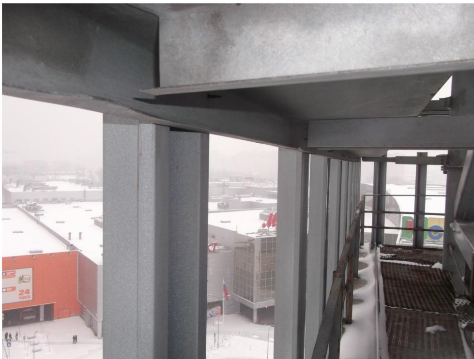
Фото 1. Местные деформации Z-образных профилей
