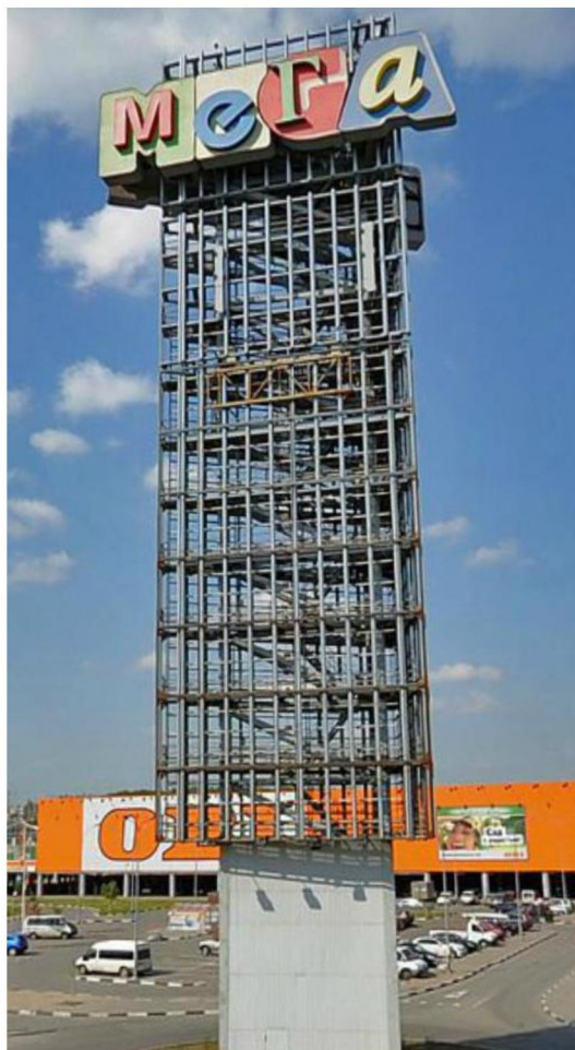
Фото 3. Общий вид рекламной башни в осях 1-2/А
