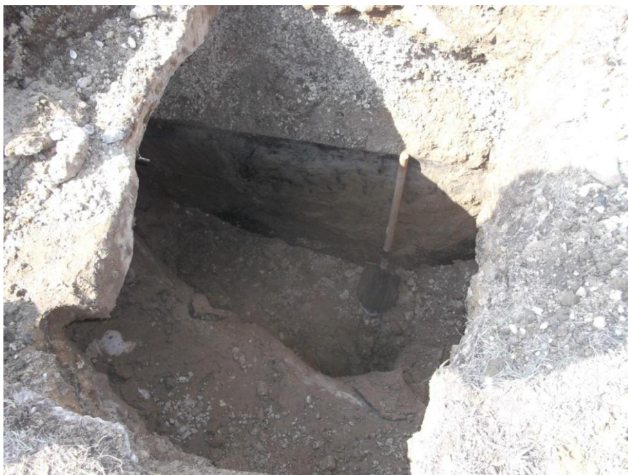
Фото 1. Общий вид шурфа
