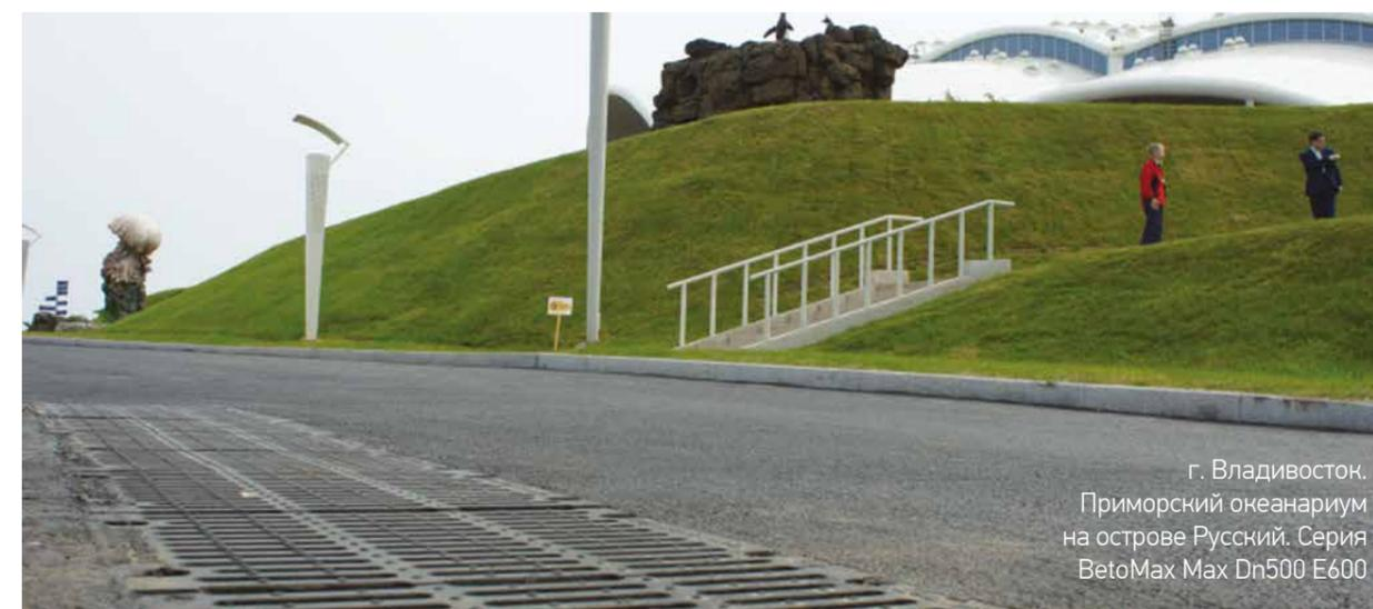
Лотки бетонные серия VetoMax® DN 400 Н 610 - Н 330 E600, F900
