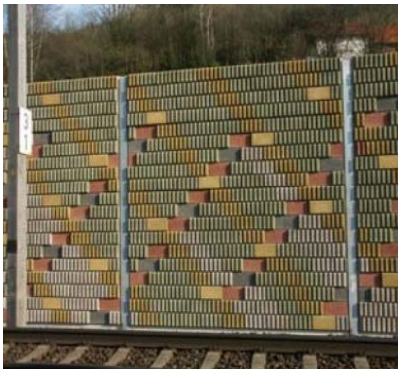
Рис.2.1.2 Экран с применением щепобетона
