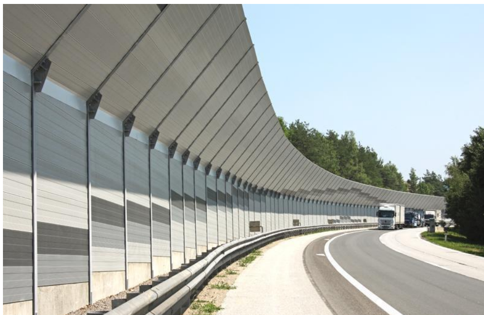
Рис. 3.2.1 – Шумозащитный экран с Г-образной надстройкой
