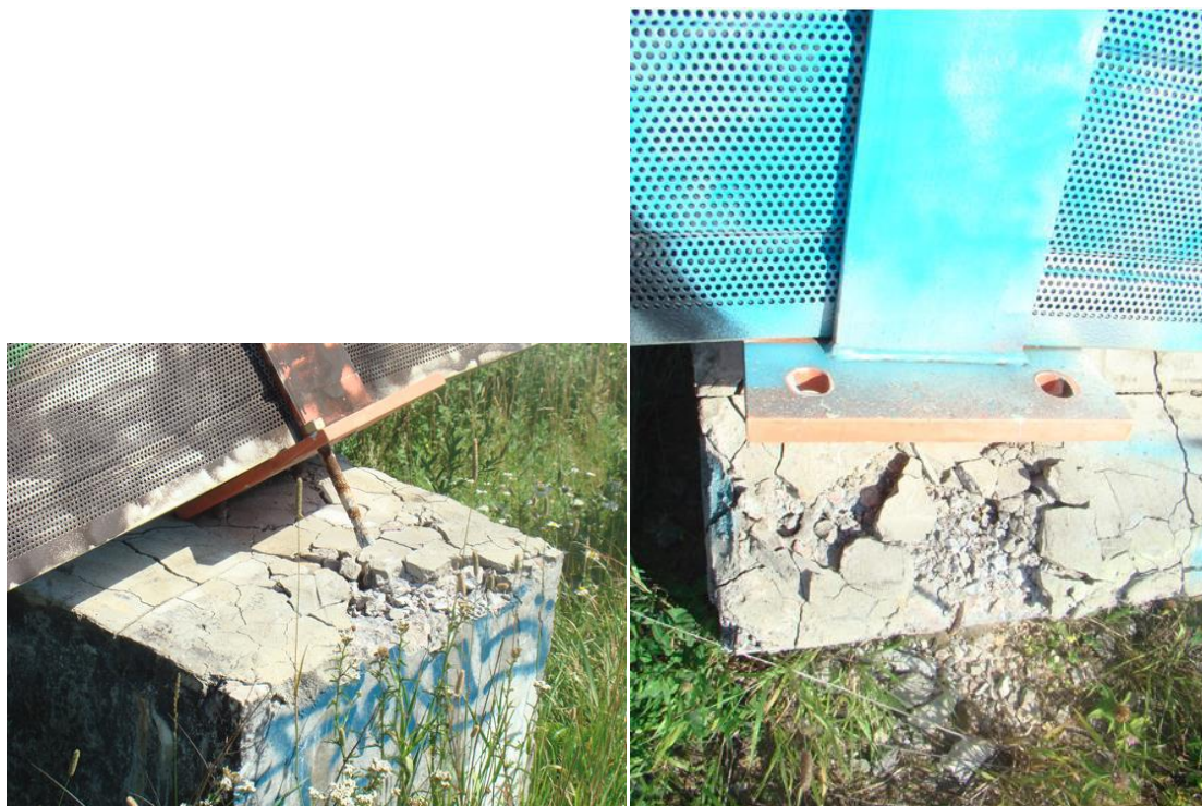
Рисунок 5.1.10 – Разрушение фундамента
