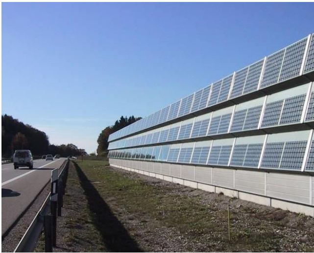
Рисунок 5.3.1 Шумозащитные экраны с интегрированными солнечными батареями
