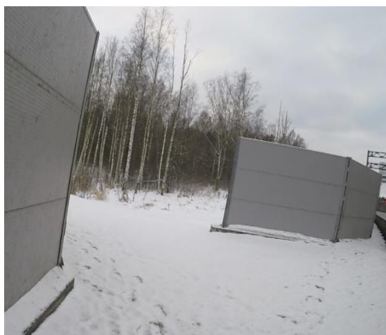
Рисунок 5.1.5 – Разрывы, не удовлетворяющие требованиям нормативных документов в области устройства шумозащитных экранов
