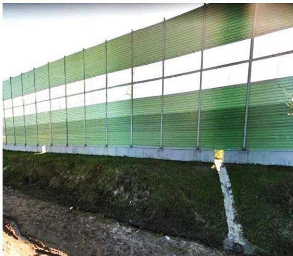
Рисунок 5.1.4– Образование проемов при организации водоотвода
