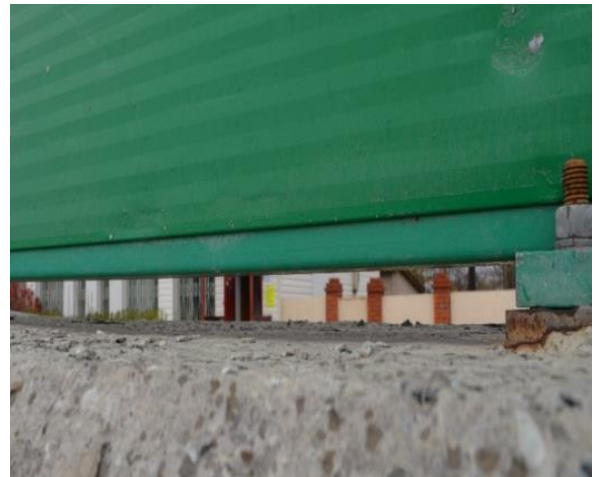
Рисунок 5.1.3 – Щели между акустическими панелями и фундаментом
