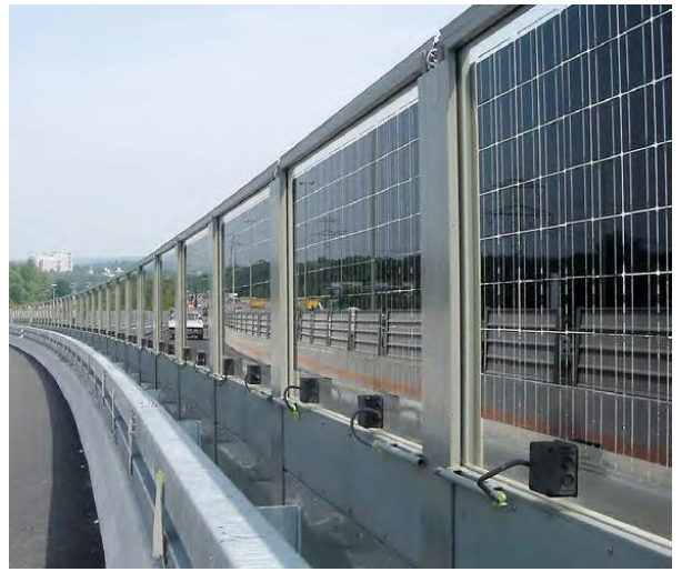
Рисунок 5.3.1 Шумозащитные экраны с интегрированными солнечными батареями
