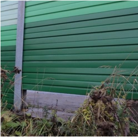
Рисунок 5.1.1 – Незаполненный зазор в местах устройства ступеней фундамента(наличие брешей)
