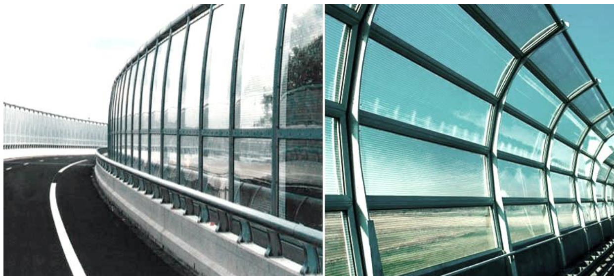
Рис. 3.2.4 Прозрачный шумозащитный экран
