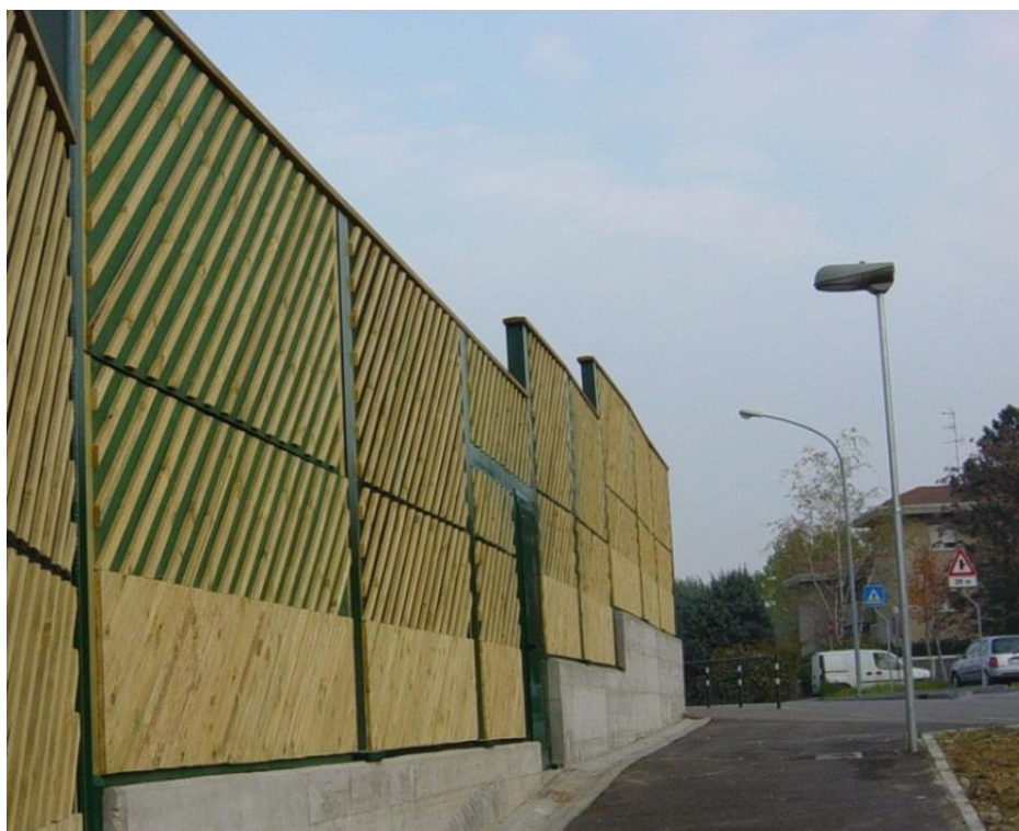
Рис.2.1.1 Экран из импрегнированной древесины
