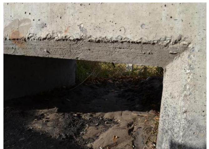
Рисунок 5.1.4– Образование проемов при организации водоотвода
