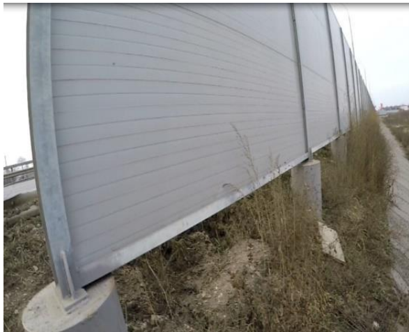
Рисунок 5.1.3 – Щели между акустическими панелями и фундаментом
