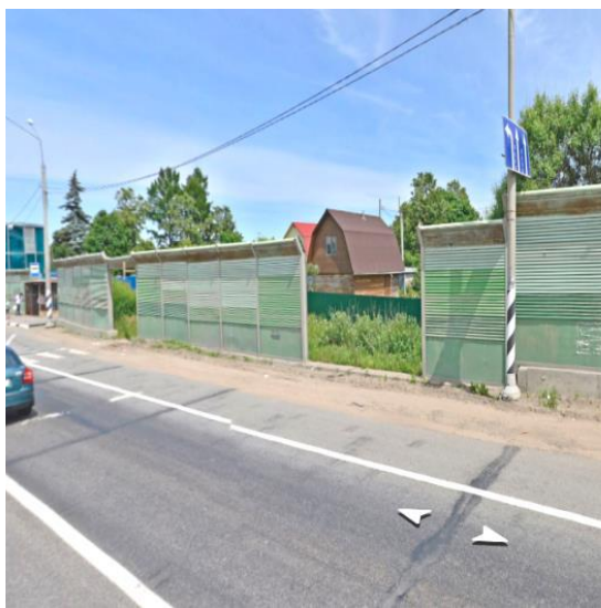
Рисунок 5.1.1 – Незаполненный зазор в местах устройства ступеней фундамента(наличие брешей)
