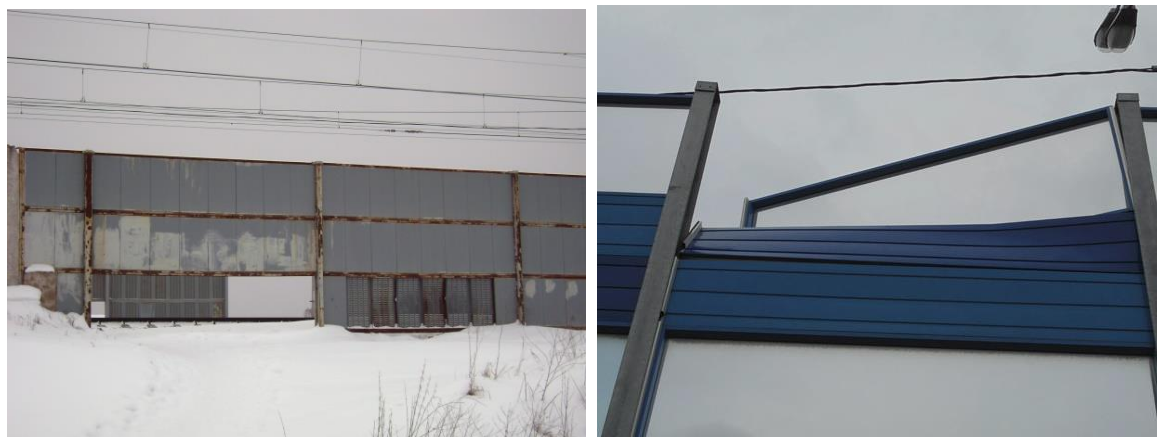
Рисунок 5.1.8– Выпадение панелей
