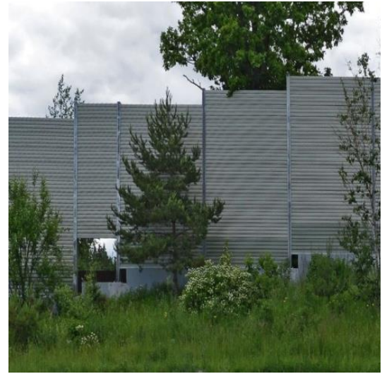
Рисунок 5.1.1 – Незаполненный зазор в местах устройства ступеней фундамента(наличие брешей)
