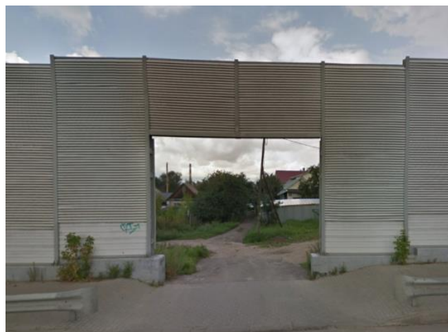
Рисунок 5.1.5 – Разрывы, не удовлетворяющие требованиям нормативных документов в области устройства шумозащитных экранов
