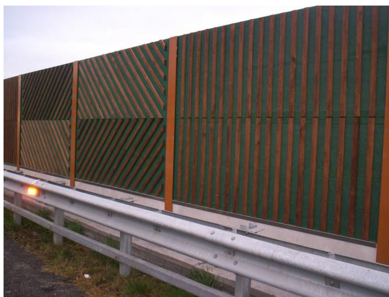
Рис. 3.2.4 Шумозащитный экран из импрегнированной древесины
