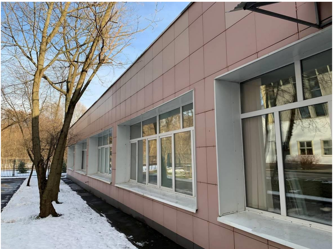
Фото 4. Общий вид фасада административной части
