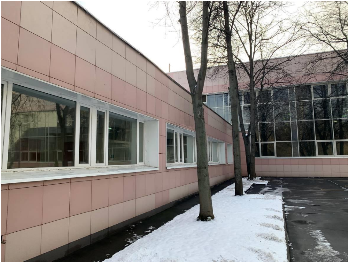
Фото 2. Общий вид фасадов здания, административной части и спортивных залов.
