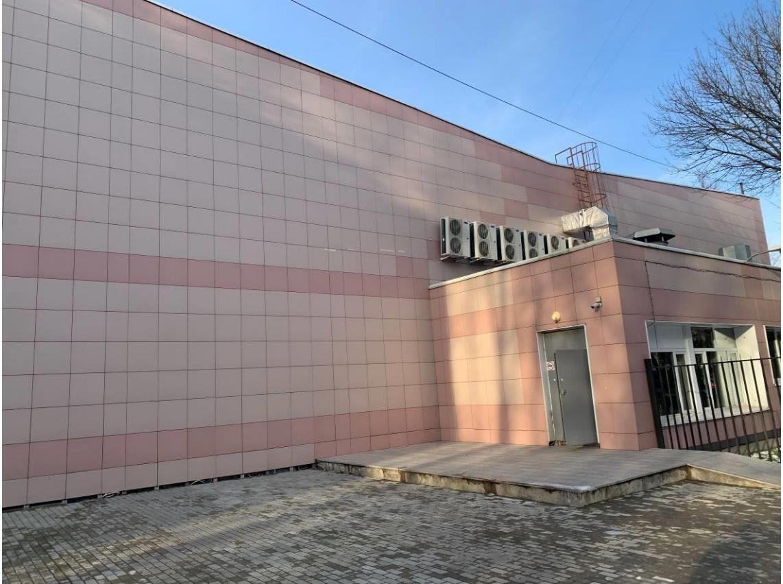
Фото 1. Общий вид здания
