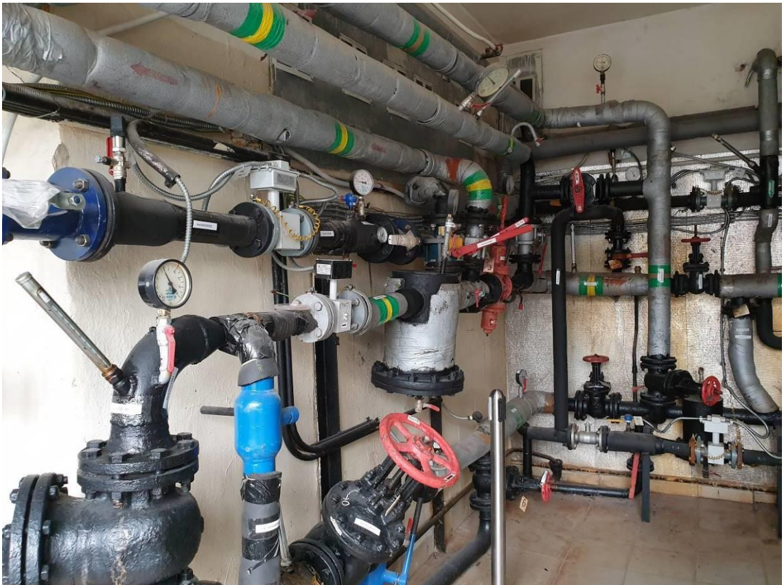
Фото 22. Разводка трубопроводов на отопление и ГВС.
