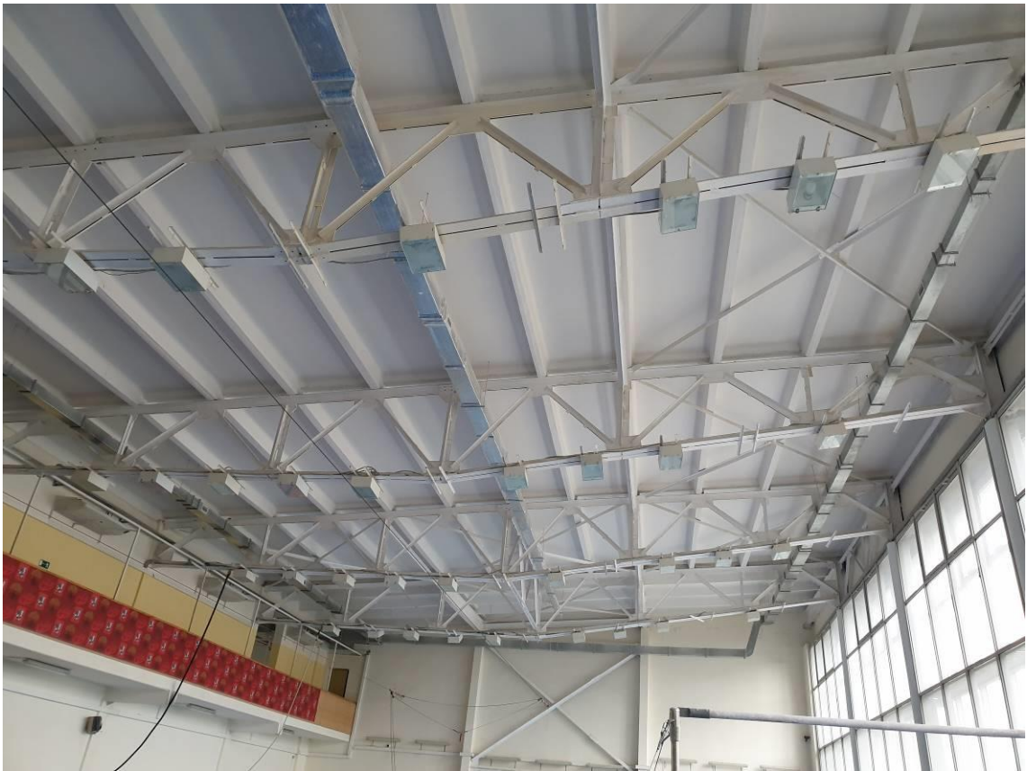
Фото 34. Разводка коробов вентиляции в зале.
