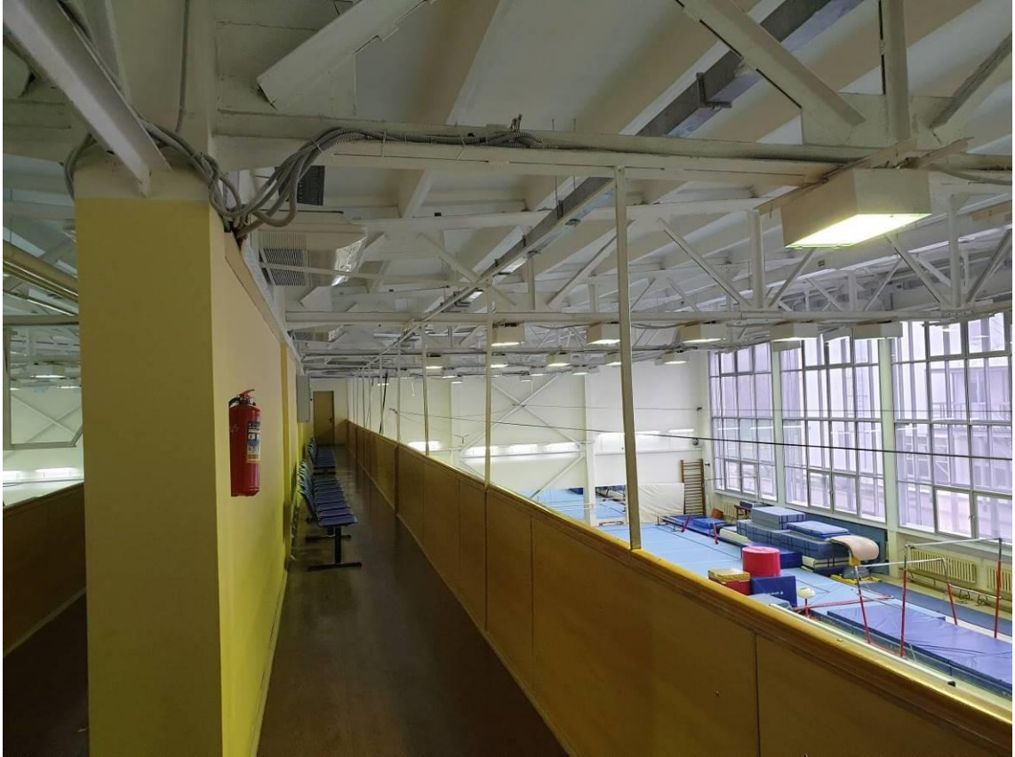
Фото 15. Балкон, общий вид. Ограждения балкона.
