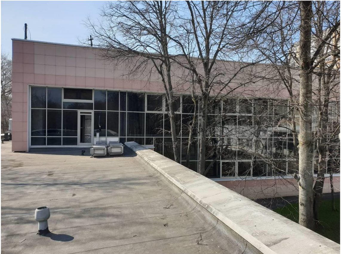
Фото 7. Вид на здание с кровли.
