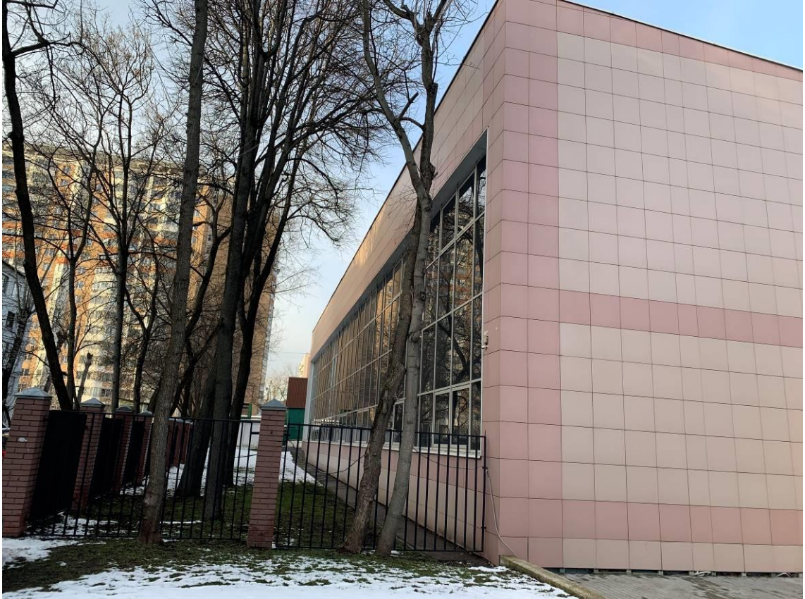
Фото 3. Общий вид торцевого фасада здания
