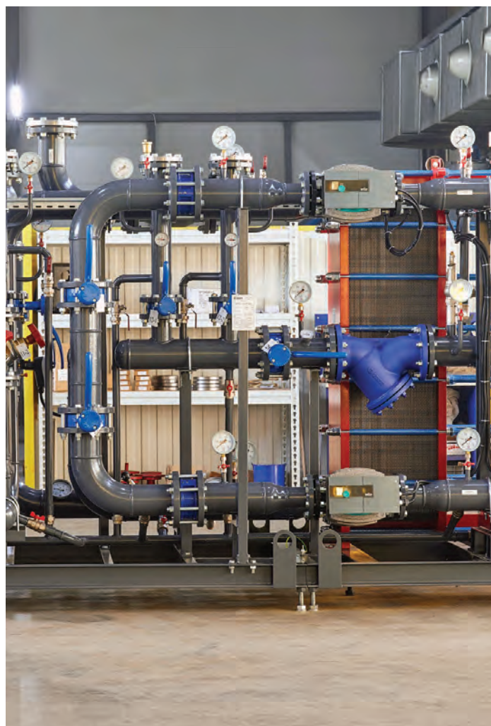
8. Финальная сборка, электромонтаж, упаковка
