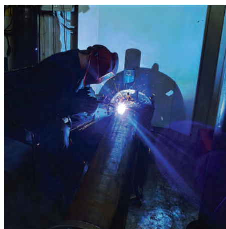
5. Сварка в сварочном вращателе
