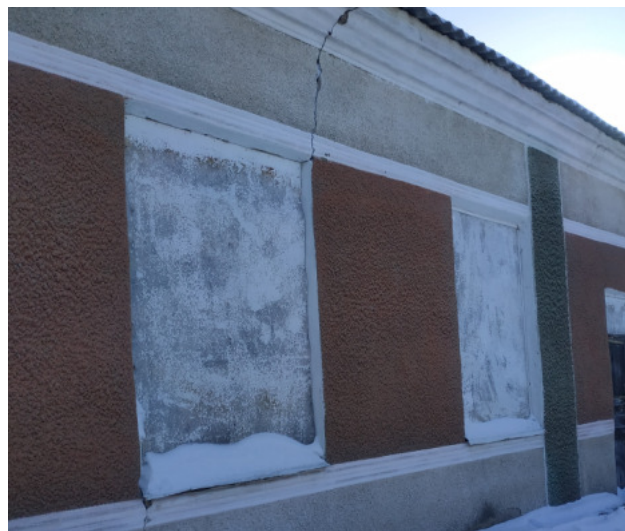
Рис.19 Защищенные оконные проёмы.
