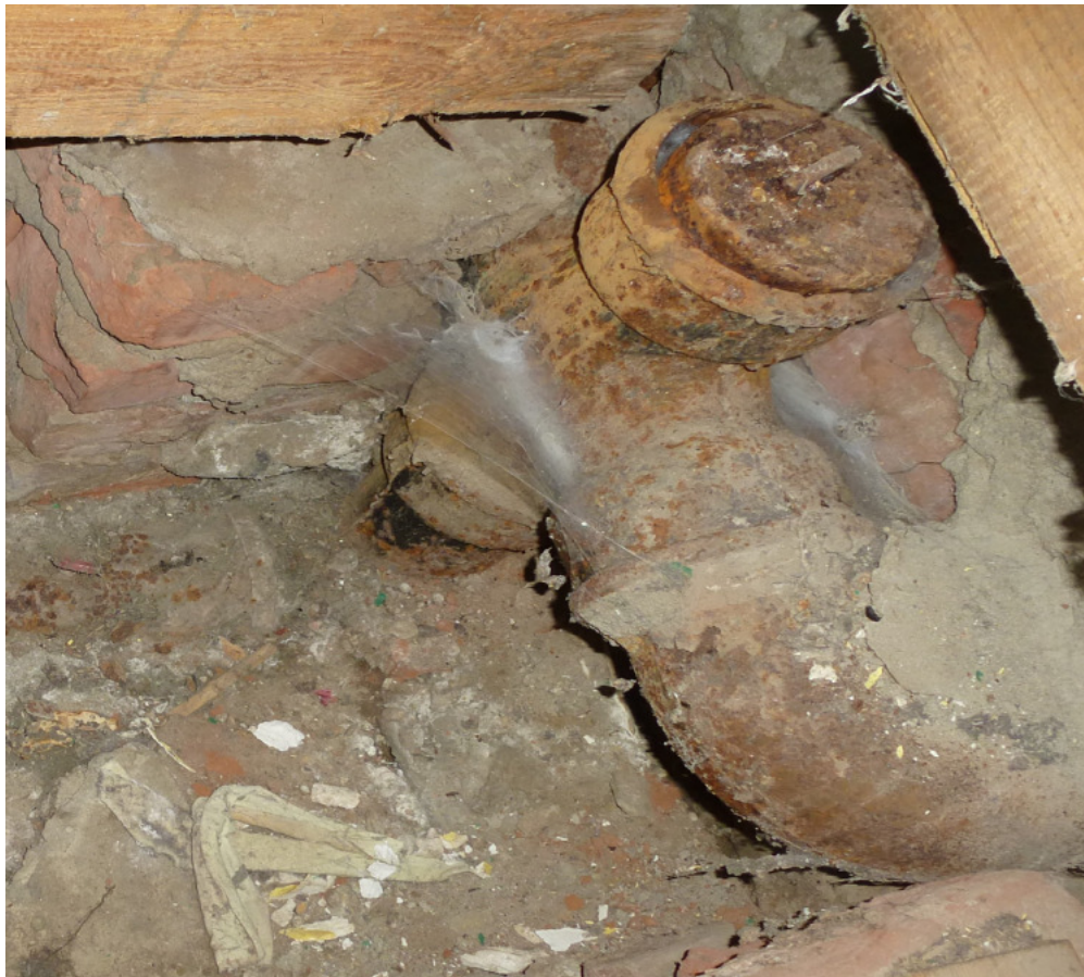
Рис.27 Чугунные трубы канализации.
