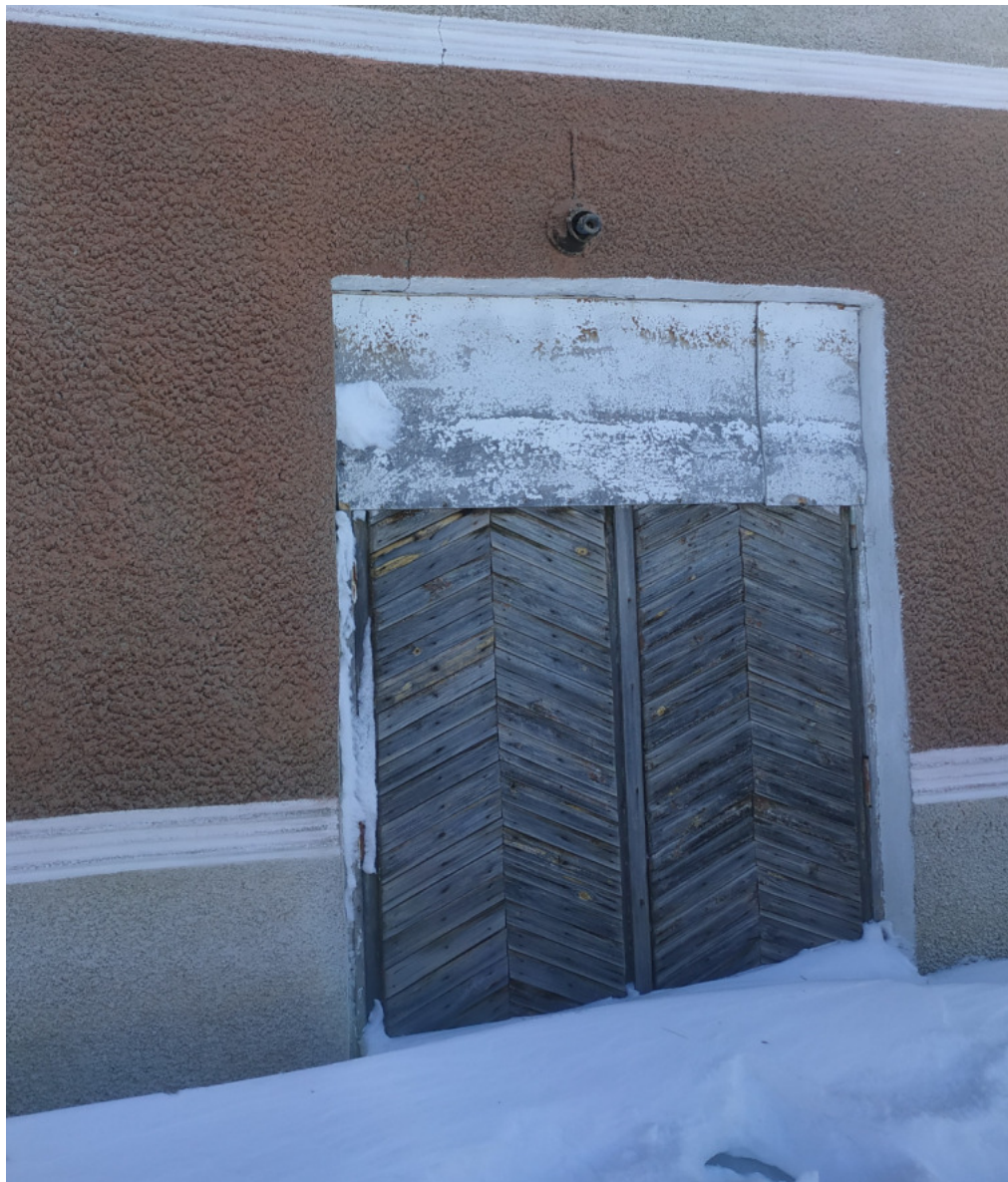
Рис.22 Дверь, зашитая изнутри.
