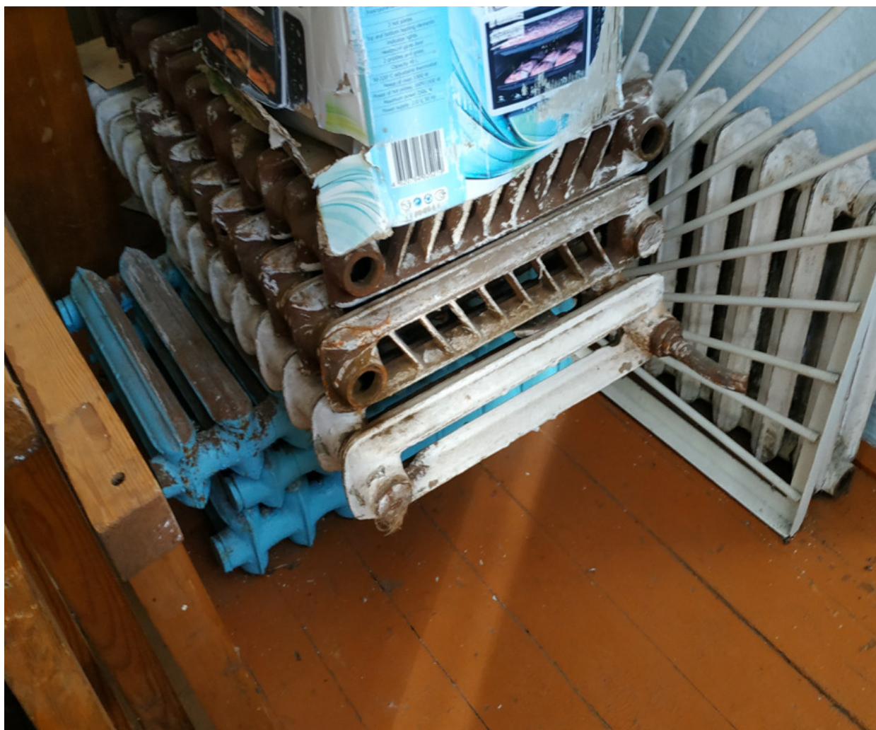
Рис.26 Демонтированные радиаторы отопления.
