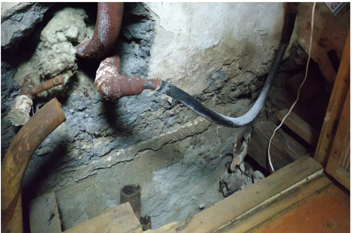
Рис.4 Фундамент наружной стены Клуба.
