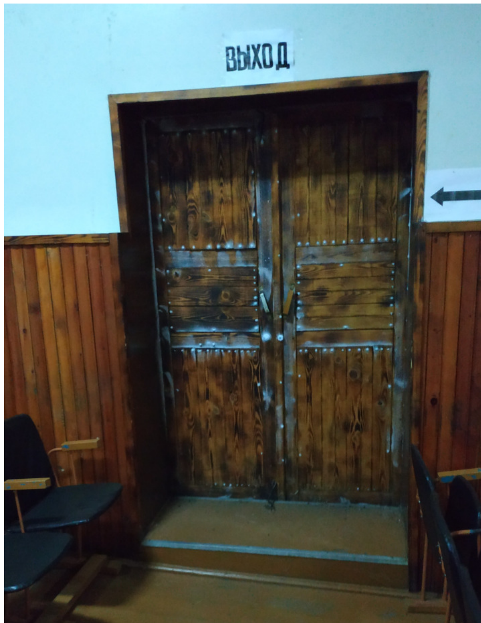
Рис.21 Дверь эвакуационного выхода из зрительного зала.
