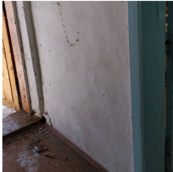
Рис.18 Повреждения перегородки.
