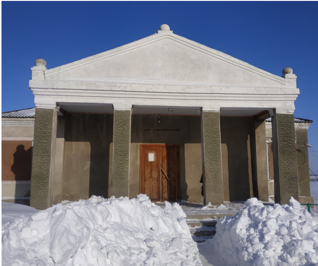
Рис.2 Обследуемое здание Клуба.
