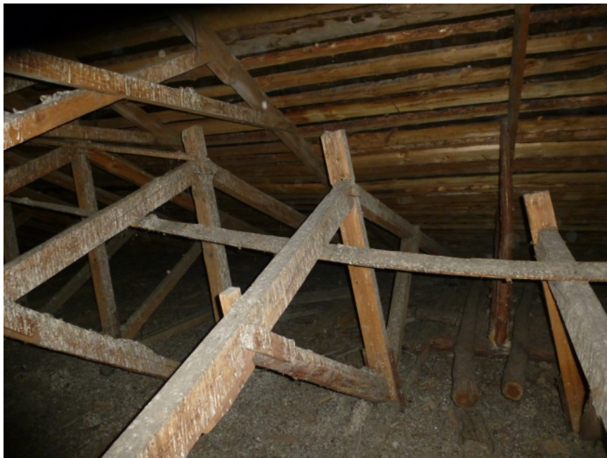
Рис.12 Отклонения от вертикали верхнего пояса ферм.
