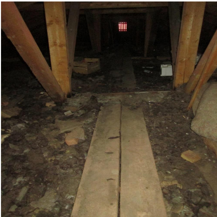
Фото Б.24-25. Общий вид стропильной системы
