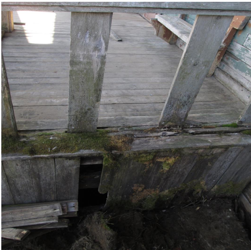
Фото Б.9. Гниение конструкции крыльца и начало разрушения
