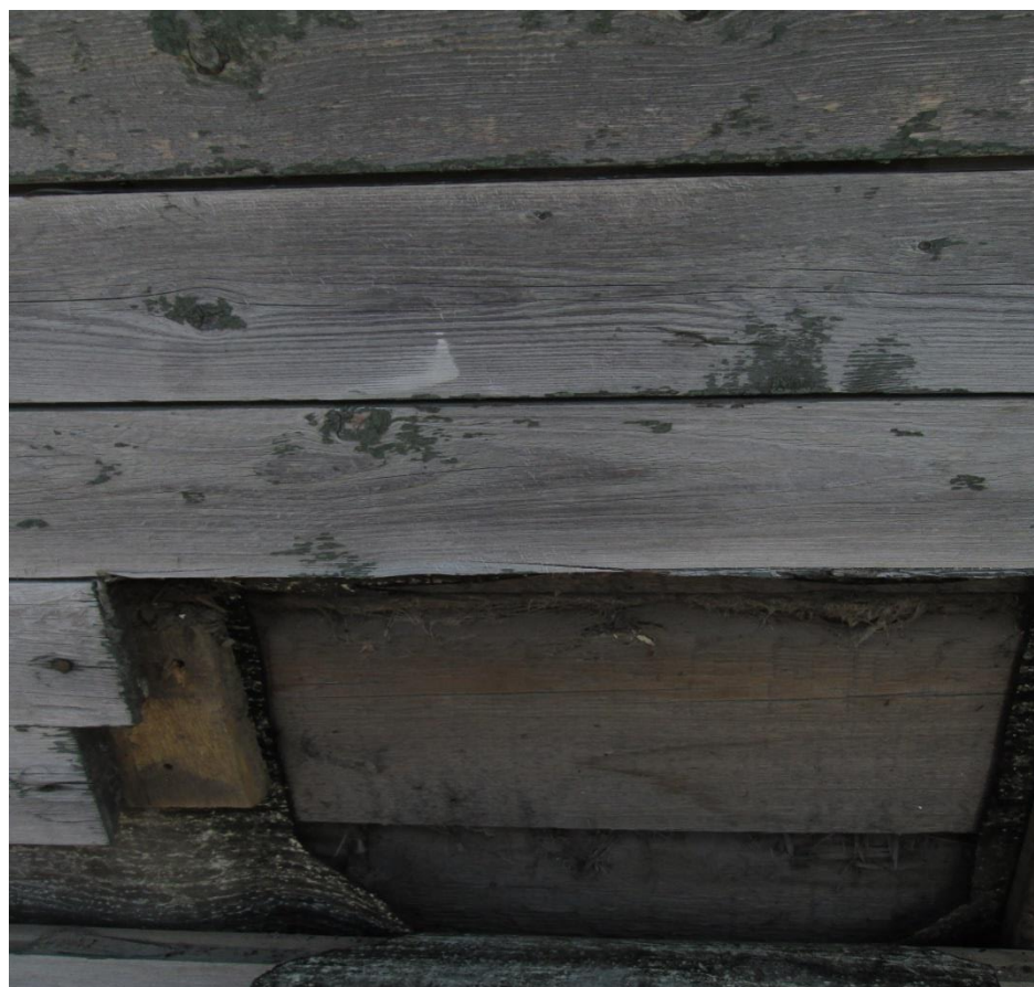
Фото Б.10-106. Вскрытие фасада
