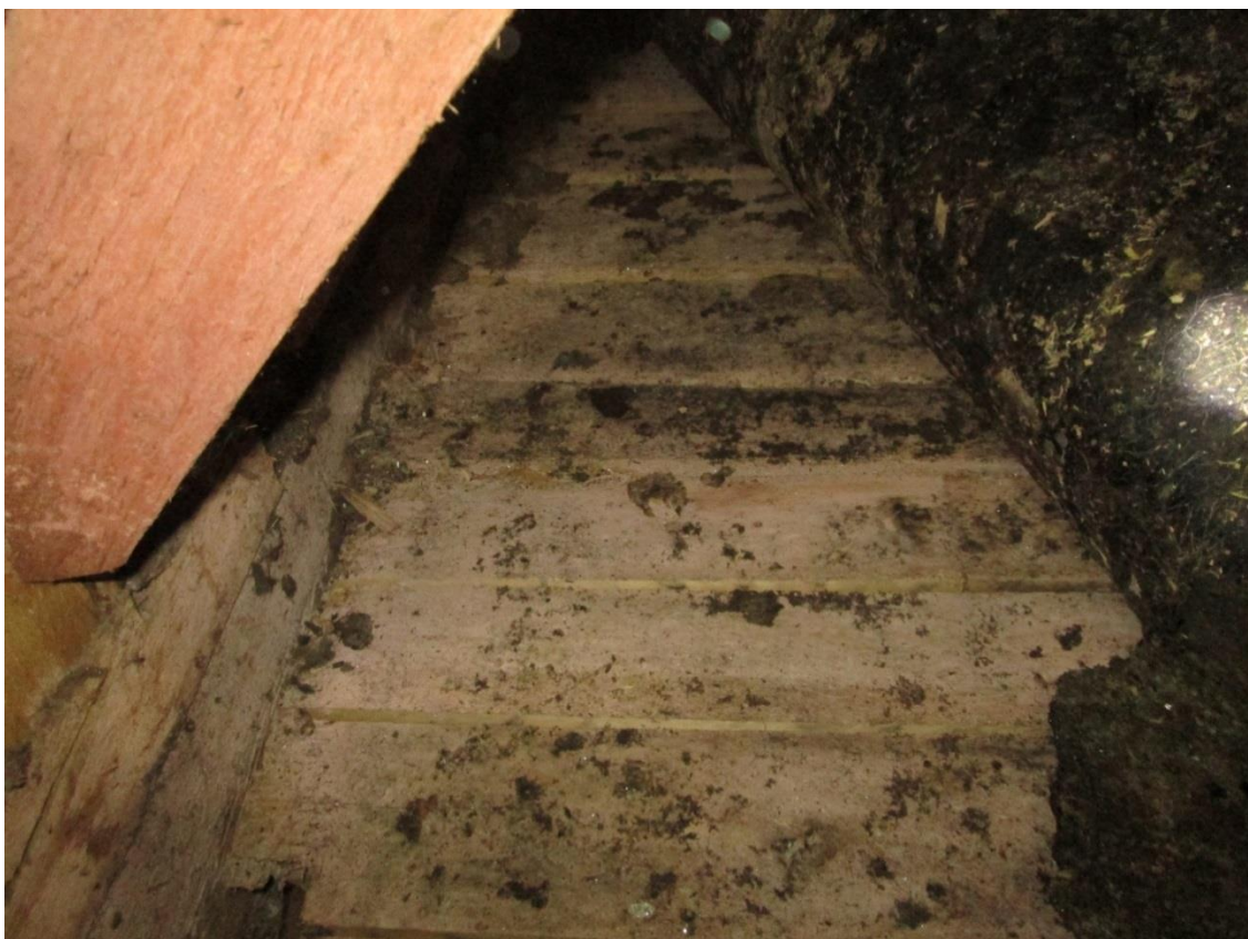
Фото Б.23. вскрытие чердачного перекрытия
