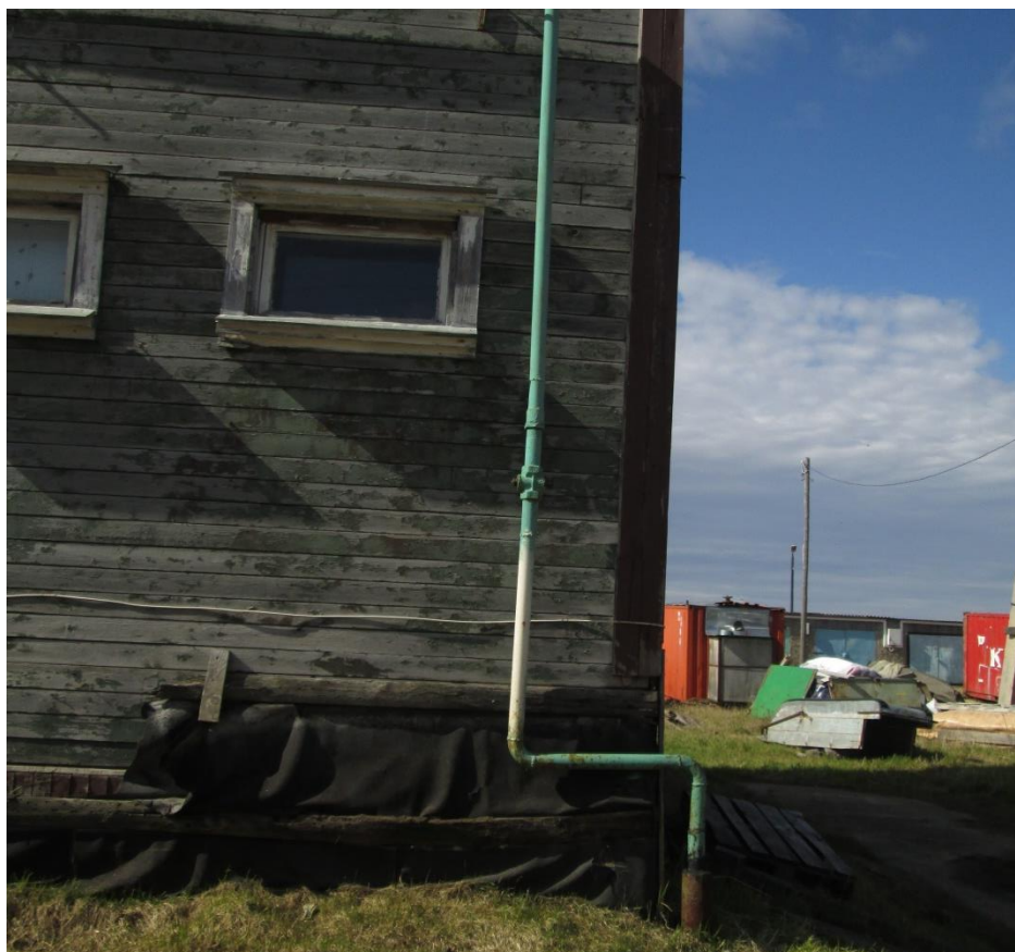
Фото Б.31. ввод газопровода
