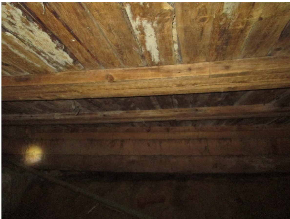
Фото Б.16. поражение плесенью и гнилью дощатого наката
