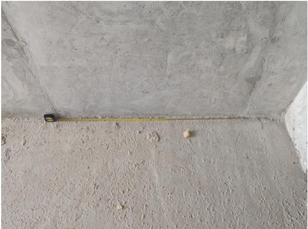
Фото ПЗ.7. Замеры геометрических характеристик монолитных ж/б стен обследуемых помещений здания
