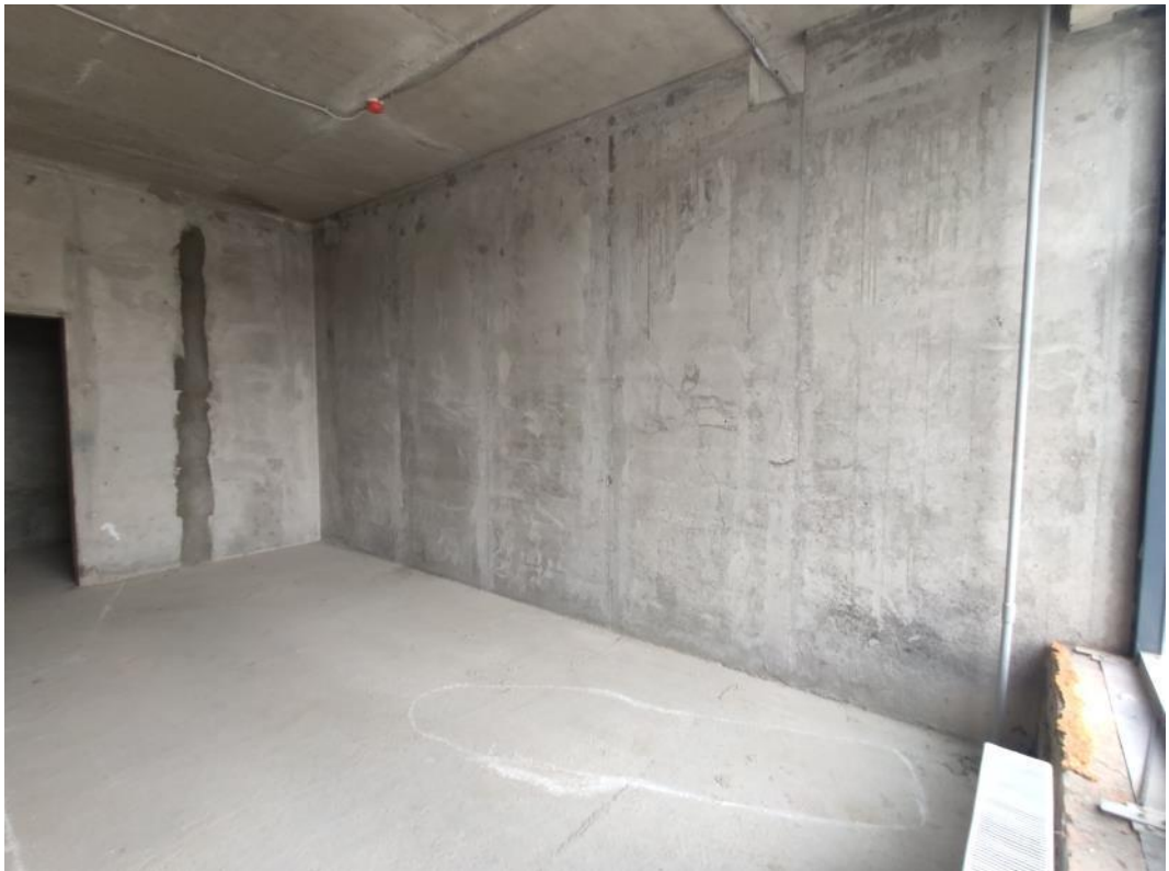
Фото ПЗ.4. Общий вид обследуемых помещений
