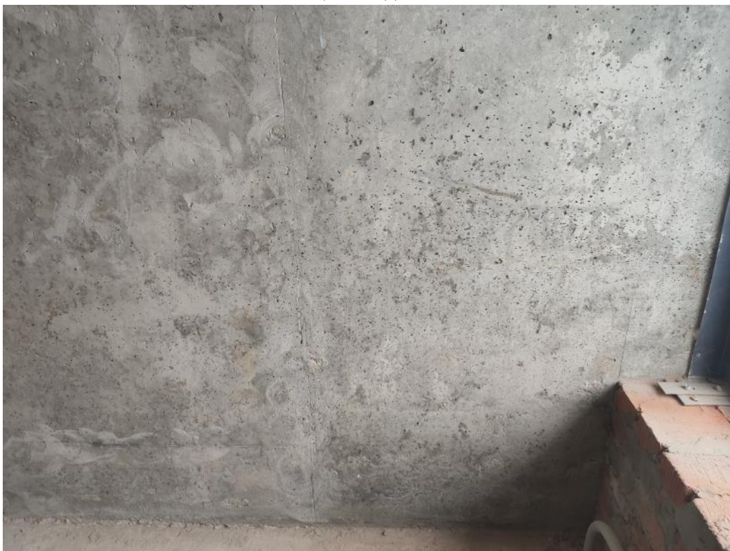
Фото ПЗ.10. Обследуемые монолитные ж/б стены
