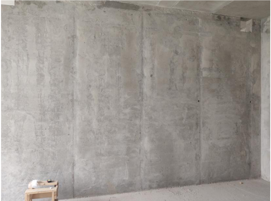
Фото ПЗ.3. Общий вид обследуемых помещений
