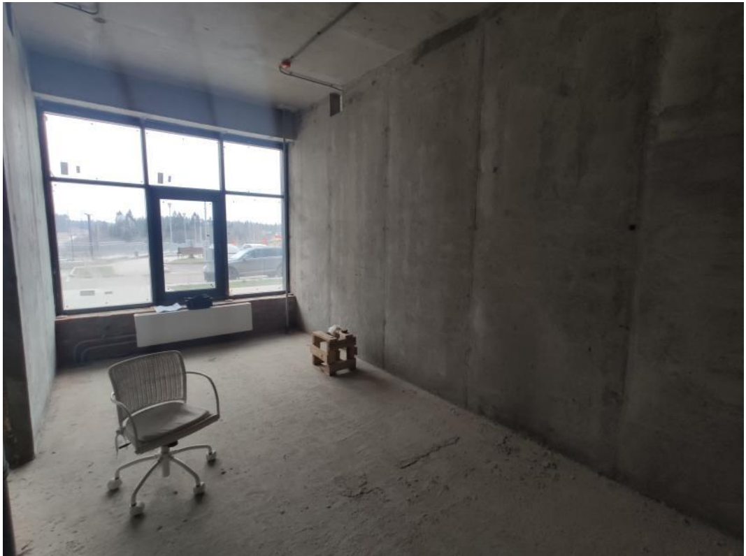
Фото ПЗ.5. Общий вид обследуемых помещений
