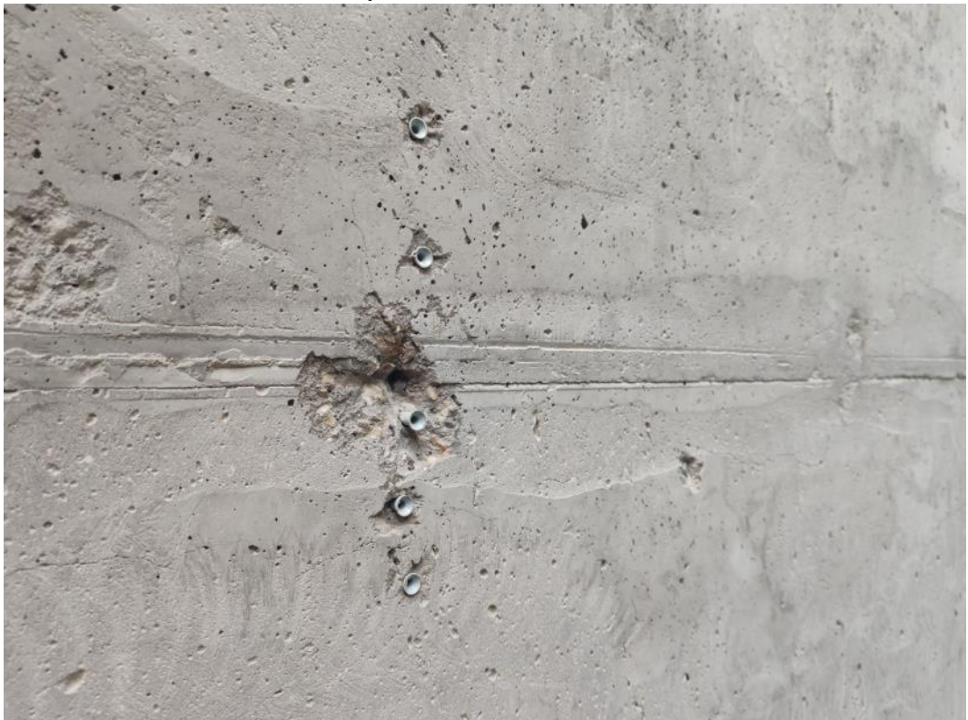
Фото ПЗ.8. Обследуемые монолитные ж/б стены
