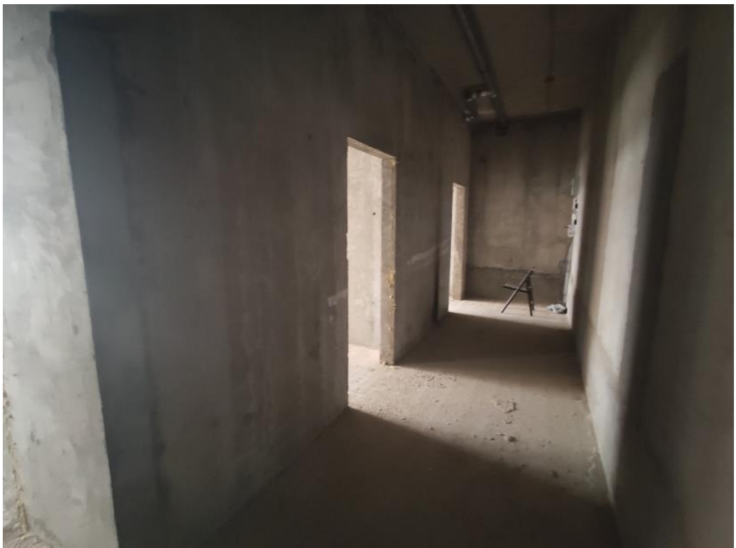
Фото ПЗ.6. Общий вид обследуемых помещений
