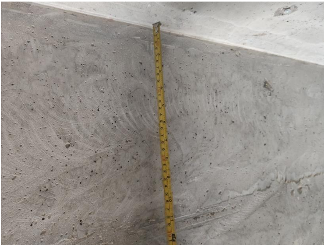
Фото ПЗ.9. Замеры геометрических характеристик монолитных ж/б стен обследуемых помещений здания
