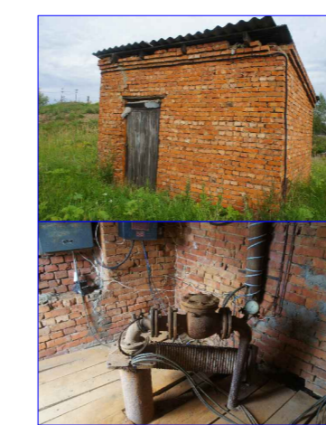
скважина №1. (6 куб.час) состояние плохое
