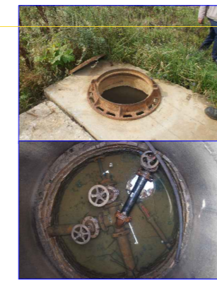
колодец ВК 19. обеспечение поселка
