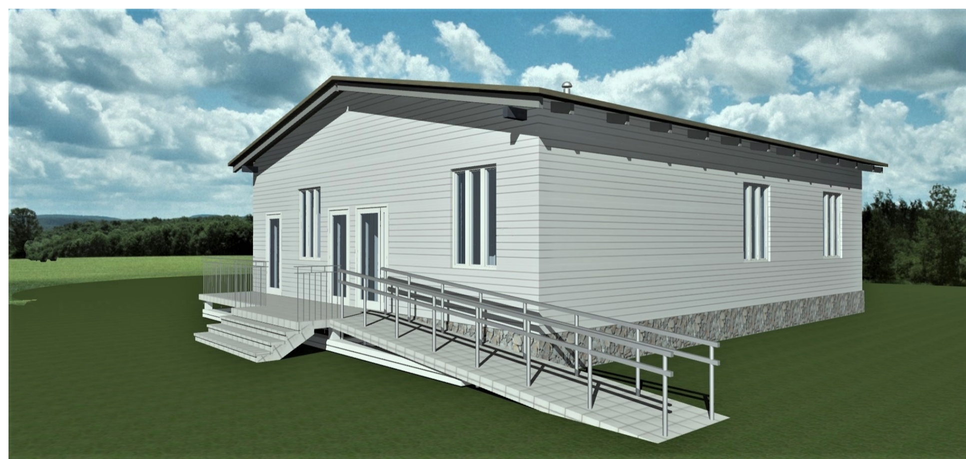
«Фельдшерско-акушерский пункт» п. Кирпичный Ханты-Мансийского района, расположенного по адресу: Тюменская область, ХМАО-Югра, Ханты-Мансийский район, п. Кирпичный
