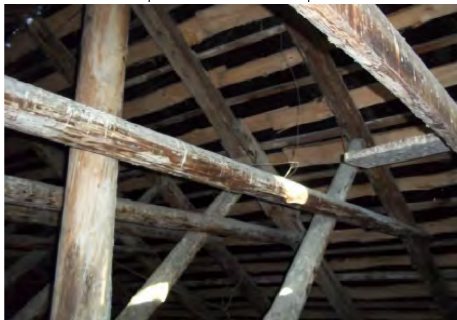
Существующее состояние стропильной и подстропильной систем кровли
