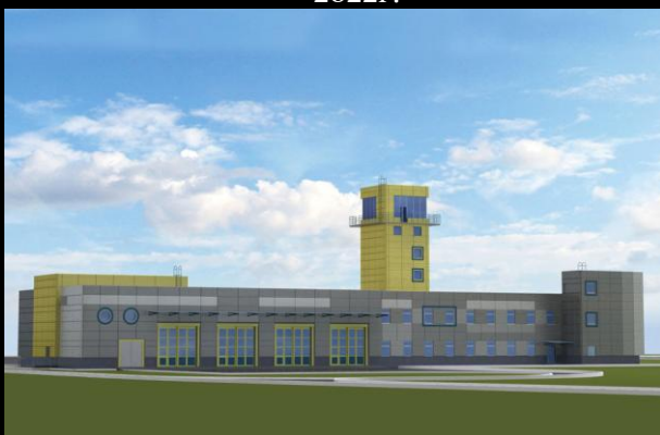
Выполнение работ по проектированию и строительству объекта «Строительство САСС в аэропорту «Победилово» (г. Киров)» 2022г.
