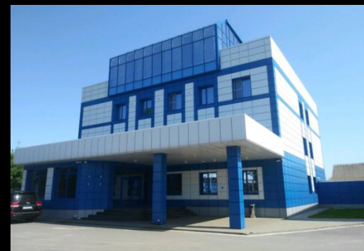
ООО «ПК «Курскэкспортхлеб» Разработка проектной документации по :Административно-бытовое здание , Лаборатория , помещение для хранения автомобилей
