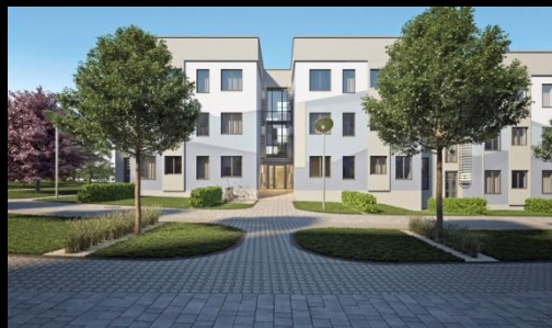
ООО «Белгеоцентр» Строительство водоводов к МКР «Новая жизнь», расположенного по адресу :г. Щебекино, ул. Нижегольское шоссе 2019г.
