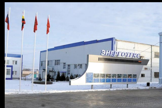
Производственные объекты на территории АО «Энерготекс» в г. Курчатове Курской области. Реконструкция производственных объектов
