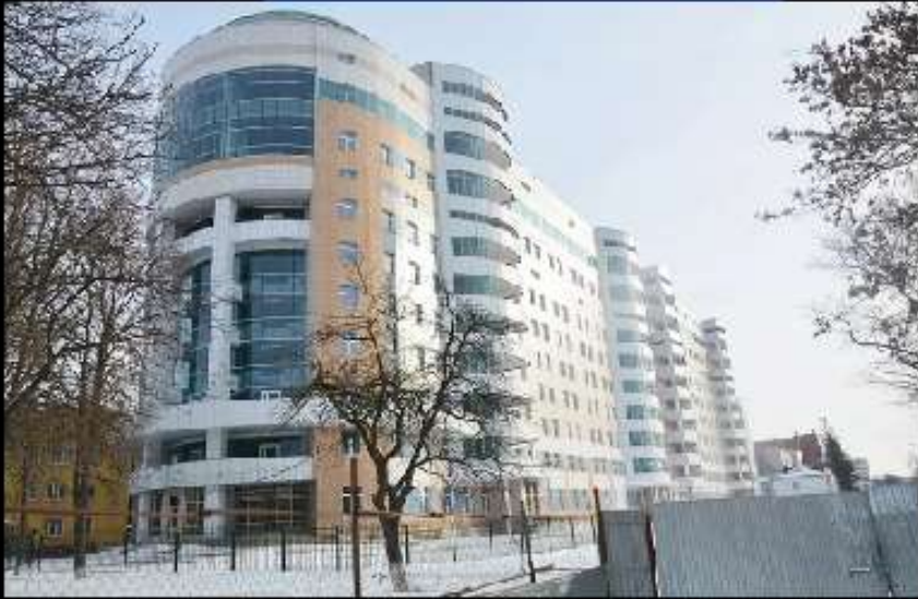
Строительство областной клинической больницы г. Орел. Проектные работы 2019-2022 год., 11.2 мл. руб.
