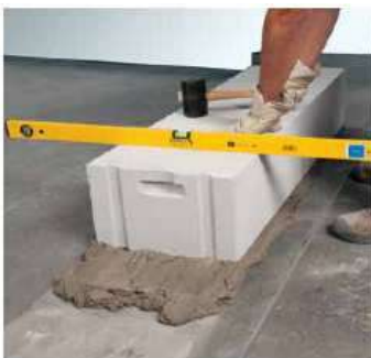
Выравнивание с использованием уровня и резинового молотка
