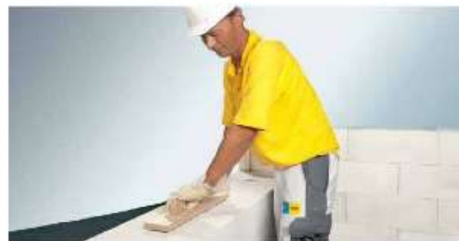
Шлифовка с использованием рубанка
