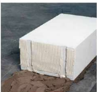
Вертикальный шов первого углового элемента
