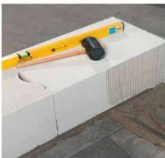
Готовая кладка 1-го ряда на растворе
