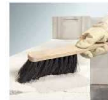
Удаление пыли и загрязнений при помощи щетки
