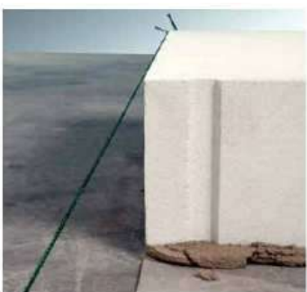
Шнур-причалка для ориентации высоты укладки блоков
