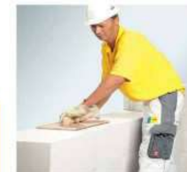
Выравнивание с использованием шлифовальной доски
