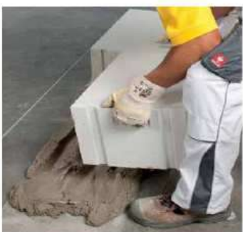
Вертикальный шов первого углового элемента
