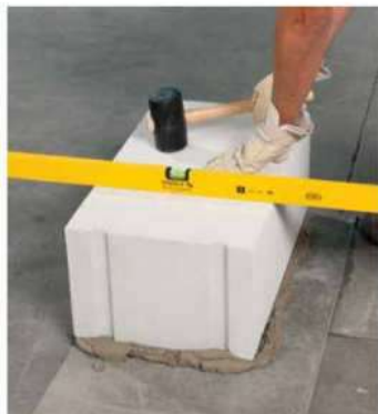
Выравнивание с помощью уровня и резинового молотка
