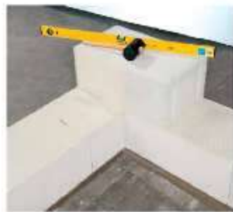
Закладка углового элемента второго ряда
