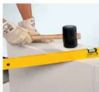
Проверка и корректировка при помощи уровня и резинового молотка
