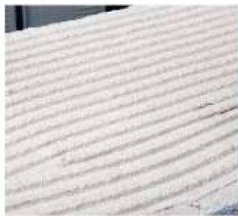
Равномерное нанесение раствора
