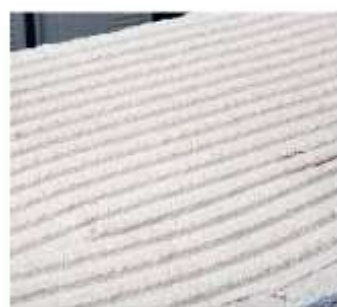
Равномерное нанесение раствора
