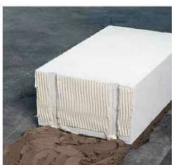
Вертикальный шов первого углового элемента
