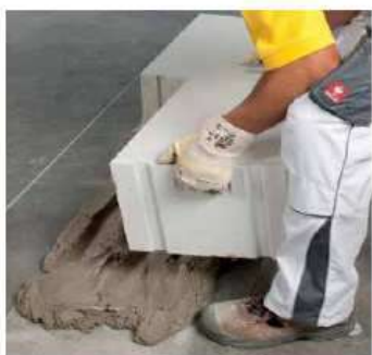
Вертикальный шов первого углового элемента
