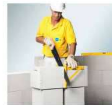
Резка вручную
