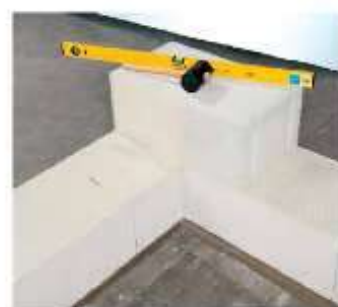
Закладка углового элемента второго ряда
