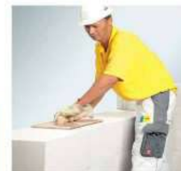
Выравнивание с использованием шлифовальной доски
