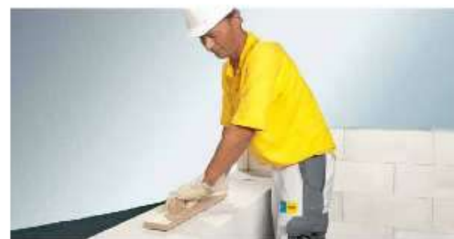
Шлифовка с использованием рубанка
