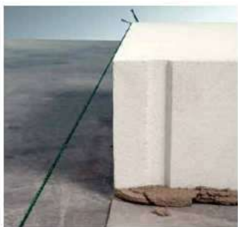
Шнур-причалка для ориентации высоты укладки блоков
