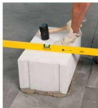
Выравнивание с помощью уровня и резинового молотка
