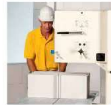
Резка с использованием ленточной пилы
