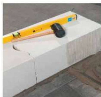
Готовая кладка 1-го ряда на растворе
