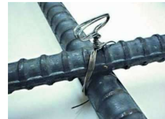
Вязальная проволока для соединения продольной и поперечной арматуры
