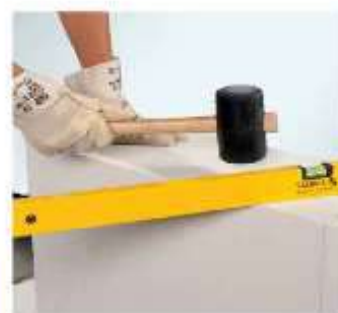
Проверка и корректировка при помощи уровня и резинового молотка
