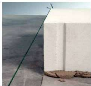
Шнур-причалка для ориентации высоты укладки блоков
