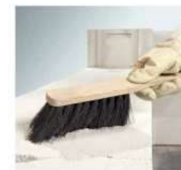
Удаление пыли и загрязнений при помощи щетки
