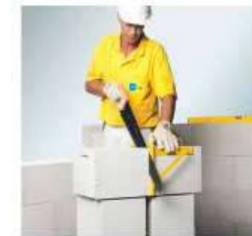
Резка вручную
