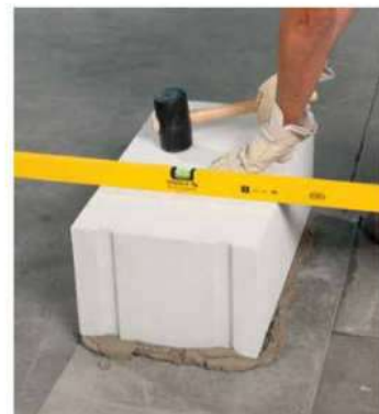
Выравнивание с помощью уровня и резинового молотка
