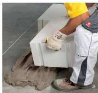
Вертикальный шов первого углового элемента
