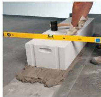
Выравнивание с использованием уровня и резинового молотка
