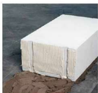
Вертикальный шов первого углового элемента
