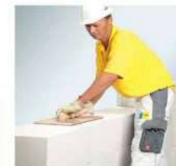
Выравнивание с использованием шлифовальной доски
