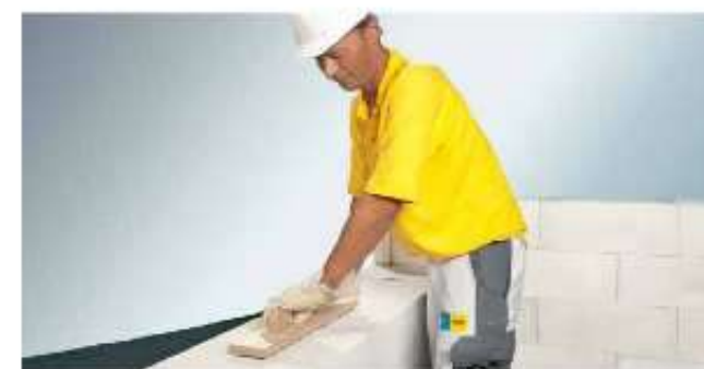
Шлифовка с использованием рубанка
