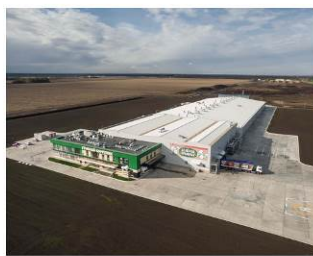
Тепличный комплекс по выращиванию шампиньонов и производству компоста Краснодарский край
