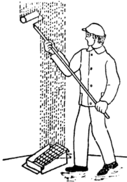
Рис.1. Окраска поверхностей валиком
