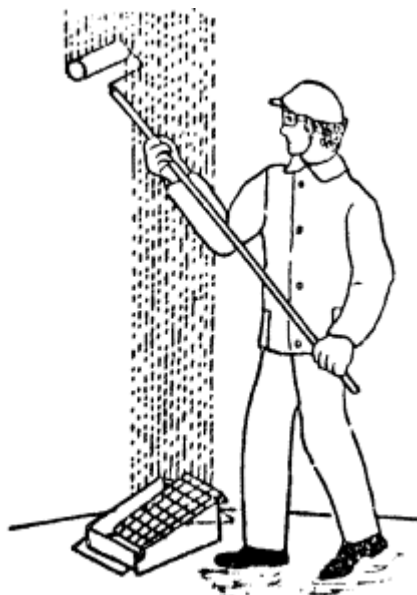
Рис.1. Окраска поверхностей валиком
