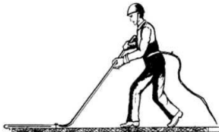
Рисунок 3.10. Снятие карнизного свеса
