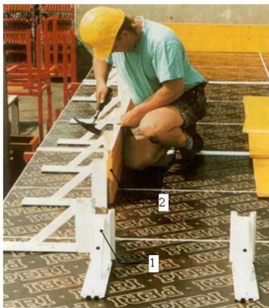
Рисунок 3.11. Установка отсекателей: 1-кронштейн отсекателя; 2-палуба отсекателя
