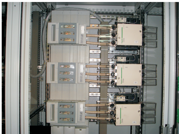
Предохранители-разъединители и управляющие контакторы ТЭНов
