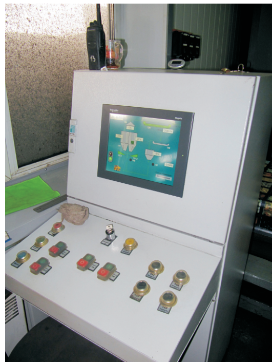
Пульт управления бункеровщиком
