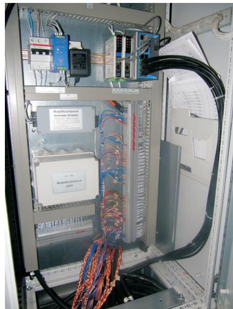
Искробезопасные цепи и коммуникационное оборудование ШУ
