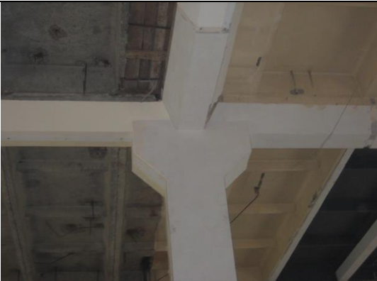
Фото №5. Общий вид на узел опирания ж/б балок на колонну.
