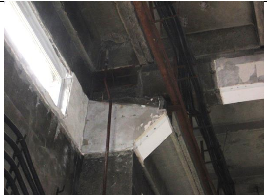
Фото №4. Узел опирания ж/б балки на колонну.
