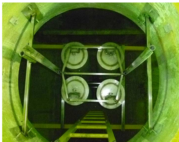
Губчатые фильтры направленного действия для улавливания мелкодисперсной взвеси и остаточных нефтепродуктов.
