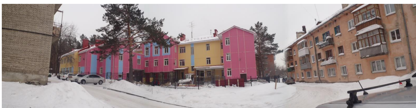
Реконструкция Детсада ул.Узорная, г.Новосибирск.
