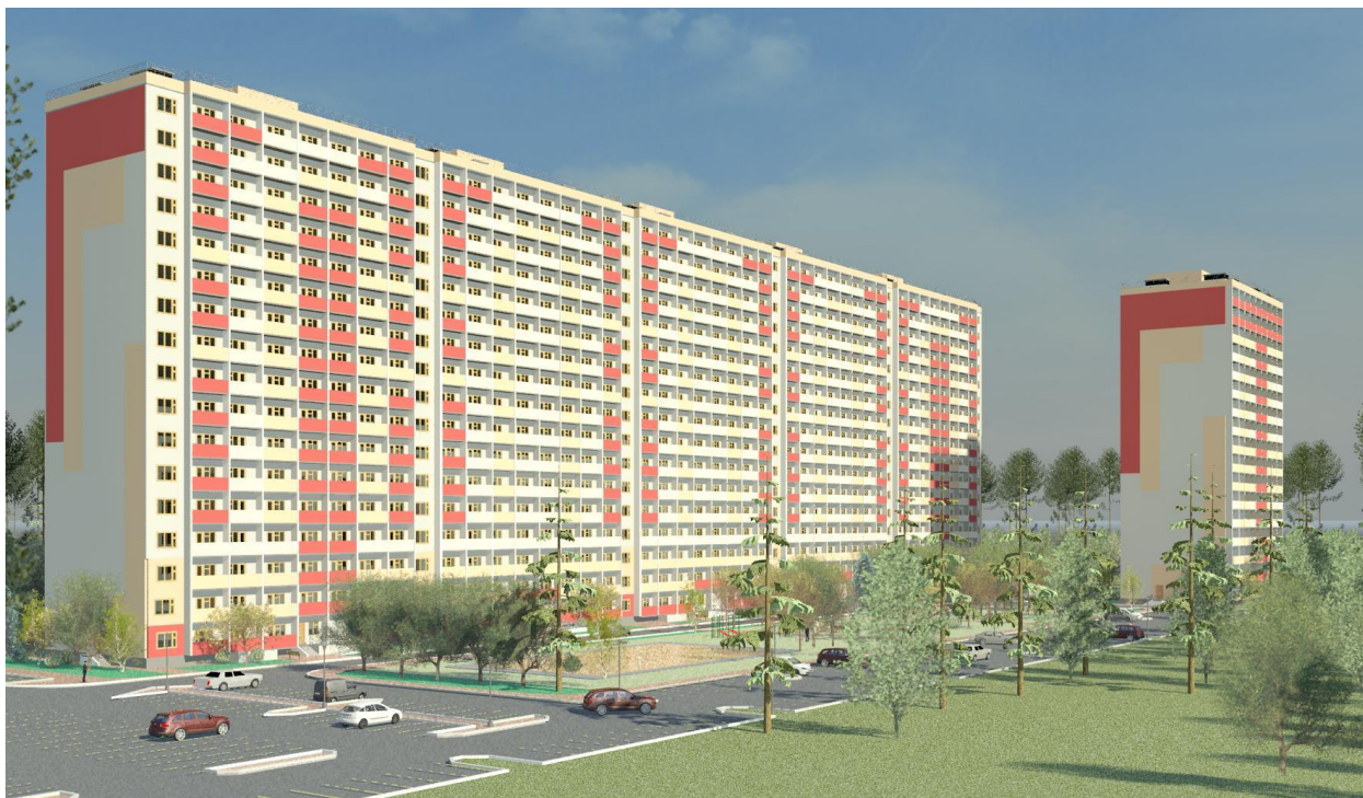
Многоквартирные жилые дома по ул. Петухова г.Новосибирск.
