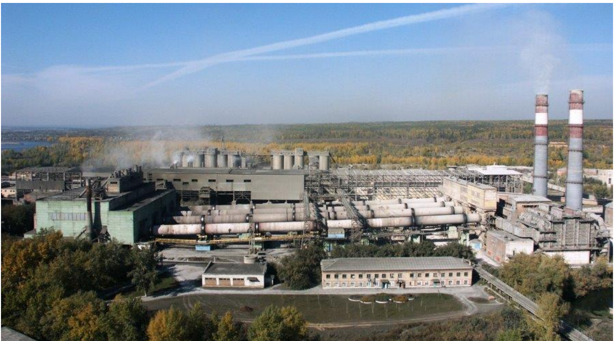
Реконструкция Завода «Искитимцемент».
