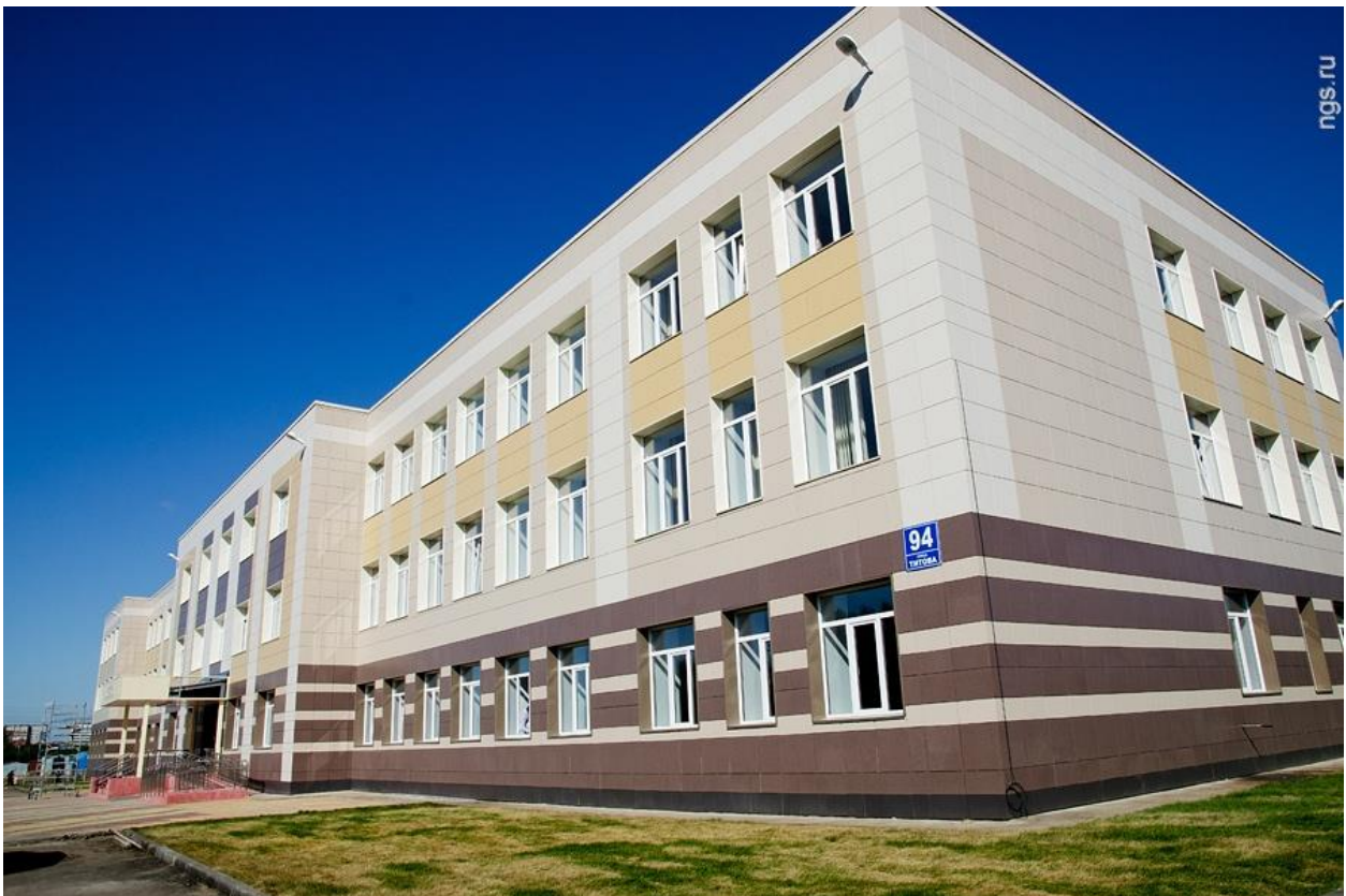
Школа на ул.Титова г.Новосибирск.
