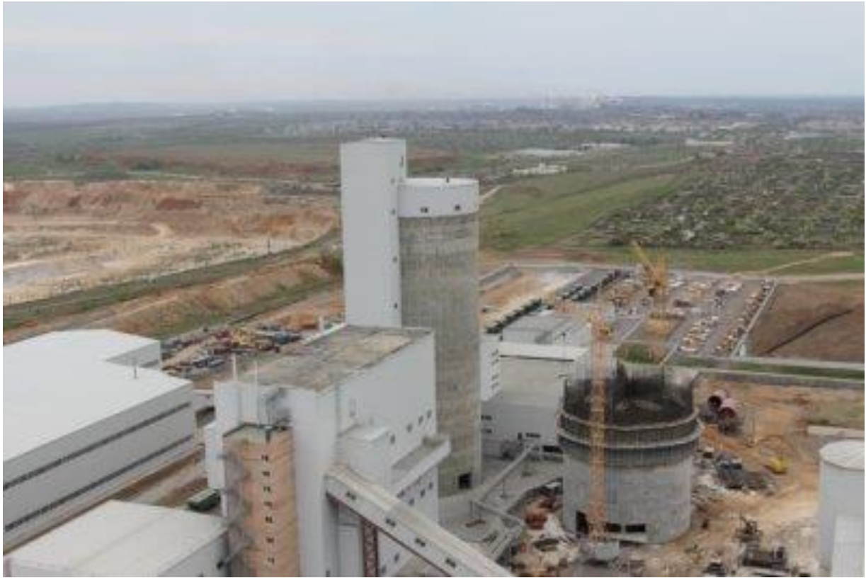
Многосекционный силос Новотроицкого цементного завода.
