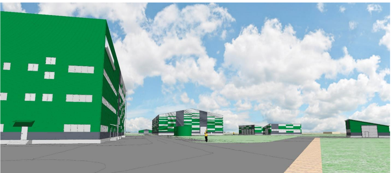
Мусоросортировочный завод в Раздольном г.Новосибирск.
