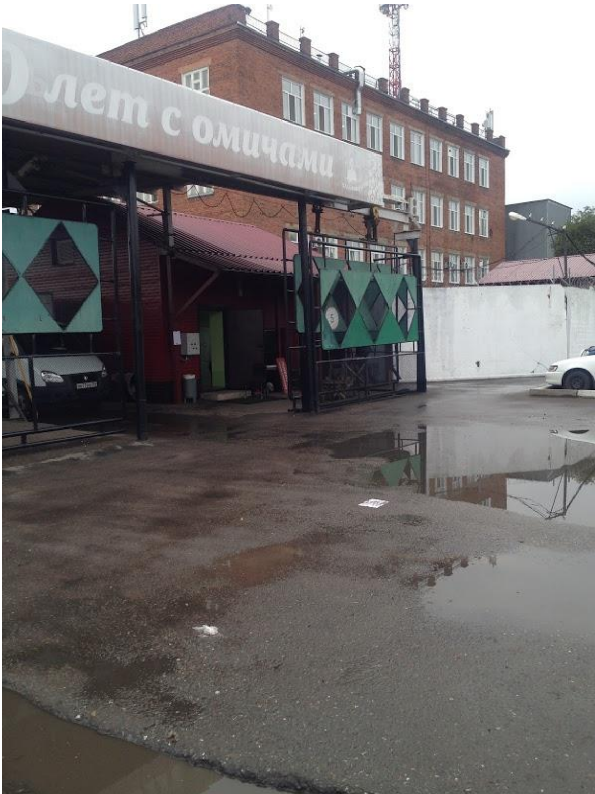
Реконструкция хлебозавода «Форнакс» г.Омск.
