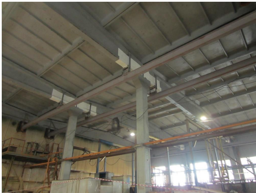
Рисунок 3.5. Общий вид средних колонн второго этажа
