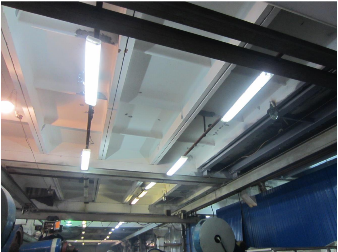
Рисунок 3.10. Общий вид плит перекрытия
