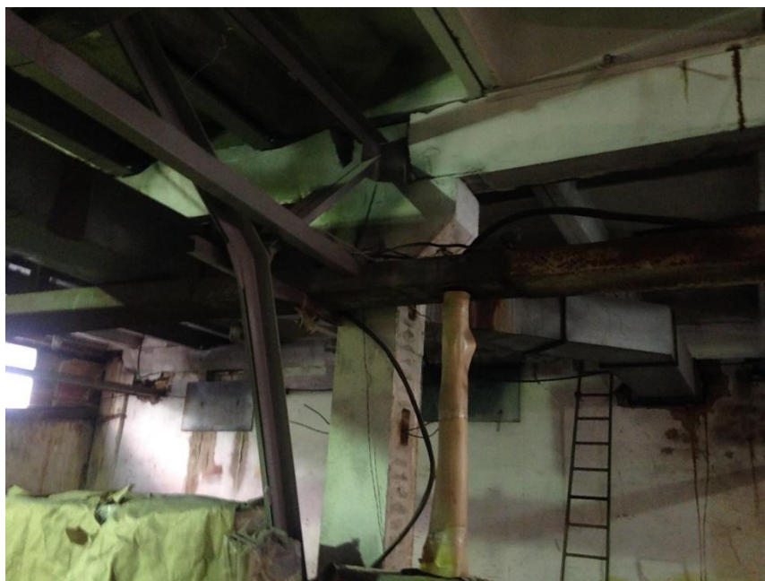
Рисунок 3.6. Общий вид средних колонн второго этажа
