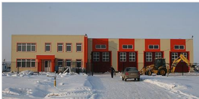
Пожарное депо и склад пенообразователя
