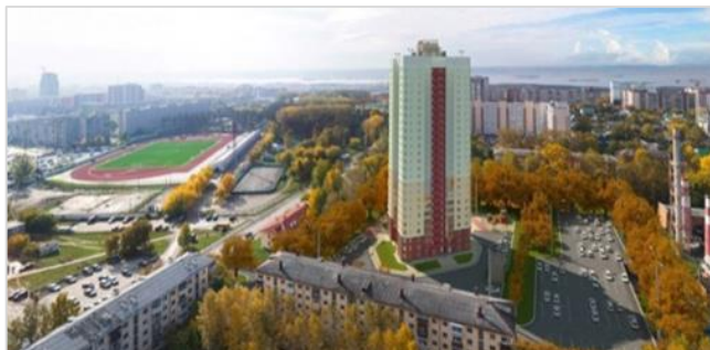
ЖД, ул. Расточная
