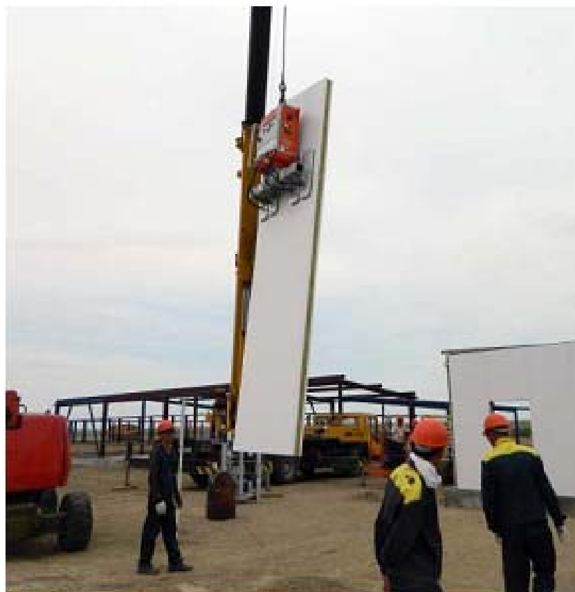
Рис. 5.5. Вакуумные присоски, зажимы рычажного или струбцинного типа.
