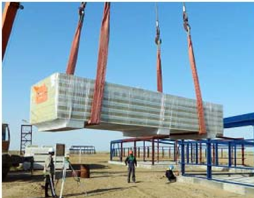
Рис. 5.4. Распорная рама или траверса.
