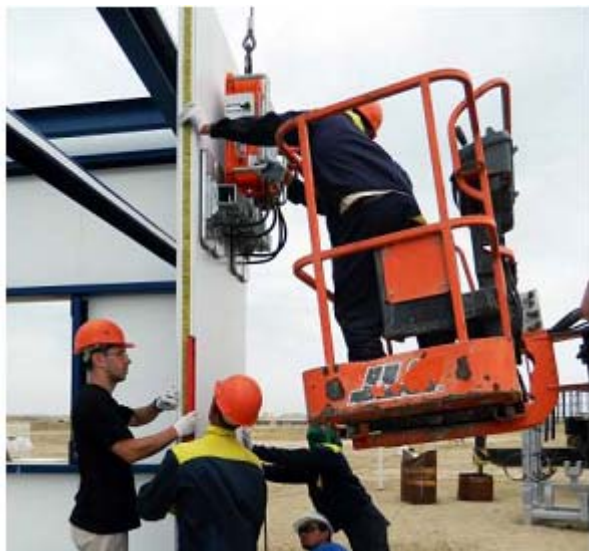
Рис. 5.9. Проверка строительным уровнем горизонтальности (вертикальности) кромки панели.
