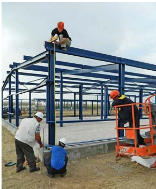
Рис. 5.6. Простановка отметок верха и низа панелей.
