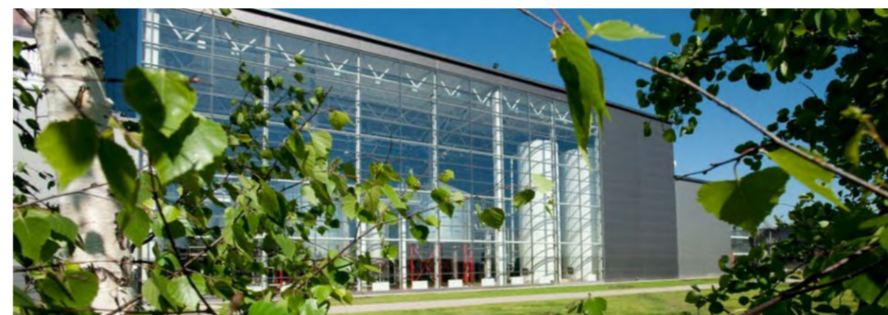
Пивоваренный завод МО, г. Мытищи. 9 500 кв.м
