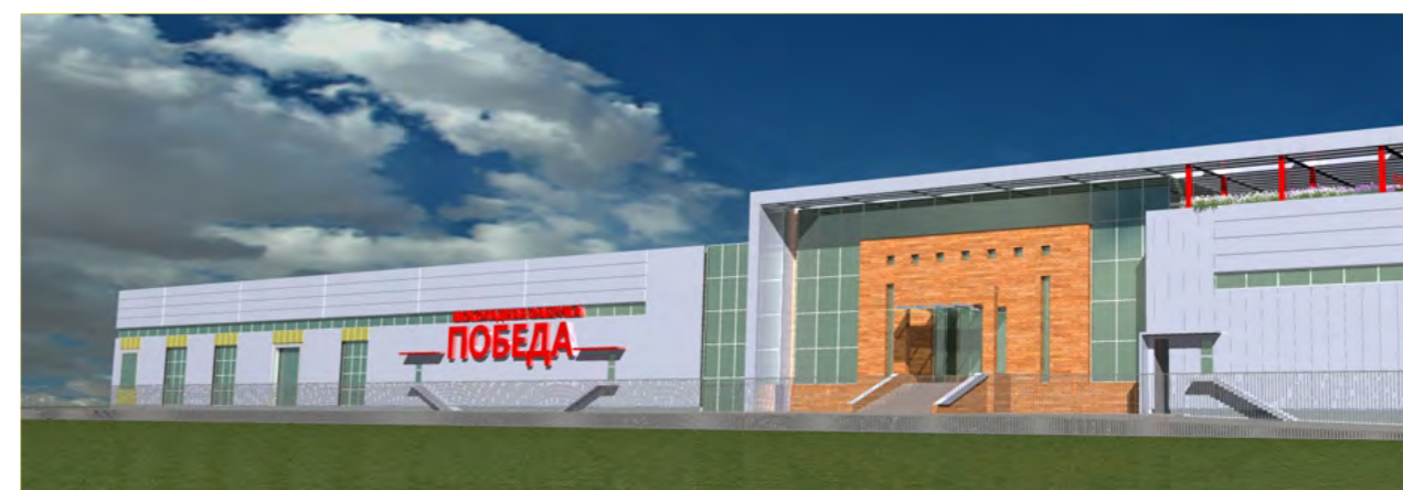
Кондитерская фабрика МО, г. Егорьевск. 17 000 кв.м
