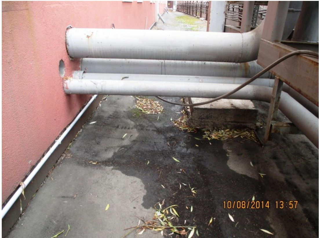
Фото №19. Застойные зоны асфальтобетонной отмостки.
