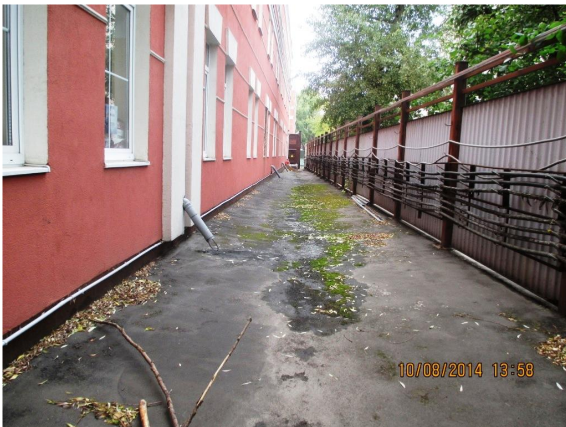
Фото №21. Трещины в асфальтобетонной отмостке.
