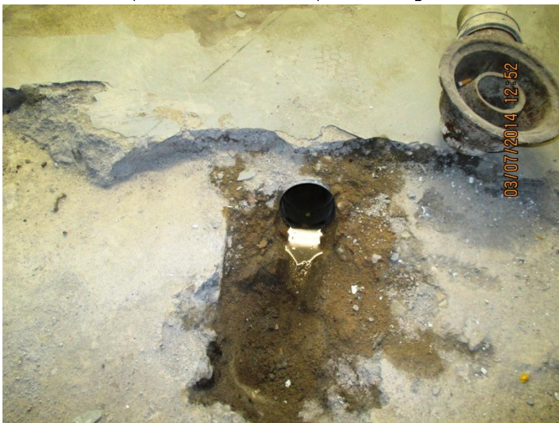
Фото №17. Следы сырости наружной стены подземной автостоянки в месте прохождения инженерных коммуникаций.
