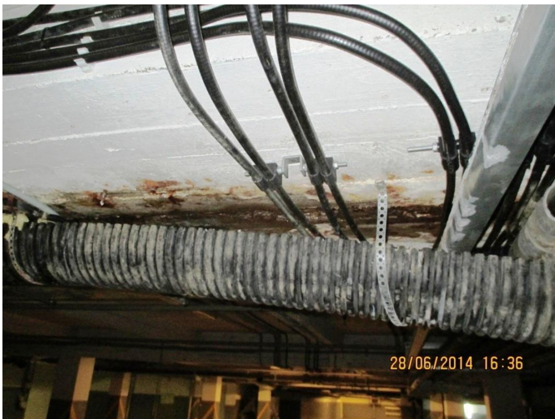
Фото №15. Деформационный шов плиты перекрытия над подземной автостоянкой.
