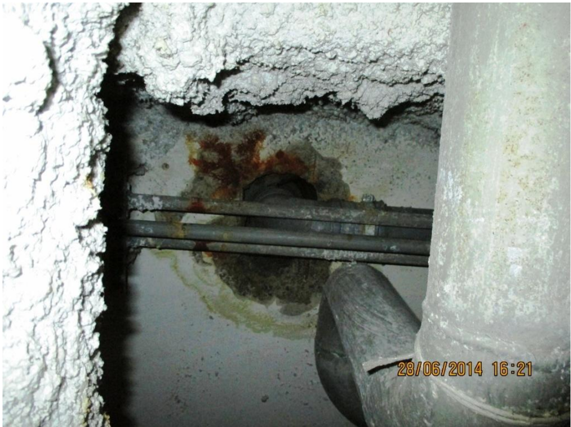
Фото №13. Разрушение плиты перекрытия над подземной автостоянкой в месте прохождения инженерных коммуникаций.
