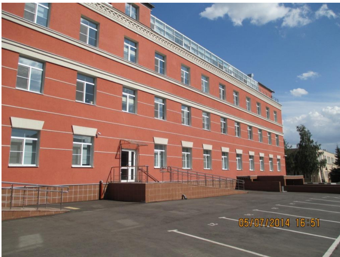
Фото №1. Фасад стр. 22, 23 по оси "1".
