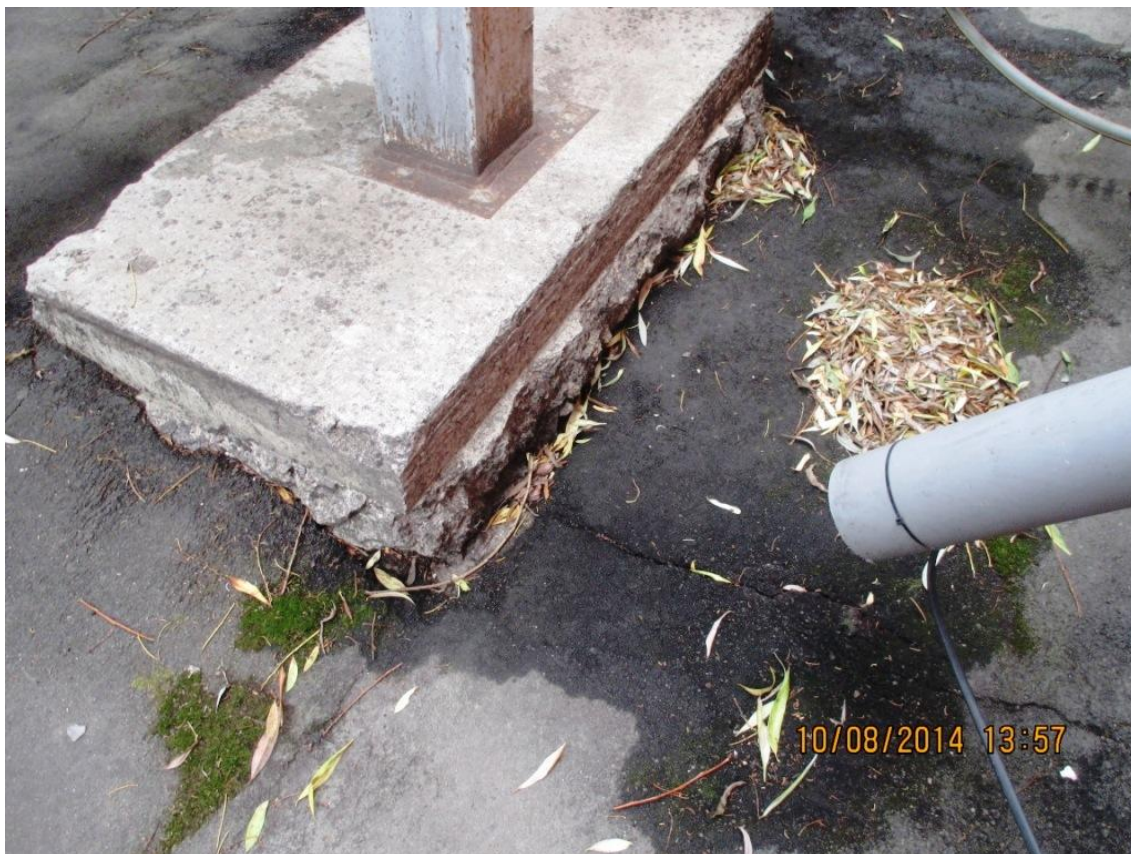
Фото №21. Трещины в асфальтобетонной отмостке.
