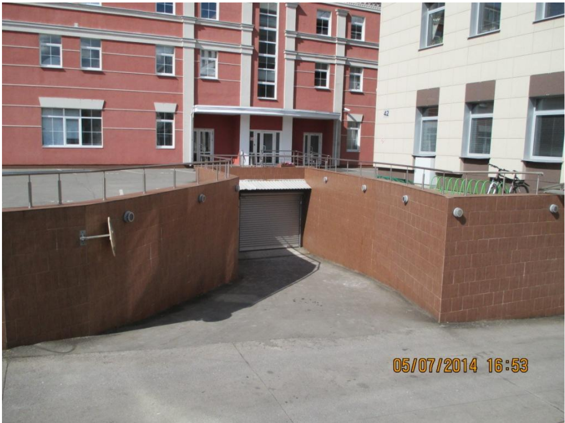
Фото №4 Въезд на подземный паркинг стр. 19, 20.
