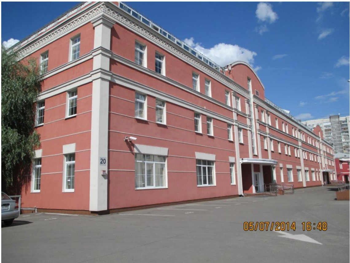
Фото №3. Фасады стр. 19, 20 по осям "12" и "К".
