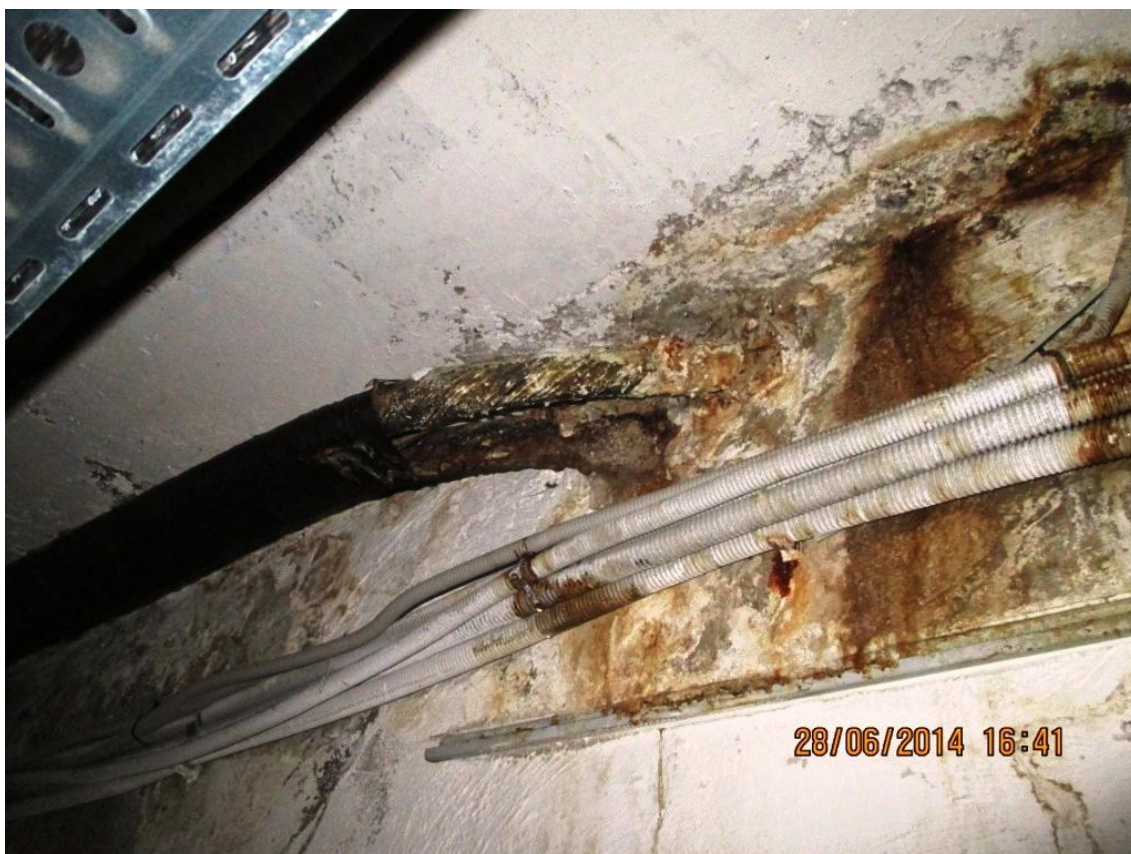
Фото №17. Следы сырости наружной стены подземной автостоянки в месте прохождения инженерных коммуникаций.
