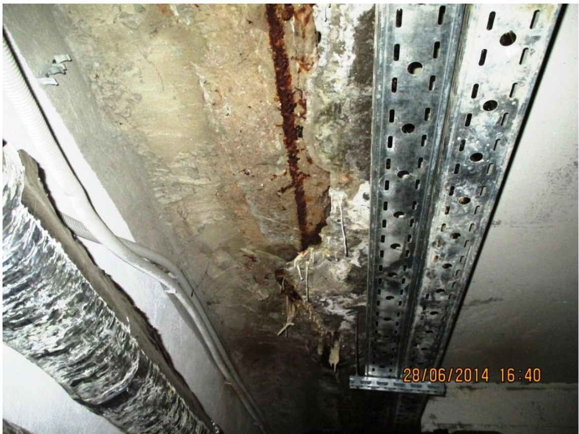
Фото №13. Разрушение плиты перекрытия над подземной автостоянкой в месте прохождения инженерных коммуникаций.
