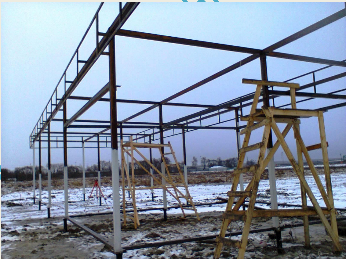
Рисунок 4. Промежуточный фотоотчет о выполненных работах
