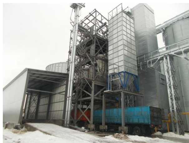
Рисунок №2 – Общий вид обследуемых сооружений
