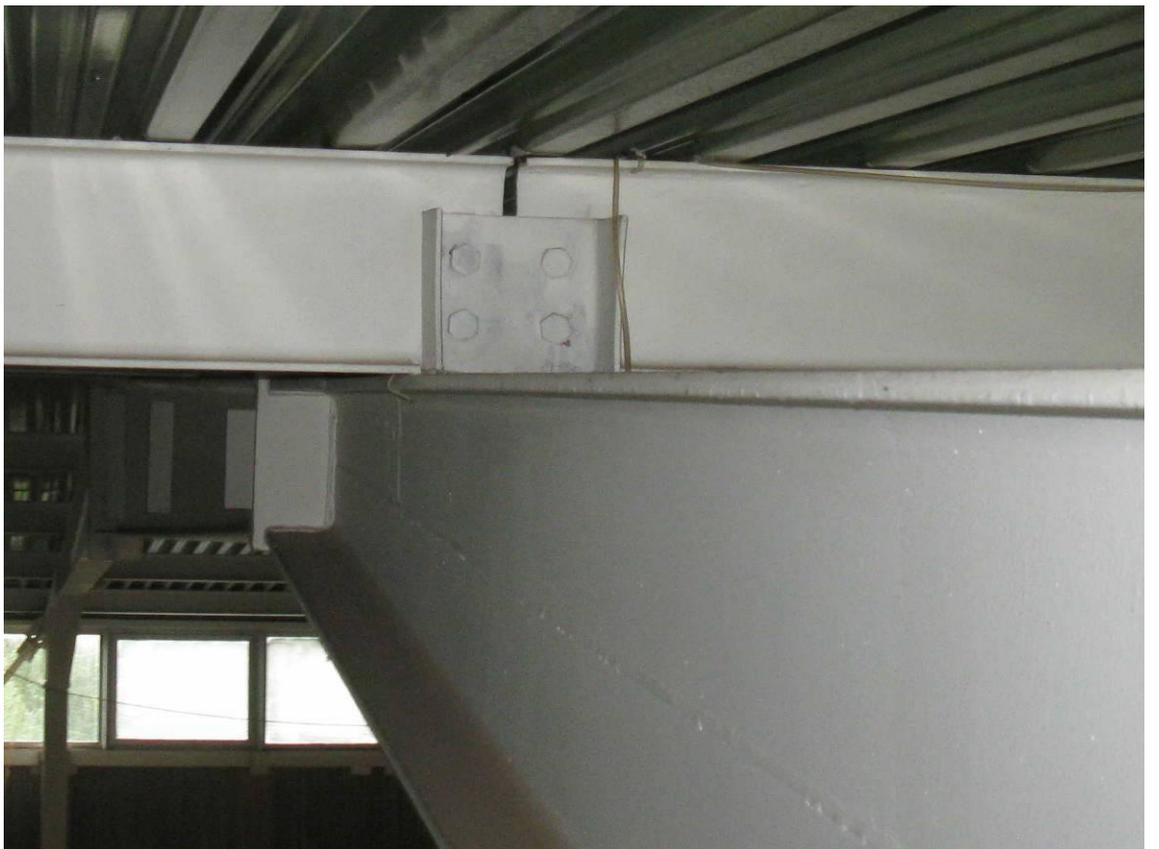
Общий вид соединения балок Б1 и ригеля Ф1
