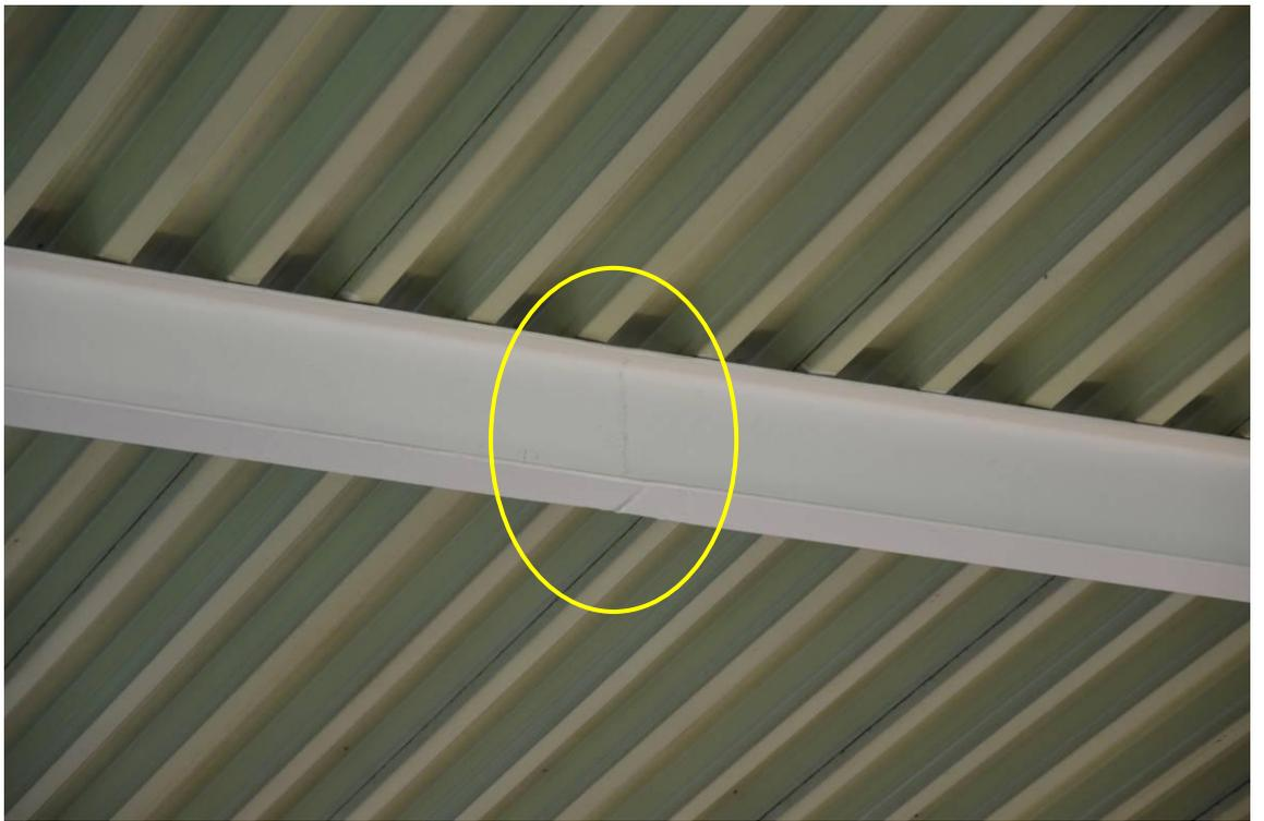
Общий вид соединения балок Б1 между собой в пролете
